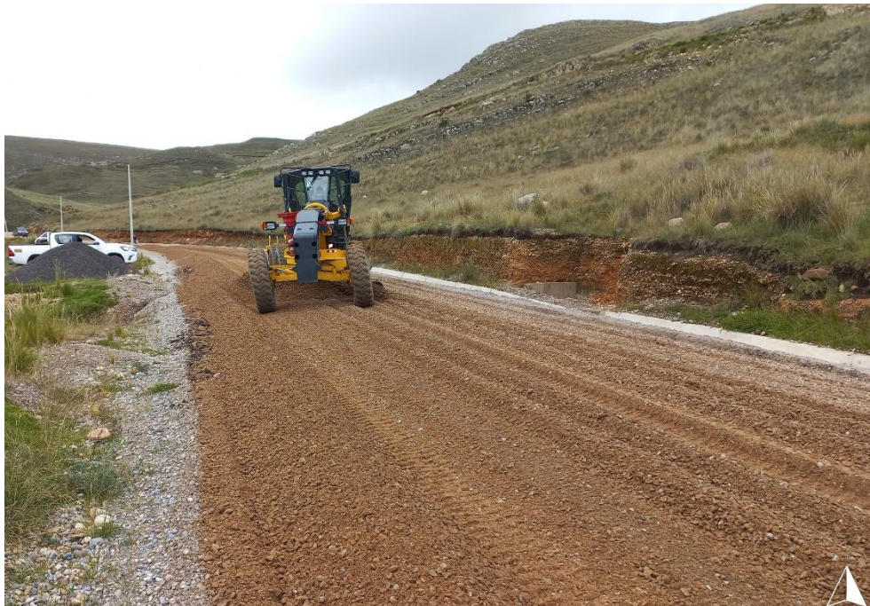
Figura 13. Escarificado Fuente: Elaboración propia
