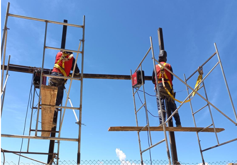
Figura 37. Verificación de uso de arnés
