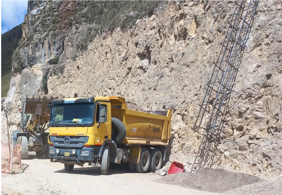
Figura 31. Trabajo con maquinaria pesada, cargador frontal y volquete Fuente: Elaboración propia
