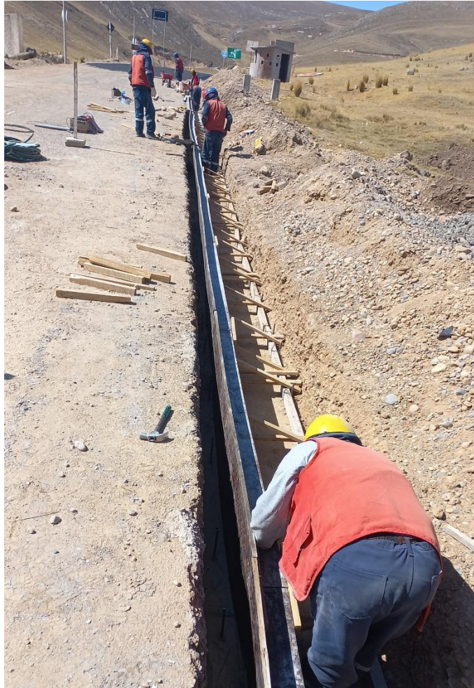
Figura 11. Encofrado de cunetas
