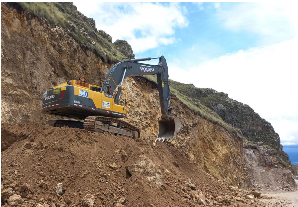
Figura 30. Trabajo con maquinaria pesada excavadora
