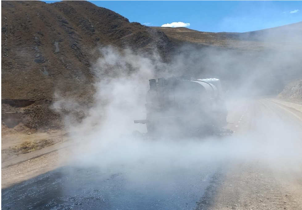
Figura 15. Imprimación asfáltica
