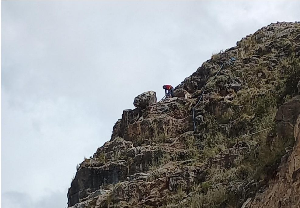
Figura 29. Trabajo en altura - Demolición de estructuras
