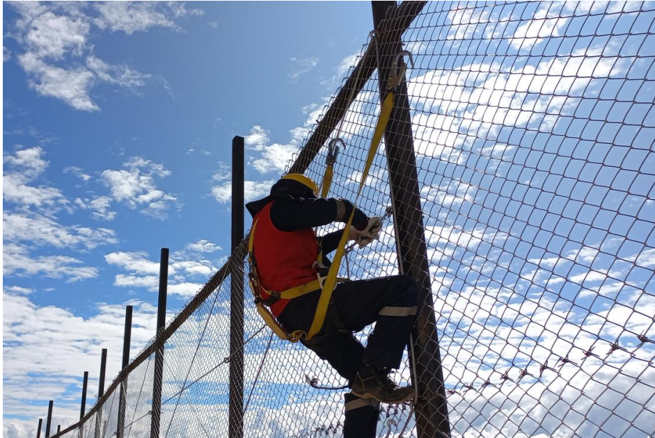
Figura 27. Trabajo en altura para malla de contención
