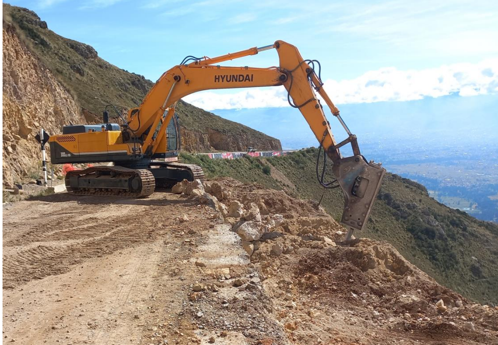
Figura 6. Excavadora con martillo en demolición de estructuras Fuente: Elaboración propia
