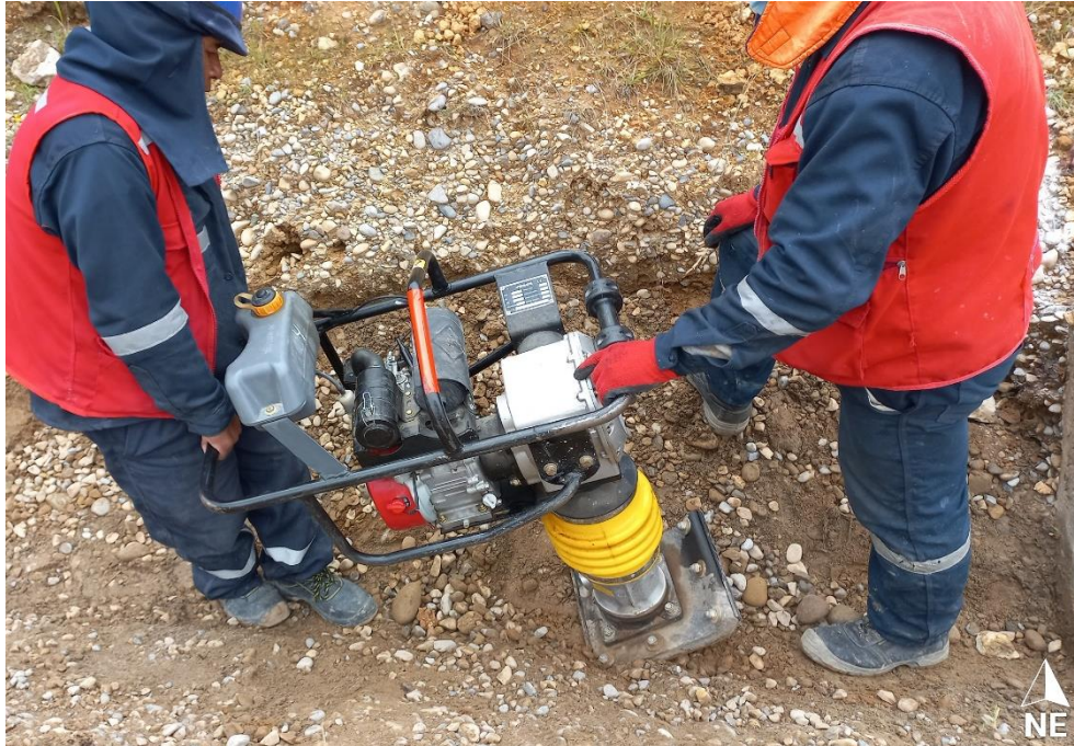
Figura 10. Compactado de terreno
