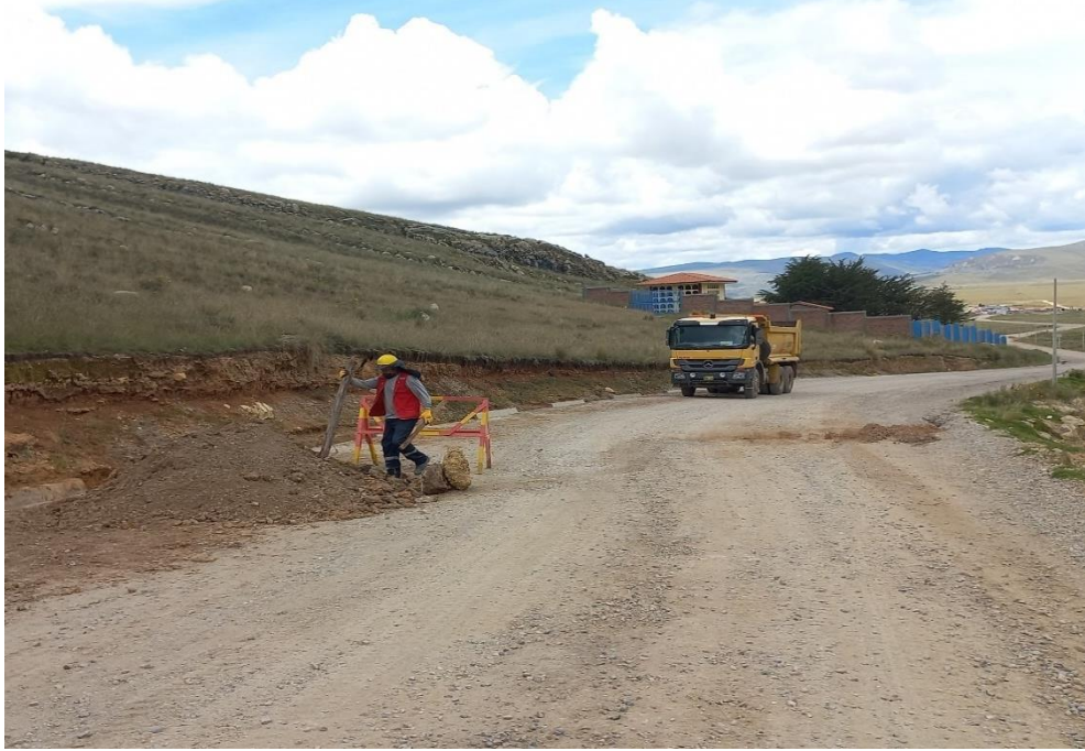
Figura 4. Demolición de material existente Fuente: Elaboración propia
