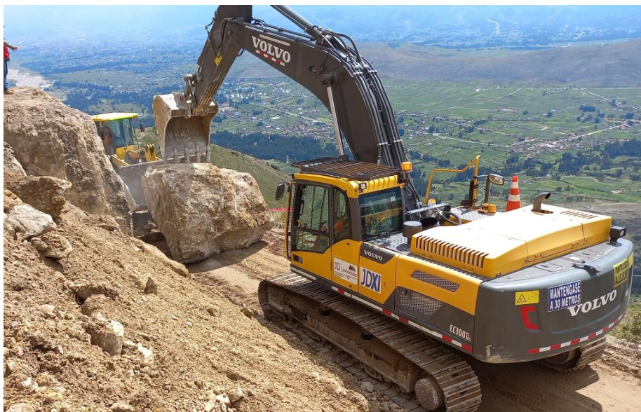
Figura 39. Verificación en trabajos con maquinarias pesadas
