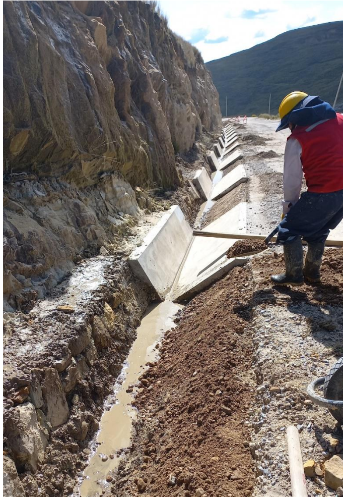
Figura 7. Habilitación de terreno
