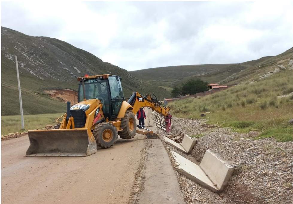
Figura 3. Demolición de estructuras con retroexcavadora
