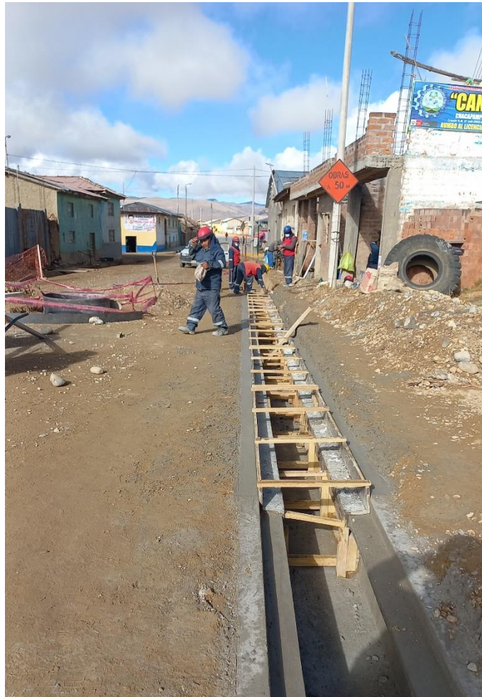
Figura 12. Acabado de cunetas
