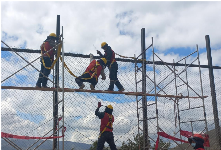
Figura 28. Trabajo en altura andamios
