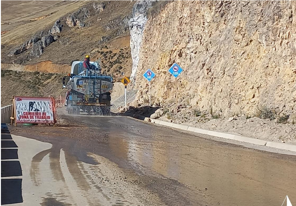
Figura 18. Irrigación de carretera
