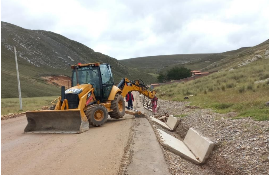
Figura 35. Vigía de maquinaria de excavadora
