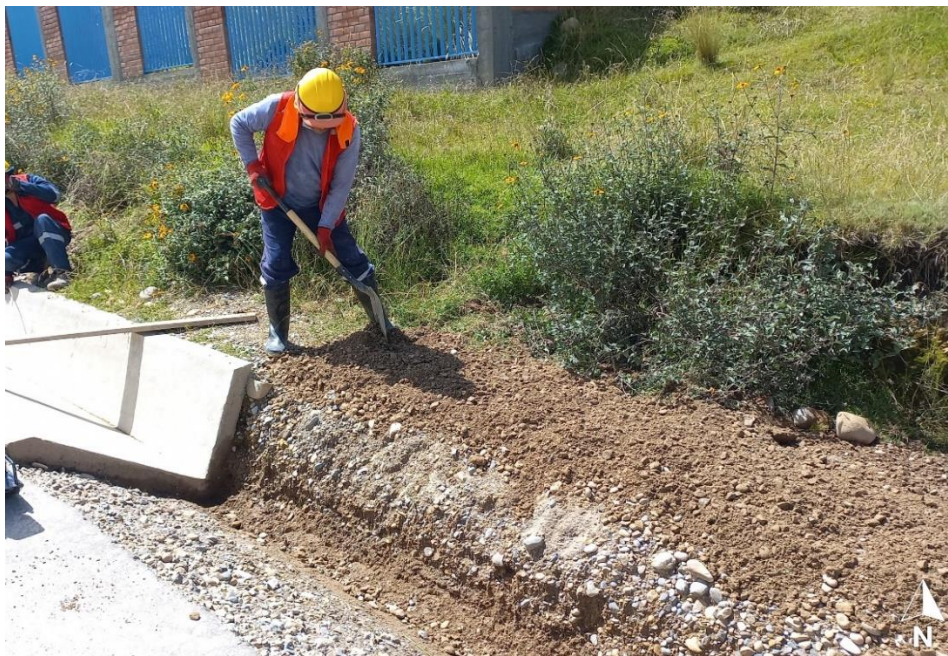
Figura 9. Conformado de terreno
