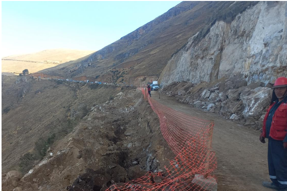
Figura 34. Señalización trabajo en altura Fuente: Elaboración propia
