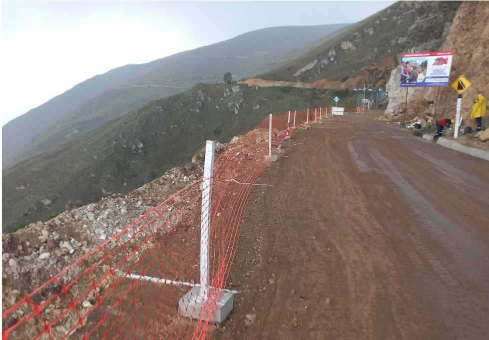
Figura 25. Señalización en buen estado
