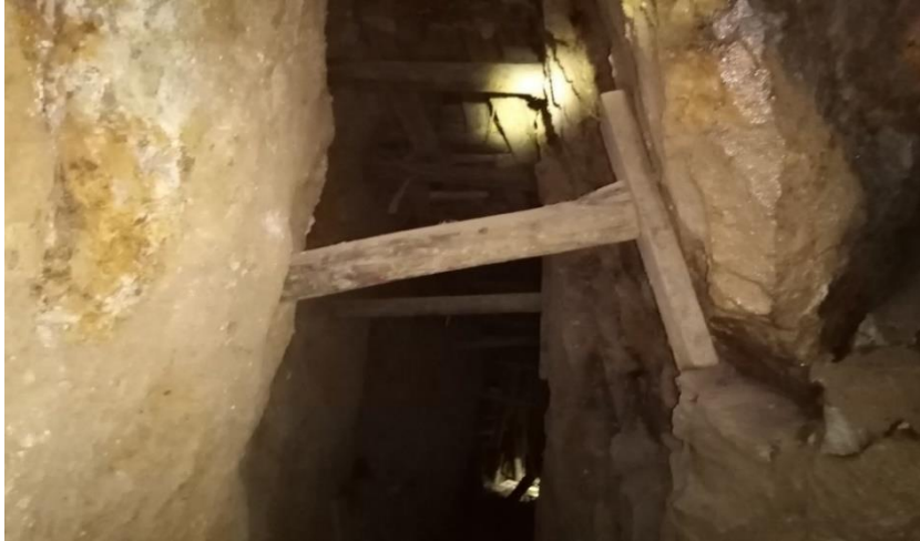
Figura 8. Tajo 486 SE con puntal de seguridad. Fuente: Elaboración Propia
