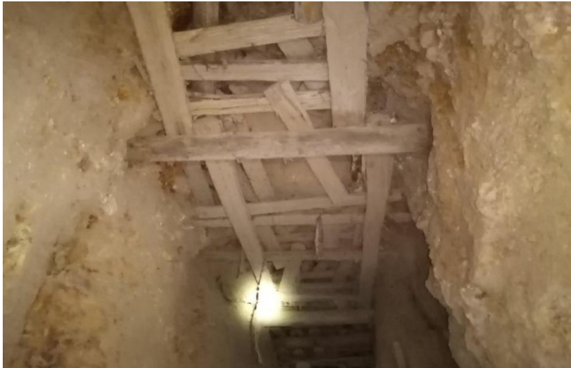
Figura 9. Tajo 486 NW con puntal en línea. Fuente: Elaboración Propia.
