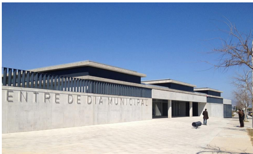
Figura 9. Fachada e ingreso principal.
