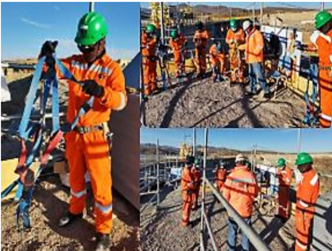
Fotografía 10. Capacitación sobre el uso y check list del arnés de seguridad con personal de andamios – Set 2021
