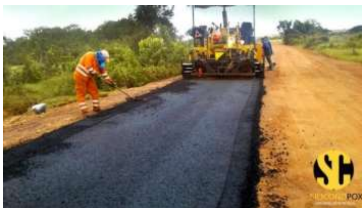
Figura 14: Estabilización con asfalto
