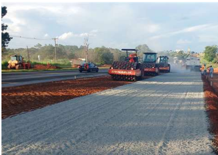
Figura 13: Estabilización con cemento
