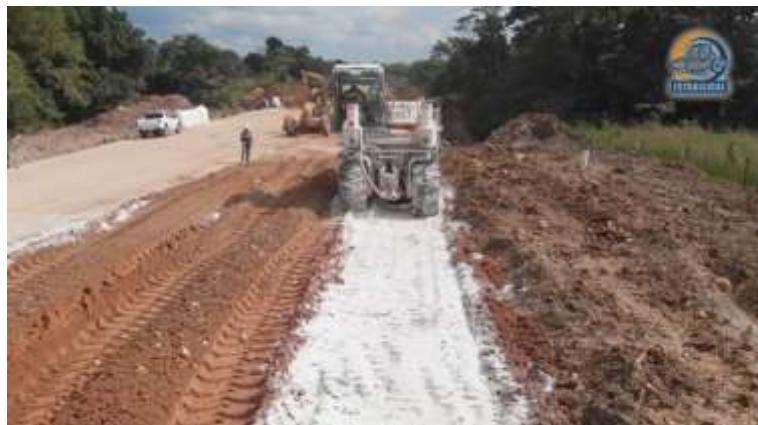
Figura 12: Estabilización con cal
