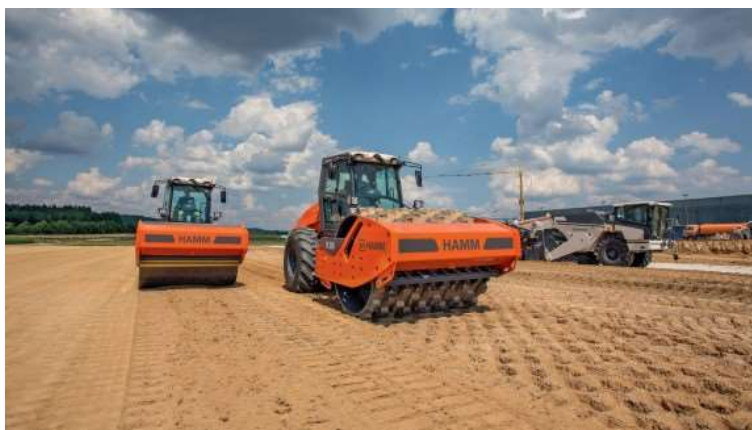
Figura 15: Estabilización por compactación
