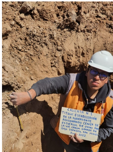
Figura 59 Exploración de la Calicata 1
