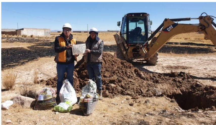
Figura 60 Exploración de la Calicata 2
