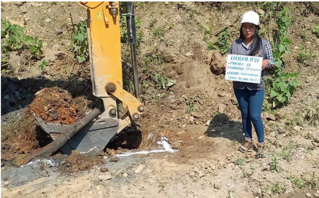
Fotografía 4. Excavación calicata N° 01 - Progresiva 16+100.
