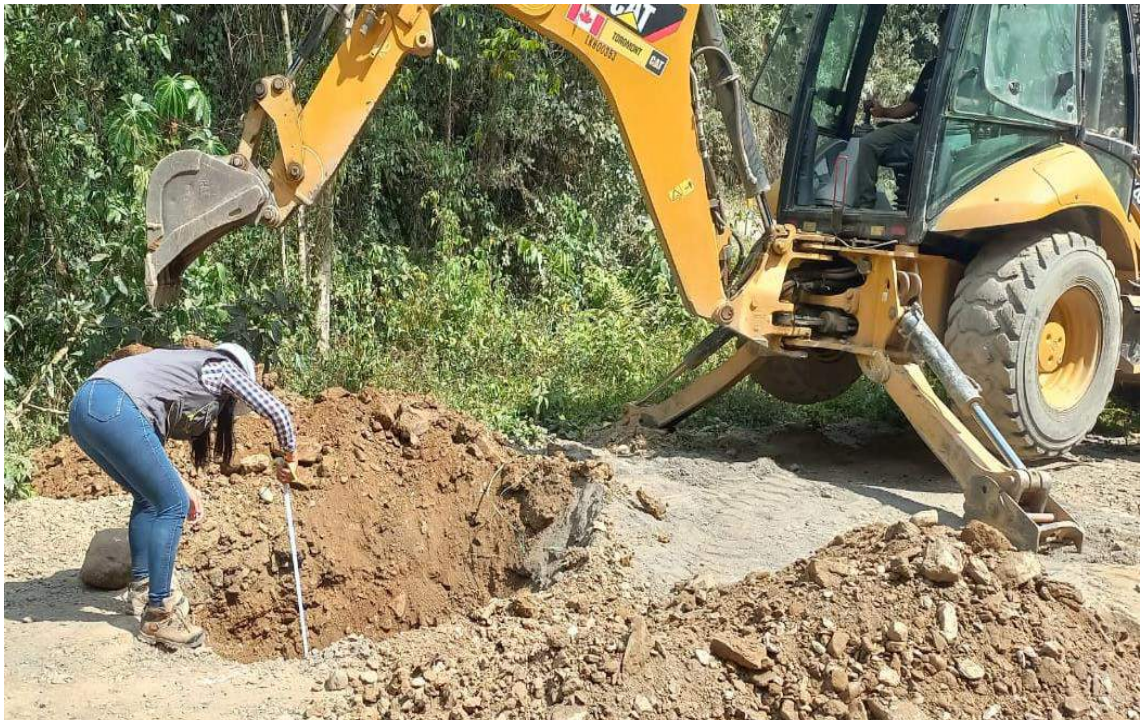
Fotografía 6. Excavación calicata N° 02 - Progresiva 17+200.
