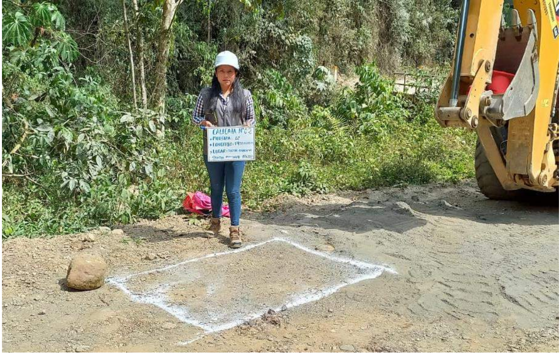
Fotografía 5. Calicata N° 02 - Progresiva 17+200.
