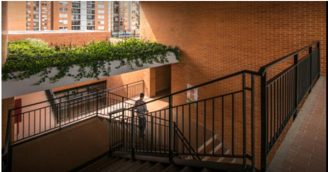
Figura 36 Muros de ladrillo caravista
