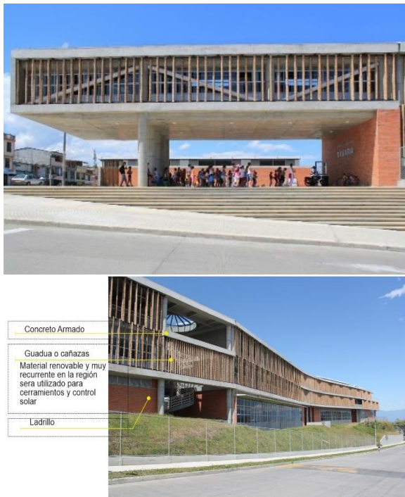
Figura 53 Sistema constructivo - fachada
