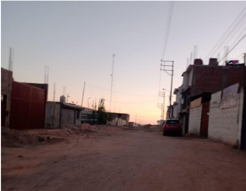
Figura 27 vías principales aún en proceso de pavimentación.
