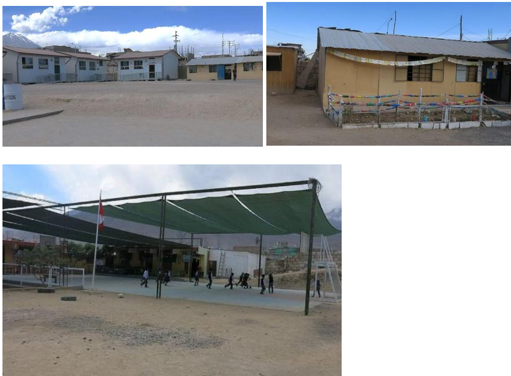
Figura 95 Vista del interior del colegio Peruarbo-40705
