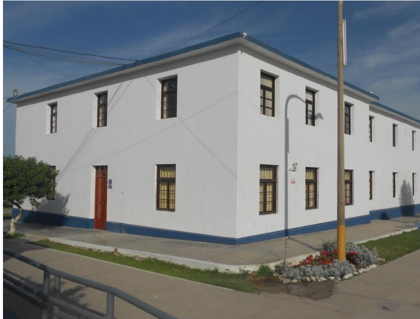
Figura N.º 36: Pabellón de Administración en la UNAM
