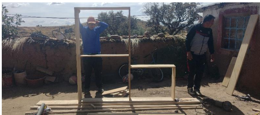
Ilustración 3 Habilitación de marco de Muro Trombe.
