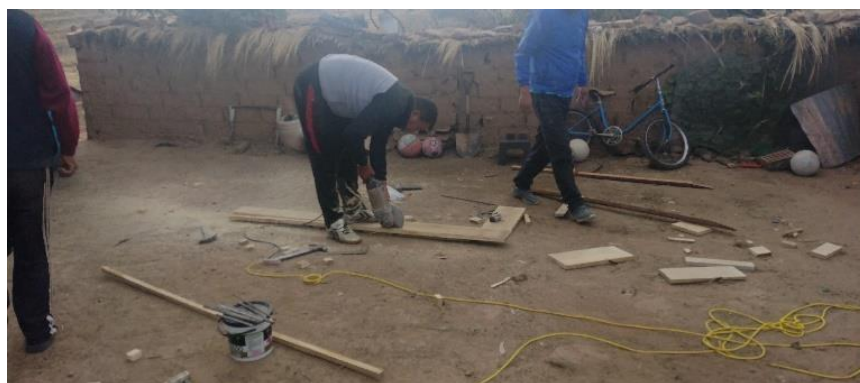
Ilustración 2 Cortado y habilitado de material para la construcción de Muro Trombe.
