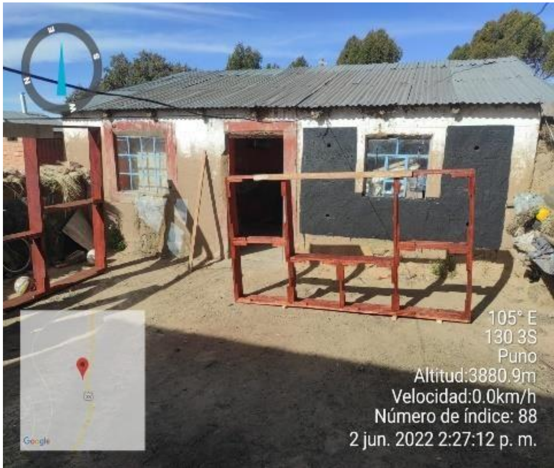
Figura 25. Forma de la estructura de madera
