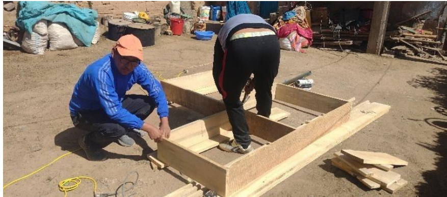
Ilustración 4 Colocación de pestañas para el sostenimiento de vidrios
