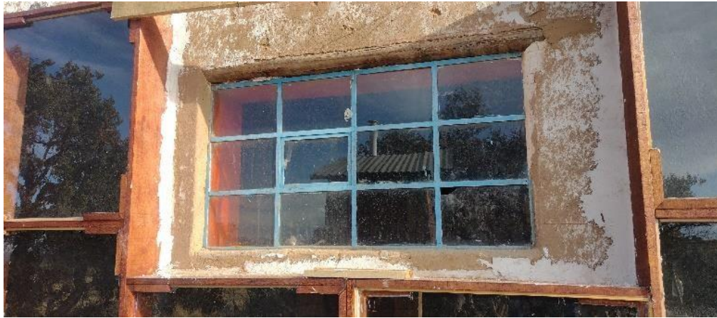
Ilustración 8 Sellado de las aberturas con yeso entre el marco de madera del Muro Trombe con la pared de adobe.
