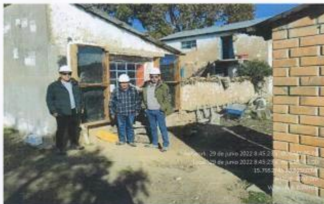
FOTOGRAFIA 2: SE CONTEMPLA QUE SE ENCUENTRA FUNCIONAMIENTO OPTIMO CON EL MURO TROMBE FAVORECIENDO A LA PROPIETARIA DE LA VIVIENDA.
