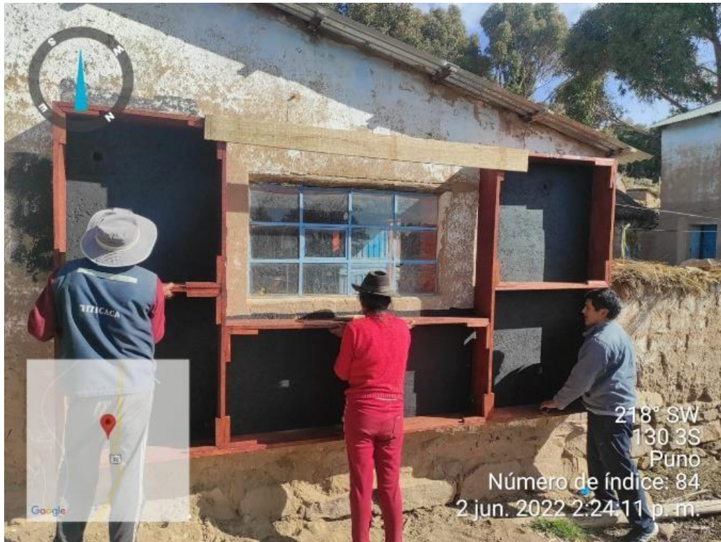
Figura 26. Colocación del bastidor
