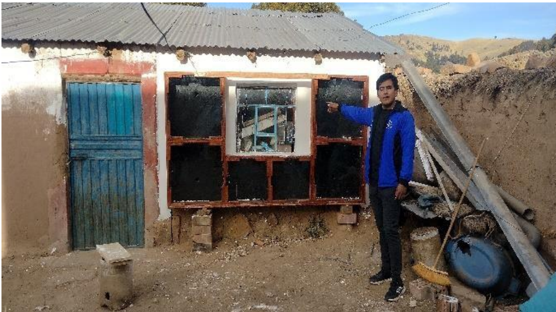
Figura 32. Muro principal sellado
