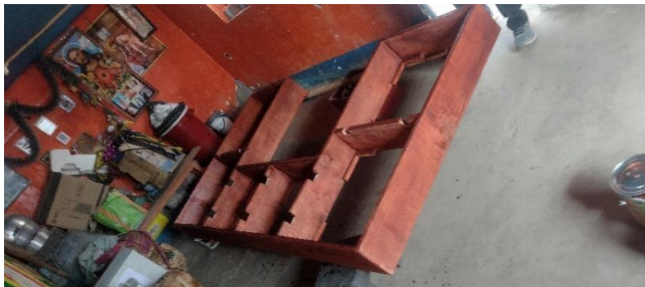
Ilustración 5 Barnizado del Marco del Muro Trombe
