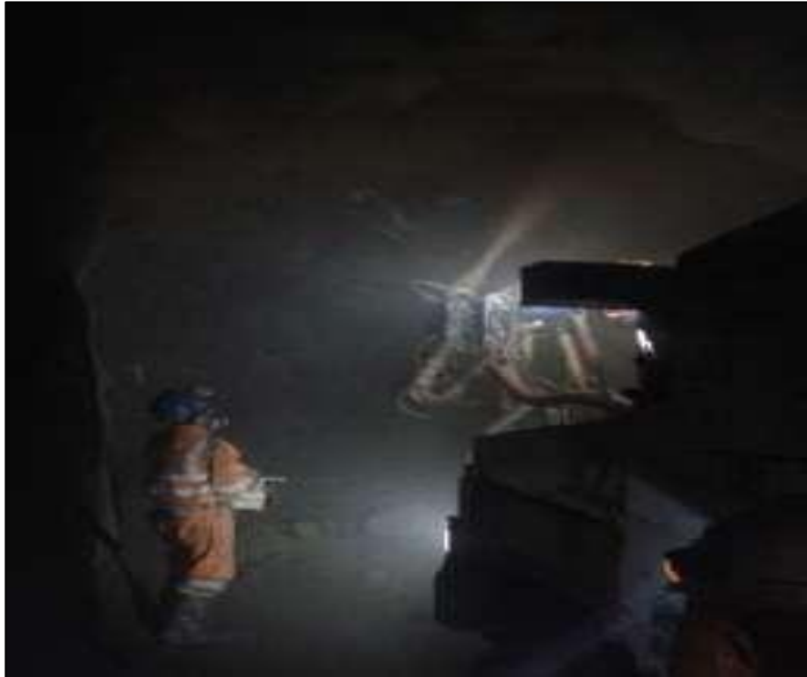
Figura N. 20. Lanzado de concreto con el Robot Alpha20, perteneciente a E.E.
