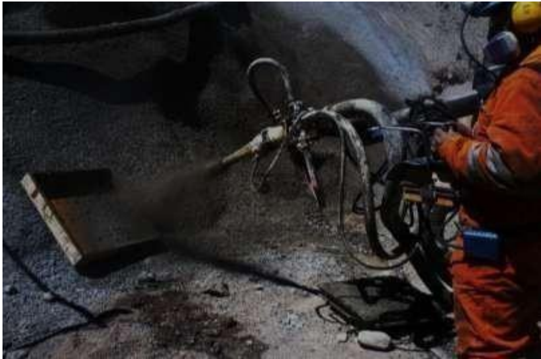
Figura N. 13. Proceso de lanzado de concreto en el molde de Panel para Ensayos
