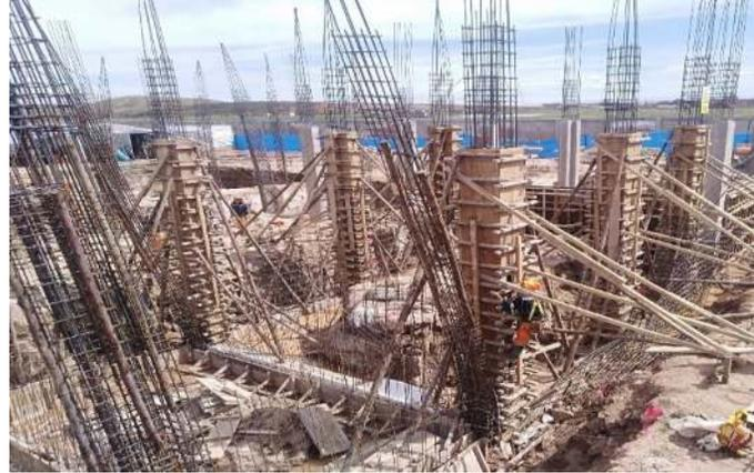
*Figura 16. Actividad encofrada de madera para columna.*
