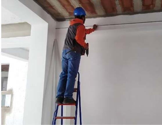
*Figura 82. Colocación de perfiles para el soporte de la baldosa de fibra mineral  $e=5/8''$*
