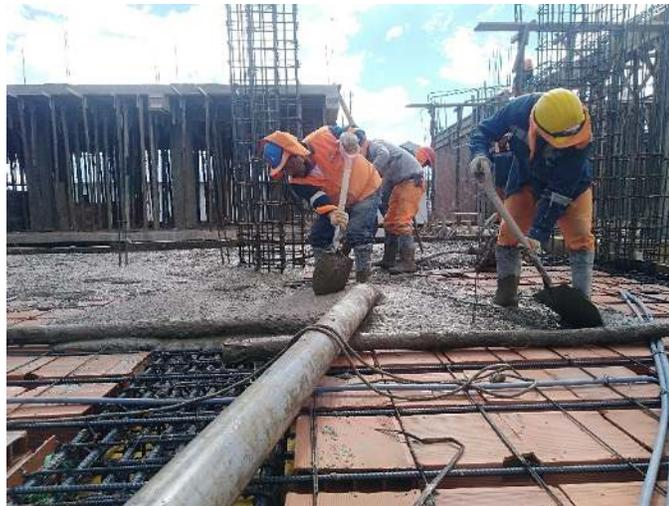
*Figura 30. Actividad de colocado de Concreto Pre Mezclado para losa aligerada.*
