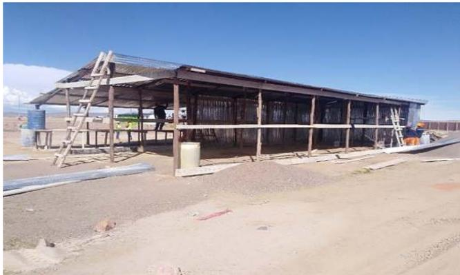
*Figura 47. Ejecución del almacén general de obra.*
