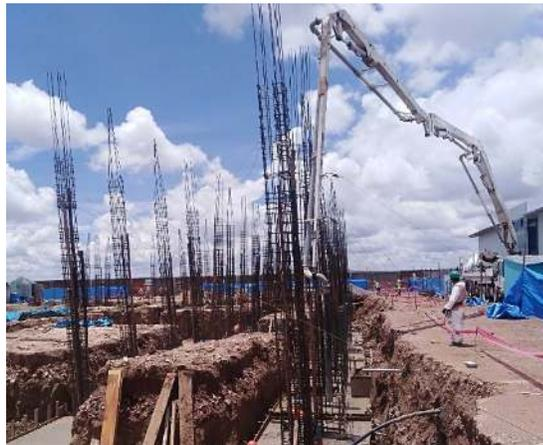
*Figura 15. Actividad Colocado de concreto pre mezclado para viga de cimentación.*
