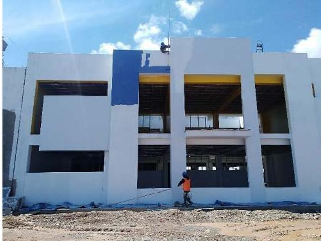
*Figura 80. Pintado de muros exteriores.*
