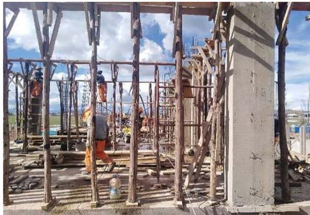
*Figura 66. Se aprecia el encofrado de fondo de vigas.*
