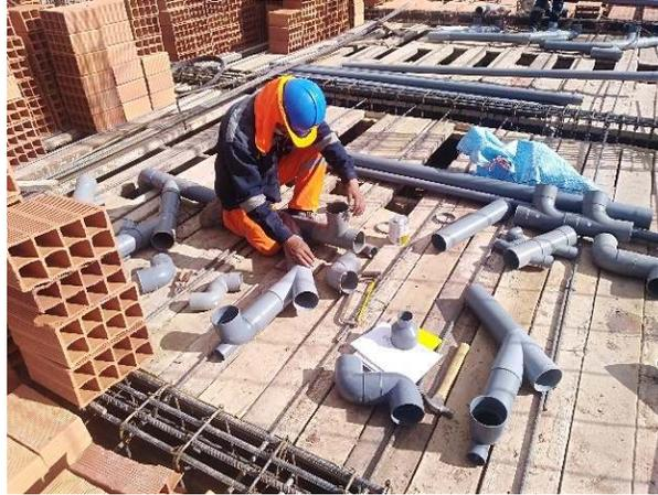
*Figura 70. Instalación de tuberías de desagüe*
