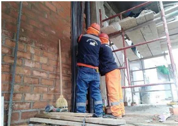
*Figura 32. Actividad de instalación de tubo de luz en muros.*
