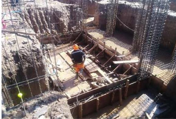
*Figura 14. Actividad Encofrado de madera para en viga de cimentación.*
