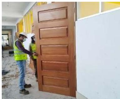
*Figura 40. Se realiza la verificación de puertas de madera tornillo.*
