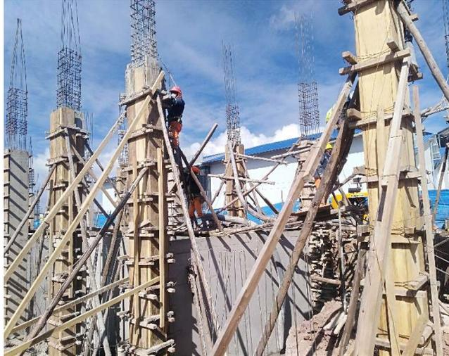
*Figura 63. Se aprecia el encofrado de Columna del primer nivel.*
