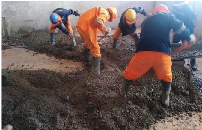
*Figura 23. Actividad de colocado de concreto en Falso Piso.*
