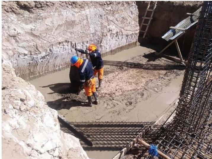
*Figura 54. Vaciado de solado para zapatas  $e=4''$ .*
