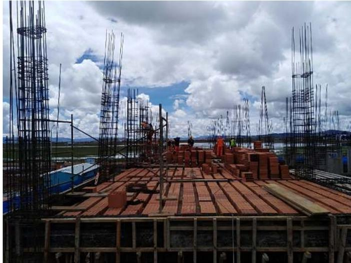
*Figura 27. Actividad de colocado de ladrillo hueco para losa aligerada.*
