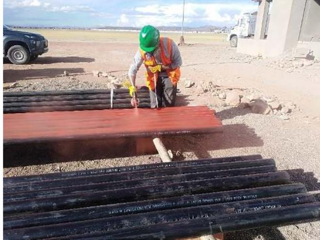
*Figura 78. Habilitación de tuberías SHC - 40 SCI 4"*
