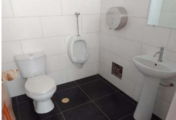
*Figura 86. Se muestra los aparatos sanitarios de porcelana con sus respectivos grifos de agua.*
