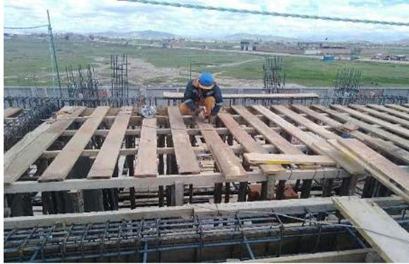
*Figura 68. Se muestra el encofrado de losa aligerada  $e=20\text{cm}$ .*
