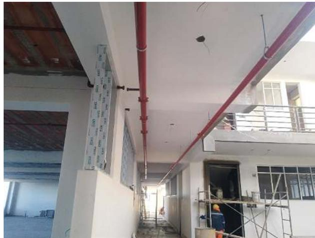
*Figura 79. Se muestra la Tuberías SHC – 40 SCI4"*
