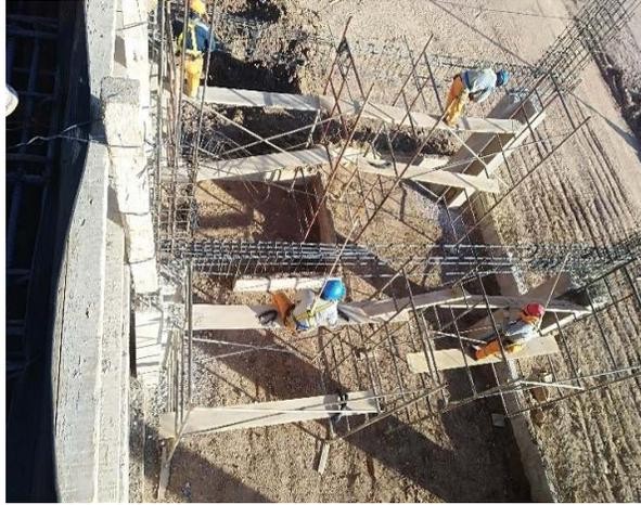
*Figura 67. Armado de acero de refuerzo  $f_y=4200 \text{ kg/cm}^2$  grado 60.*
