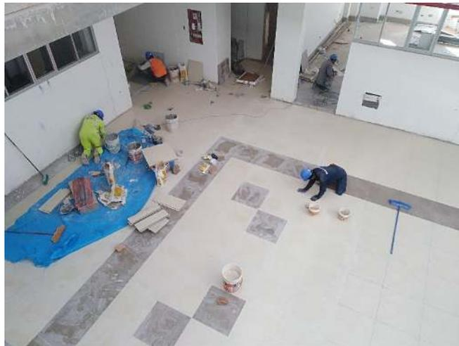
*Figura 81. Colocación de Porcelanato 0.60 x 0.60 m.*
