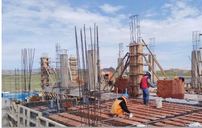
*Figura 72. Colocado de acero de temperatura.*
