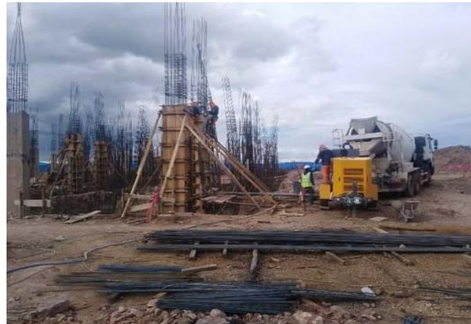
*Figura 17. Actividad colocada de concreto Pre mezclado para columna.*
