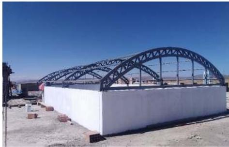
*Figura 39. Se aprecia la cobertura metálica del Lucernario.*
