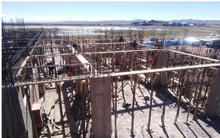
*Figura 24. Actividad de encofrado de madera para vigas.*
