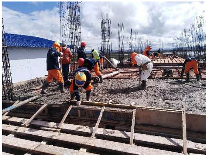
*Figura 73. Vaciado de concreto premezclado  $f'c=280 \text{ kg/cm}^2$  mediante bomba estacionaria.*
