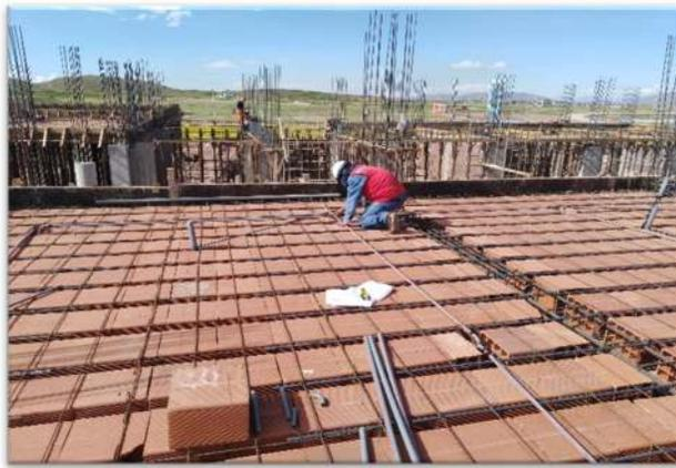
*Figura 71. Instalación de tubo de electricidad*
