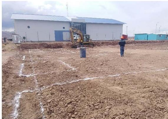
*Figura 49. Trazo y replanteo de los diferentes bloques*
