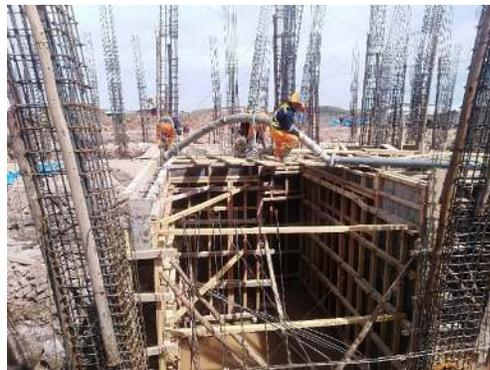
*Figura 19. Actividad de colocado de concreto pre mezclado sobrecimiento reforzado.*
