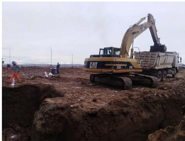
Figura 52. Se muestra la excavación de zapatas.
