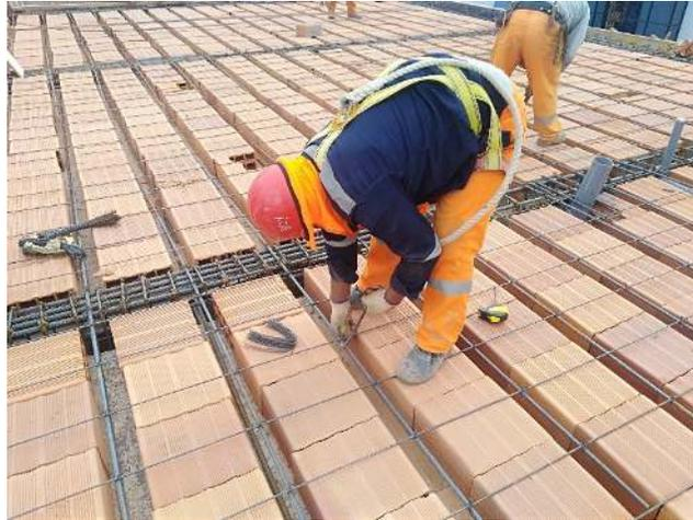
*Figura 28. Actividad de habilitación de acero de refuerzo en losa aligerada.*
