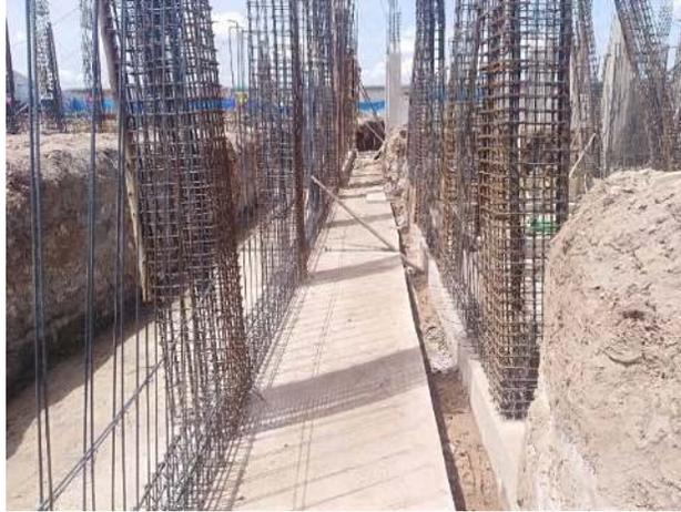
*Figura 59. Acero de refuerzo en viga de cimentación y sobrecimiento reforzado*
