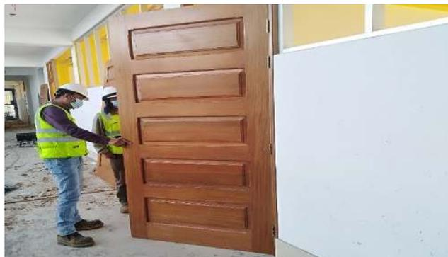
*Figura 85. Verificación de la puerta de madera tornillo de tablero rebajado*
