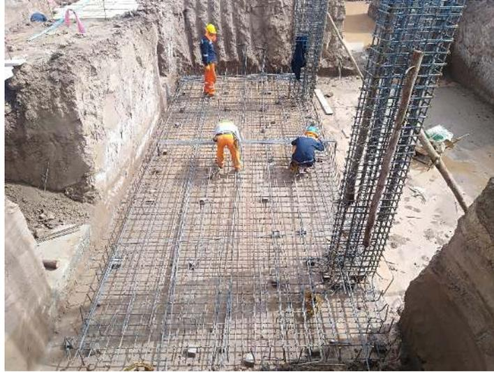
*Figura 55. Armado de acero de refuerzo para zapata combinada in situ.*
