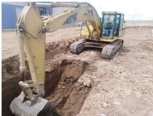
*Figura 7. Actividad de excavación masiva para zapata*
