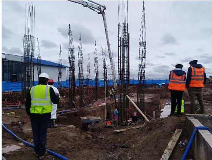
*Figura 58. Vista del vaciado de concreto Premezclado  $f'c = 210 \text{ kg/cm}^2$  en zapata.*
