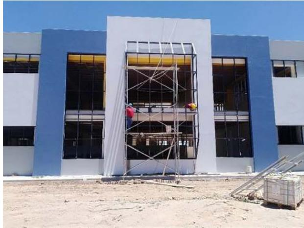
*Figura 41. Se muestra la instalación de vidrios templados en muro cortina.*
