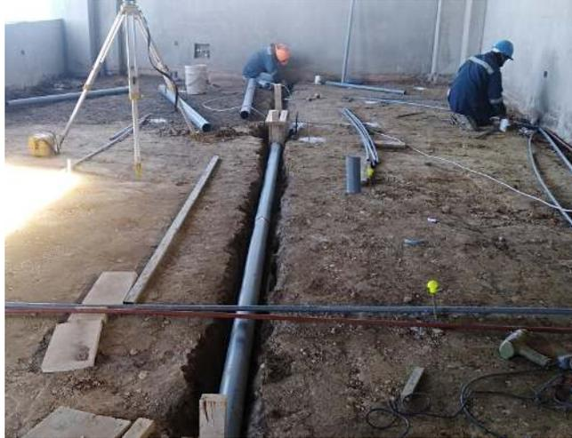
*Figura 21. Actividad de Instalación de tuberías de Agua y desagüe.*
