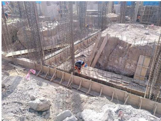
*Figura 60. Encofrado de madera en viga de cimentación.*
