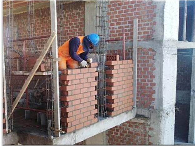
*Figura 74. Asentado de ladrillo mecanizado King Kong 18 huecos, J=1.5cm*
