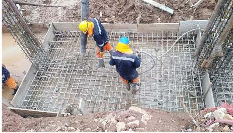
*Figura 11. Actividad Colocado de Concreto Pre mezclado para zapata.*
