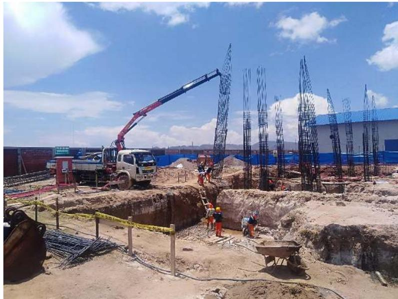
*Figura 56. Se muestra la colación del acero de refuerzo para zapata.*
