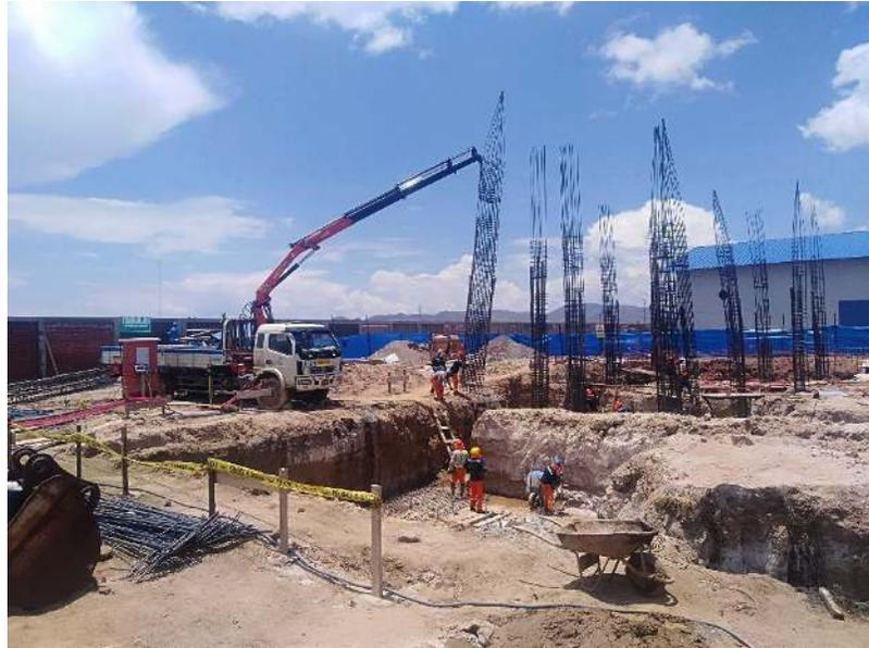
*Figura 10. Actividad Izaje de acero de refuerzo para columna.*
