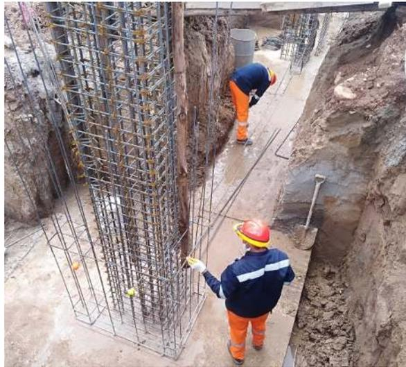
*Figura 12. Actividad habilitación de acero de refuerzo en viga de cimentación.*
