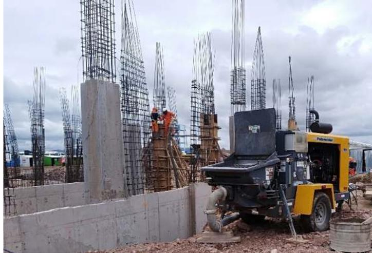
*Figura 65. Vaciado de concreto premezclado  $f'c= 280 \text{ kg/cm}^2$ . Con bomba estacionaria.*
