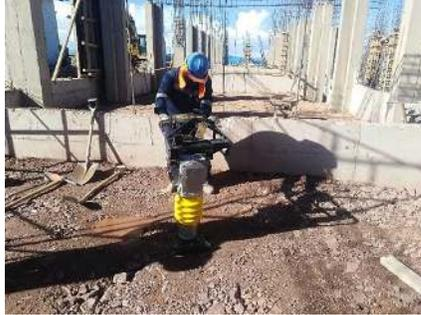
*Figura 20. Actividad de relleno y compactado utilizando material de préstamo.*
