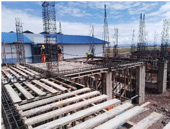
*Figura 26. Actividad de encofrado de madera para losa aligerada.*
