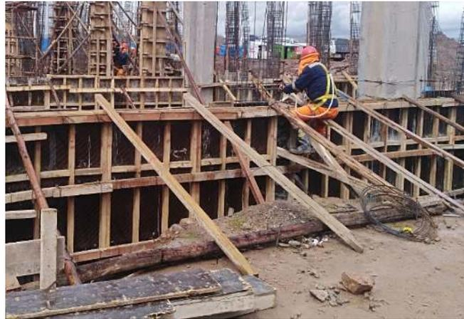
*Figura 18. Actividad de encofrado de madera para sobrecimiento.*
