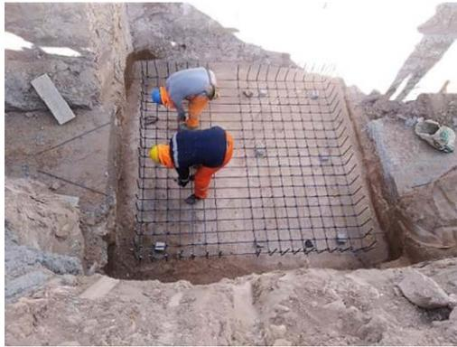
*Figura 8. Actividad de habilitación de acero de refuerzo para zapata*
