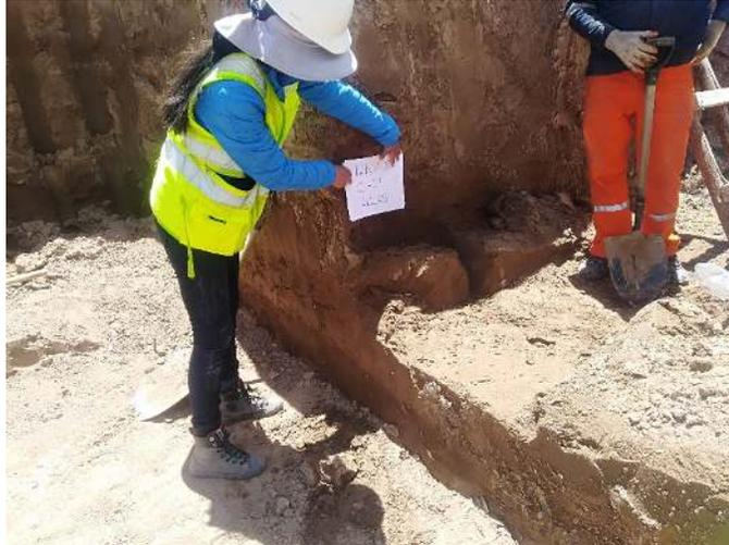
*Figura 53. Muestra inalterada del terreno para su respectivo diseño de corte el cual determinará la capacidad portante del terreno.*
