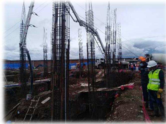
Figura 61. Vaciado de concreto pre mezclado  $f'c=210\text{kg/cm}^2$  en viga de cimentación mediante bomba telescópica.
