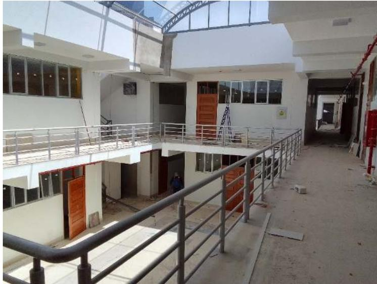
*Figura 83. Barandas metálicas en pasadizo  $h=1.00$  m.*
