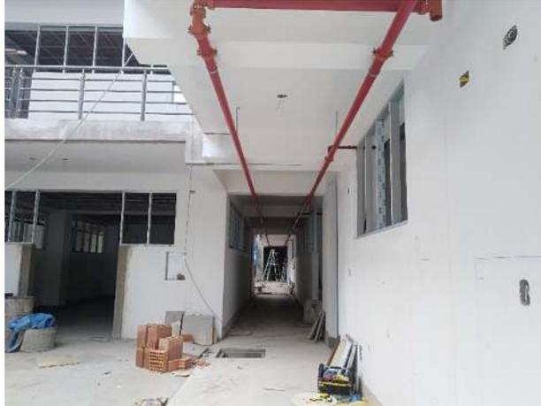
*Figura 37. Se aprecia las tuberías de Agua Contra Incendio.*
