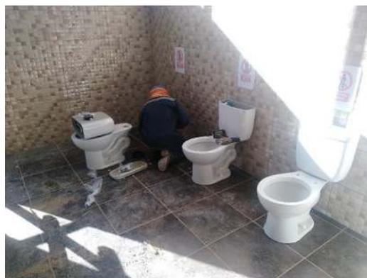
*Figura 42. Se realiza la instalación de aparatos sanitarios.*
