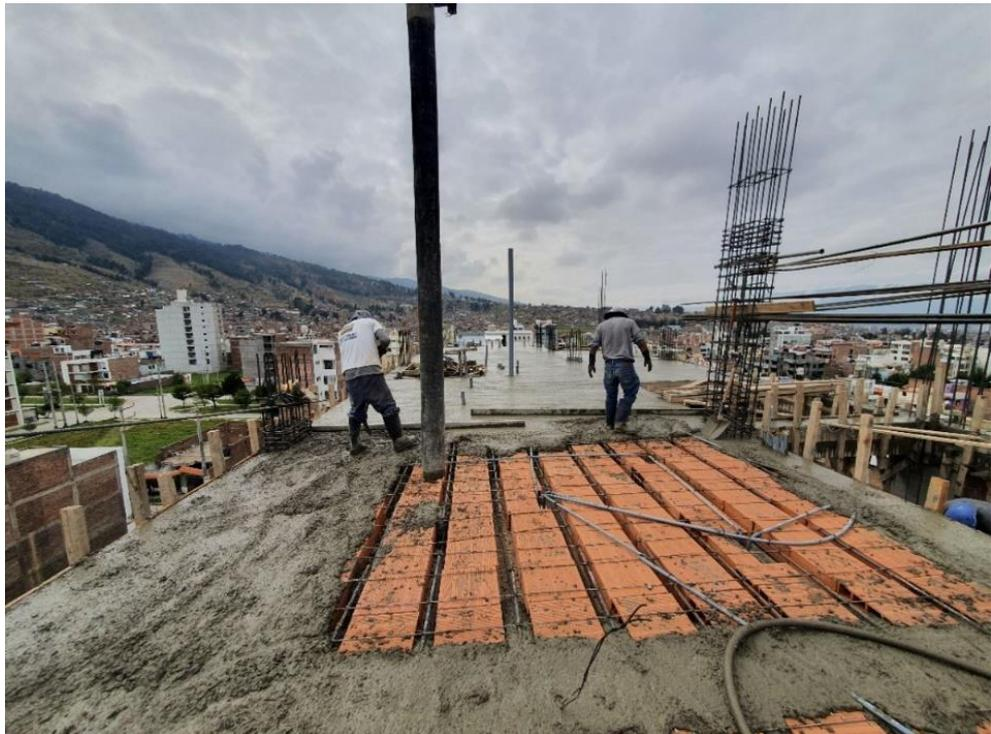
**Figura 56. Reglado de la losa aligerada**
