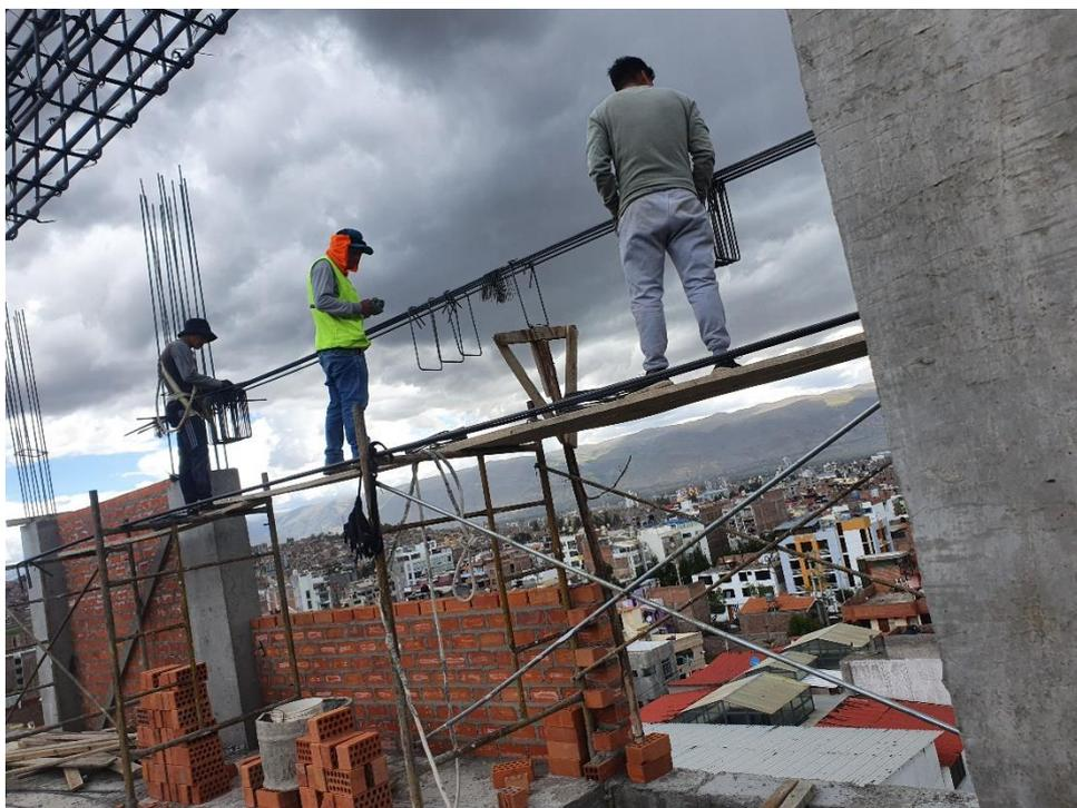
**Figura 51. Proceso de enfierrado en vigas**
