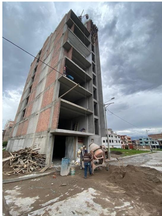
**Figura 69. Transporte de concreto para contra piso**
