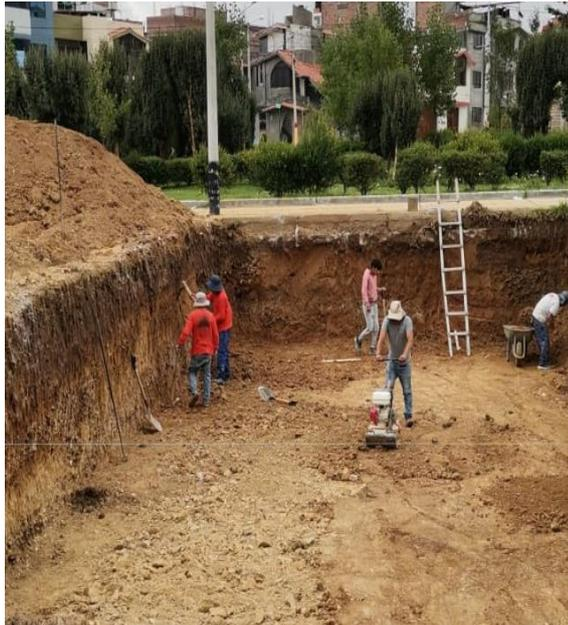
**Figura 35. Compactación de material suelto**
