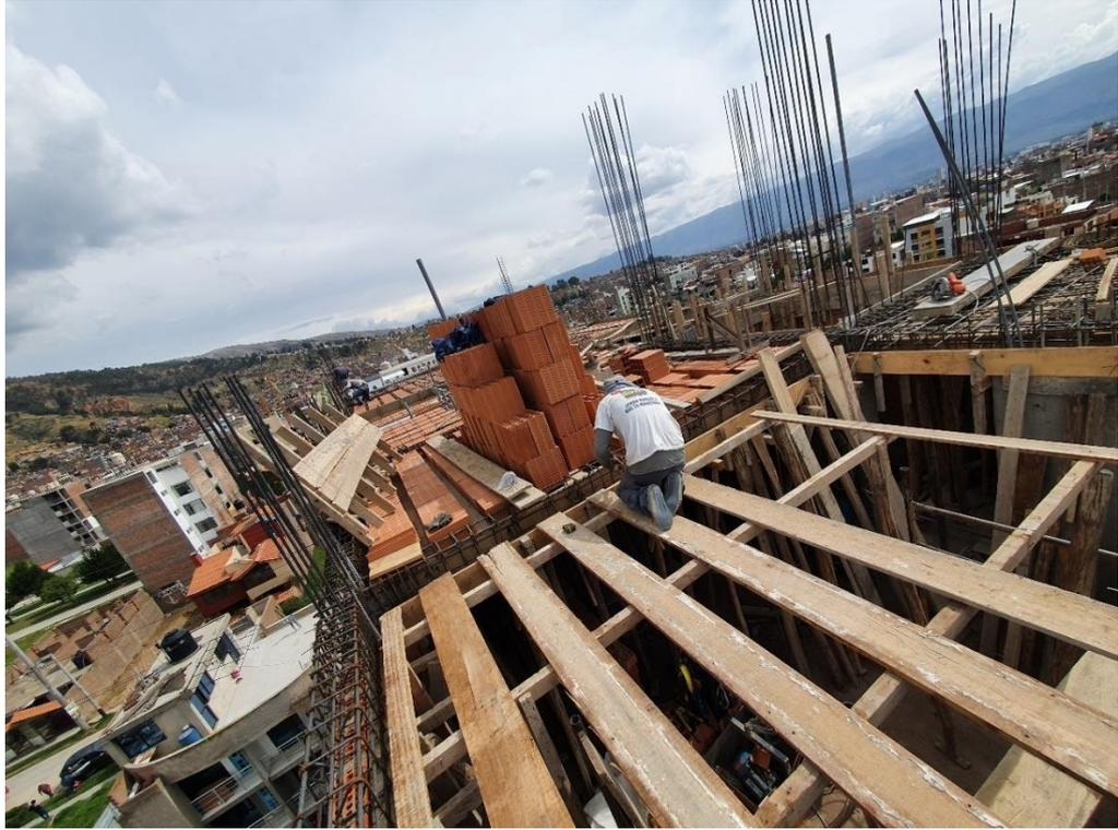
**Figura 53. Entablado de losa**
