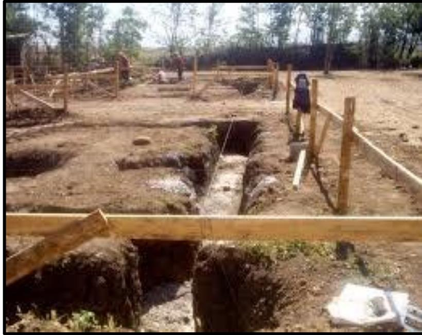
**Figura 5. Trazado de terreno**
