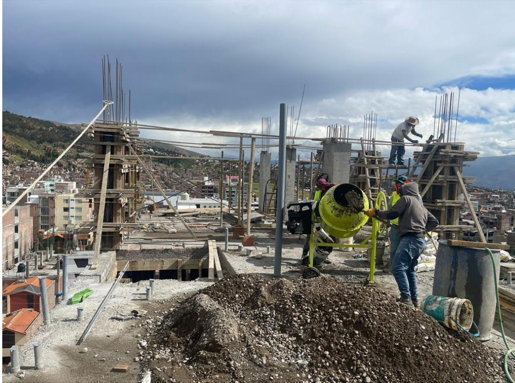
**Figura 65. Vaciado de concreto con mezcladora tipo trompito**
