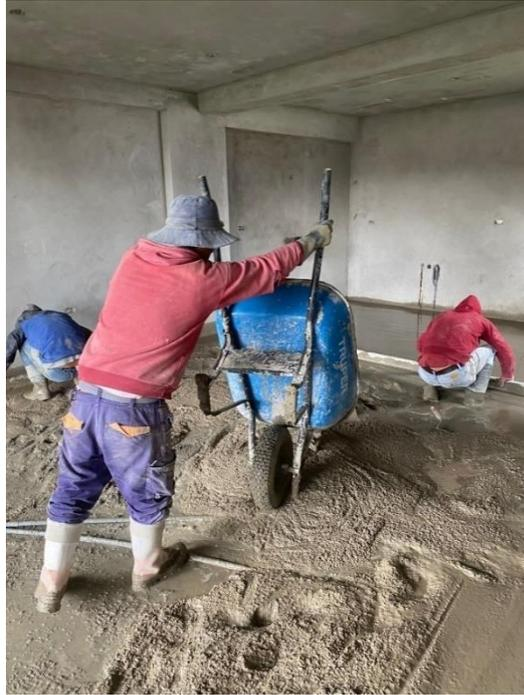
**Figura 68. Vaciado de contra pisos**
