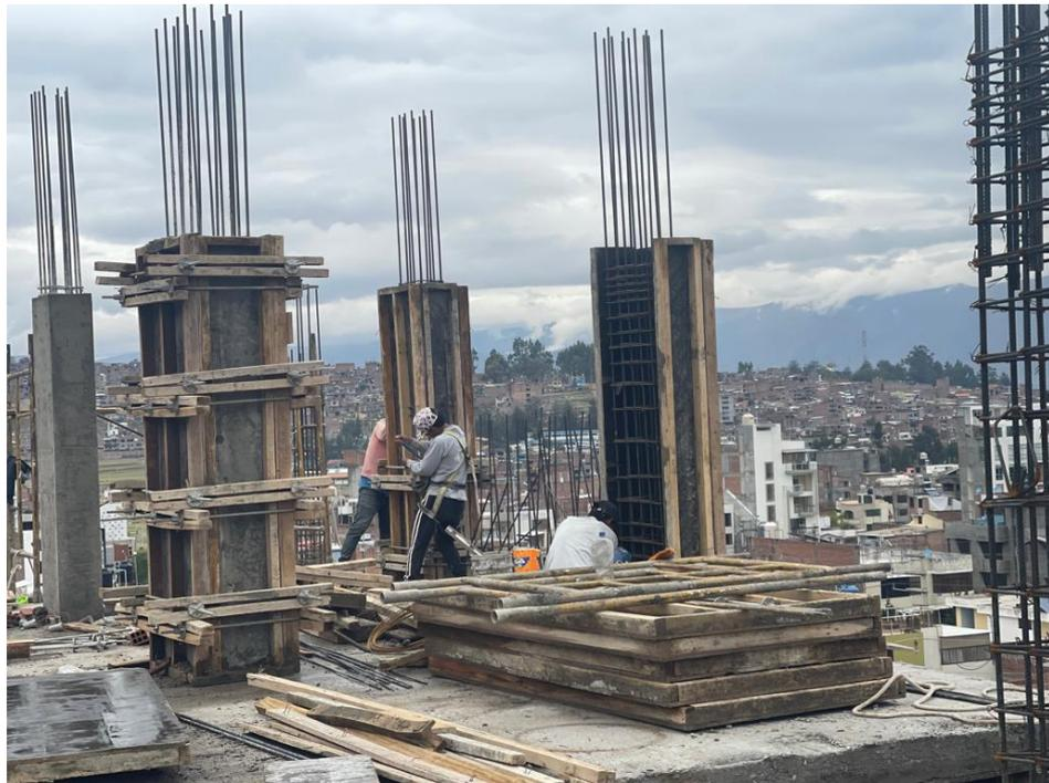
**Figura 59. Encofrado de columnas**
