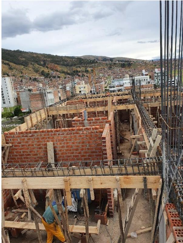
**Figura 50. Enfierrado longitudinal y transversal**
