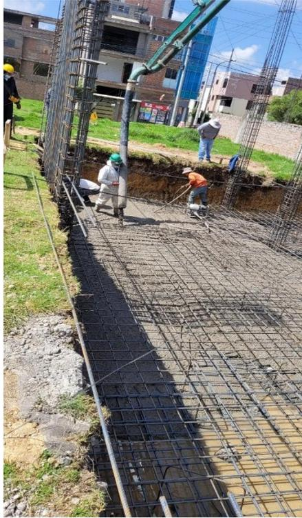
**Figura 41. Vaciado de concreto en primer tramo**
