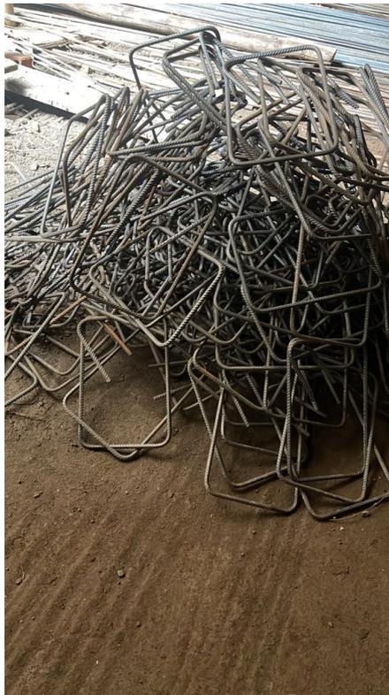
**Figura 49. Preparación de estribos**
