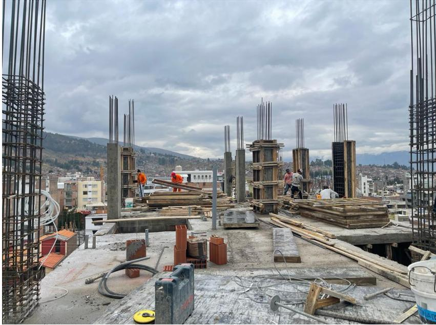
**Figura 60. Encofrado y desencofrado de columnas**
