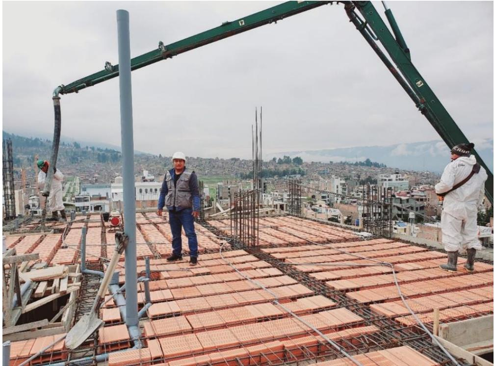
**Figura 55. Vaciado de concreto**
