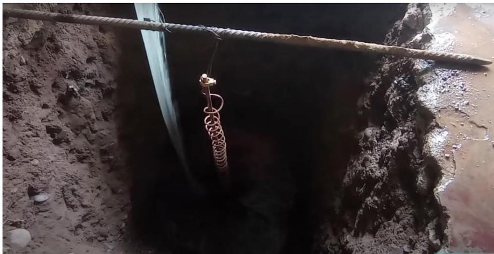
**Figura 76. Instalación de puesta a tierra**
