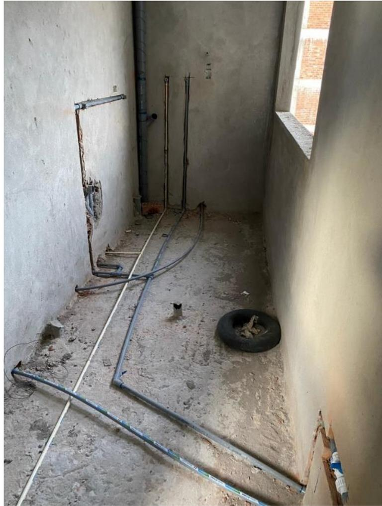
**Figura 79. Instalación de agua caliente y agua fría**
