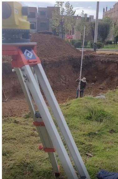
**Figura 32. Proceso de nivelación para solado**
