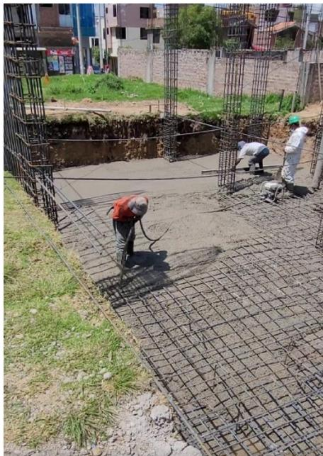
**Figura 42. Vaciado tramo intermedio**
