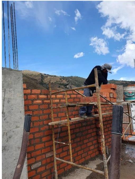
**Figura 48. Asentado de ladrillo a altura completa**
