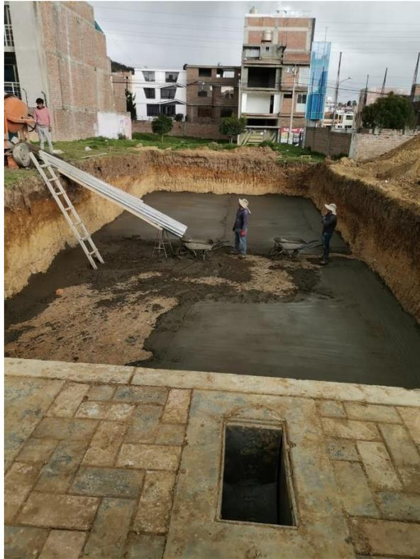
**Figura 37. Momentos finales del vaciado de solado**
