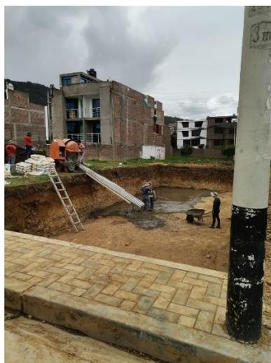
**Figura 36. Vaciado de solado**
