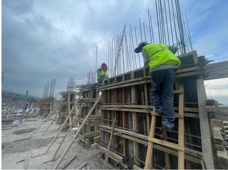
**Figura 62. Encofrado de placas**
