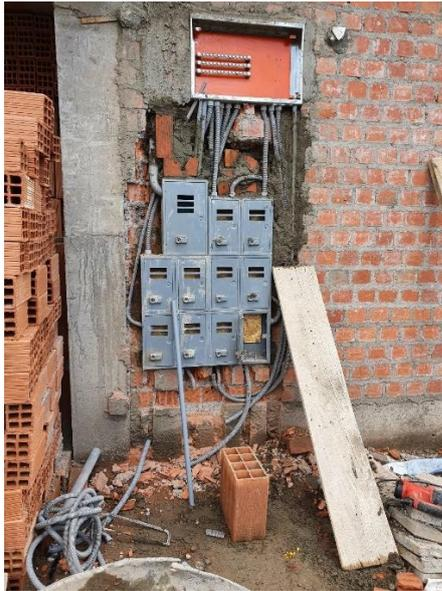
**Figura 77. Instalación de banco de medidores**
