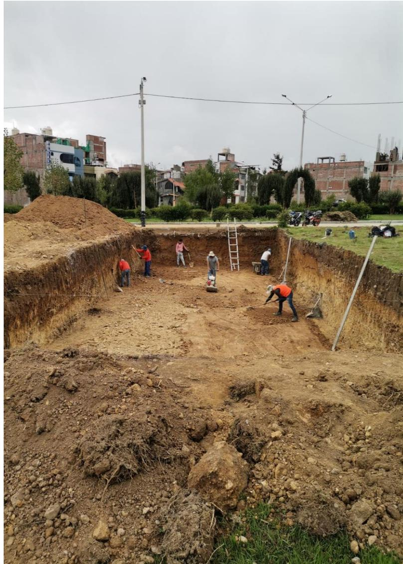
**Figura 34. Perfilado de terreno manual**
