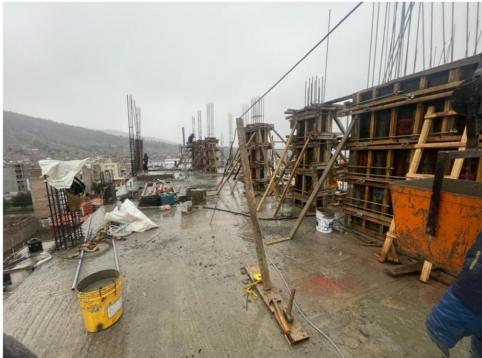
**Figura 64. Vaciado de concreto con wincha eléctrica**
