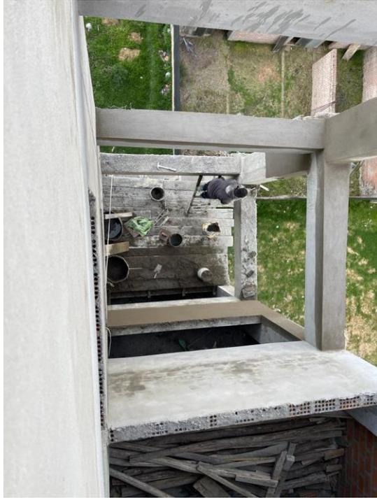
**Figura 66. Tarrajeo de ductos de iluminación**
