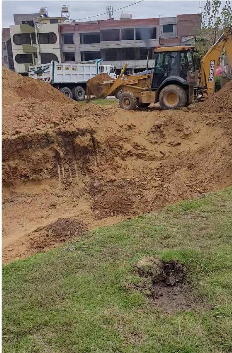
**Figura 29. Eliminación de material excedente**
