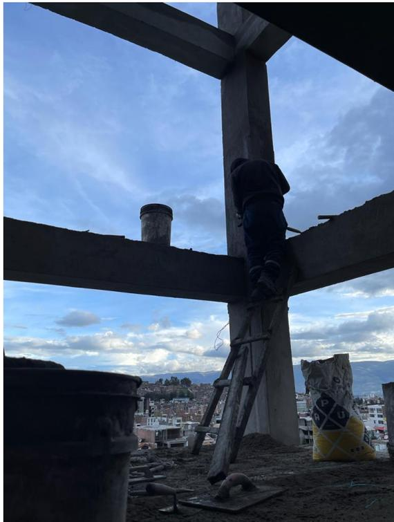
**Figura 67. Tarrajeo columnas de ducto**
