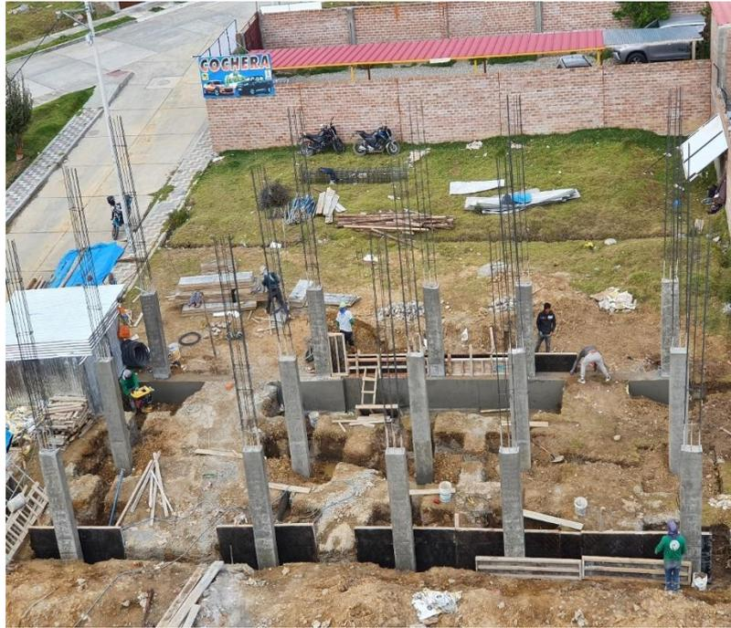
**Figura 44. Encofrado de cimientos, sobrecimientos, columnas y placas**
