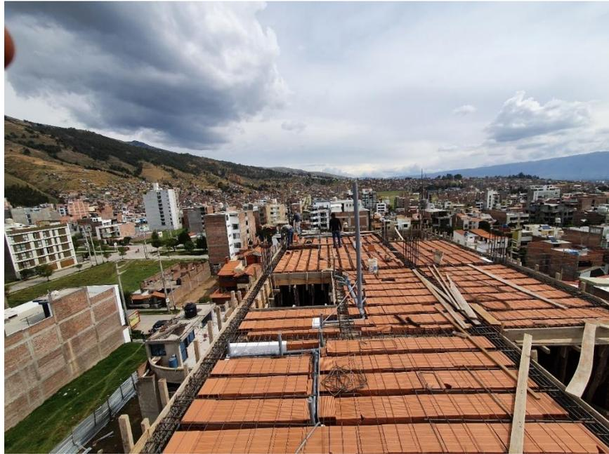
**Figura 54. losa aligerada**
