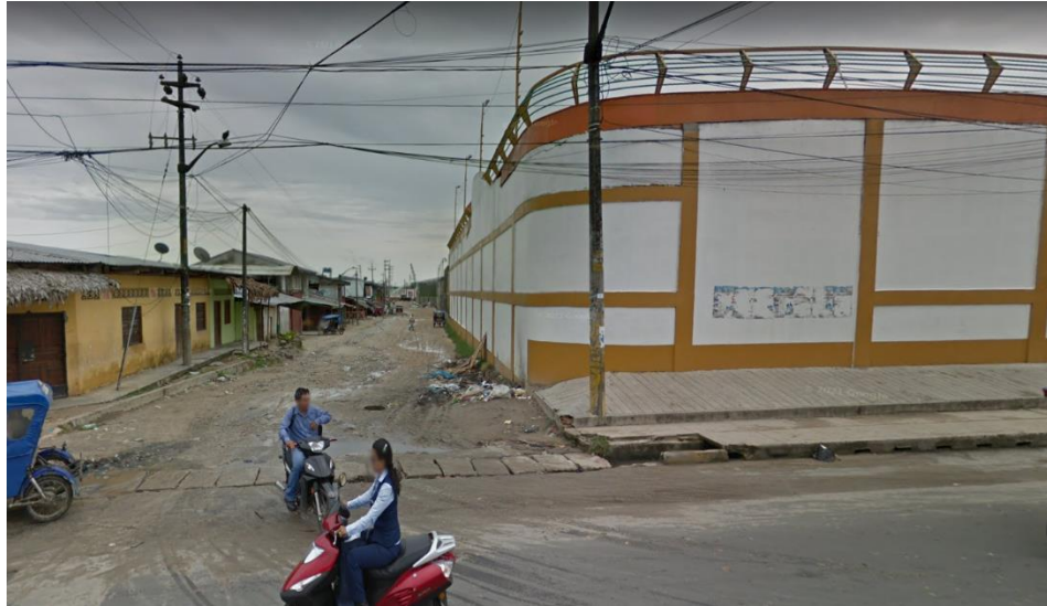
Imagen N°37: Vía de Conexión-Tierra Calle Luz Marina
