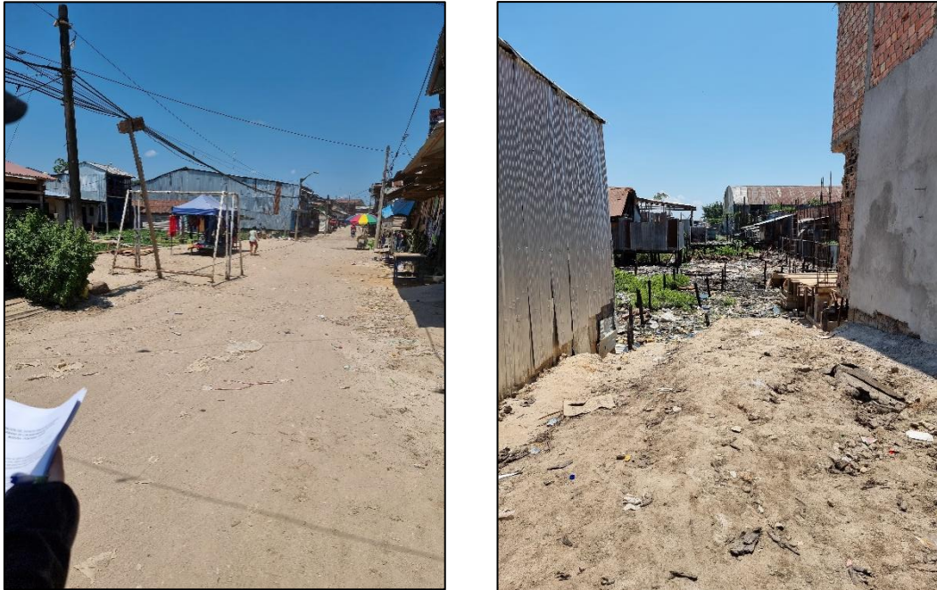
Imagen 49: Fotografía de calles no pavimentadas
