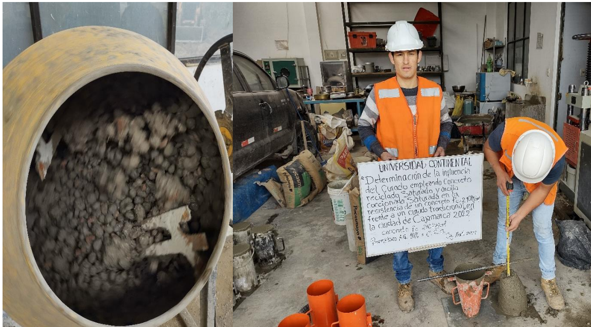
Figura 102. Proceso de mezclado con porcentaje de reemplazo del 10% del agregado grueso por concreto reciclado saturado, prueba de asentamiento.
