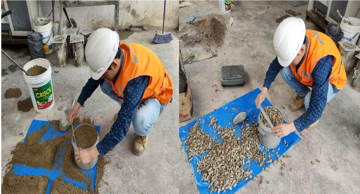
Figura 53. Llenado de recipiente y enrasado de agregado fino y agregado grueso
