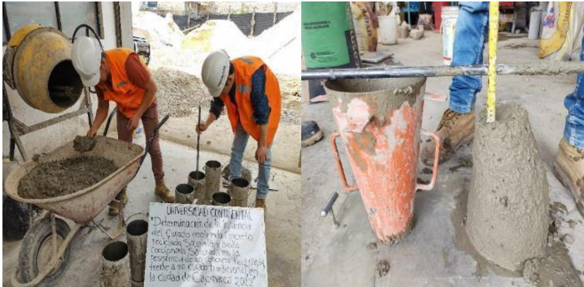
Figura 109. Proceso de vaciado a recipientes de aluminio del concreto modificado con reemplazo de 30% del agregado grueso por concreto reciclado saturado, de igual manera se puede apreciar la prueba de asentamiento del concreto.
