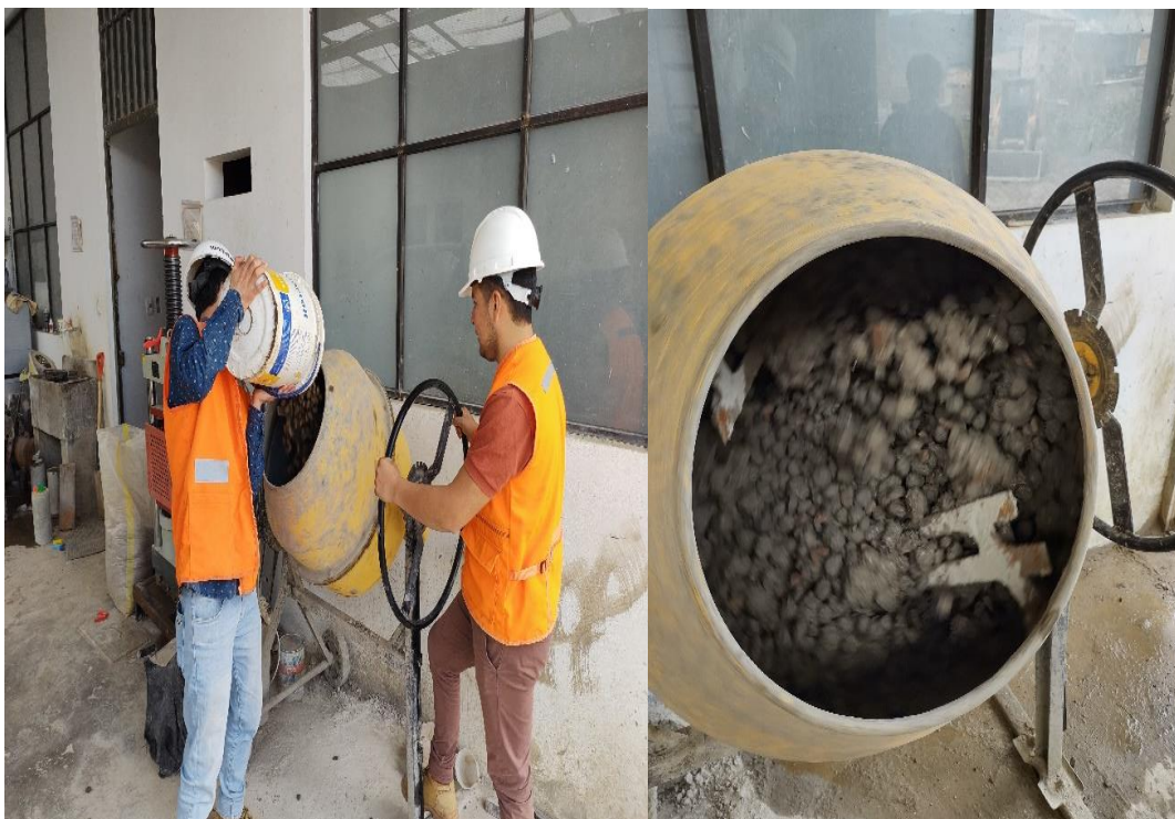
Figura 108. Proceso de mezclado en trompo del concreto modificado con reemplazo de 30% del agregado grueso por concreto reciclado saturado.
