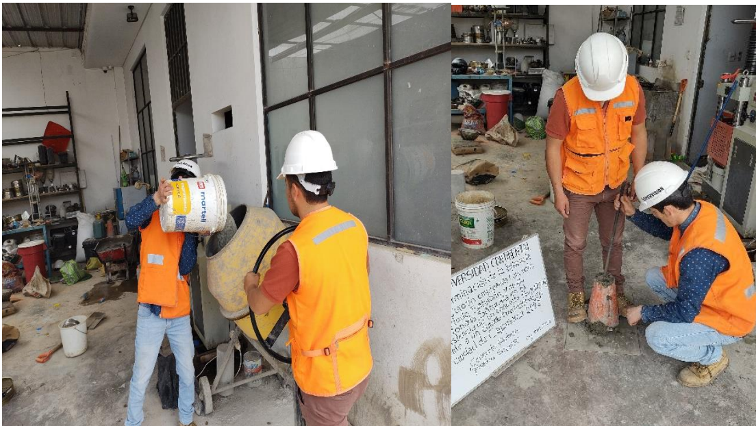
Figura 79. Mezclado del concreto en el trompo y ensayo de prueba slump.
