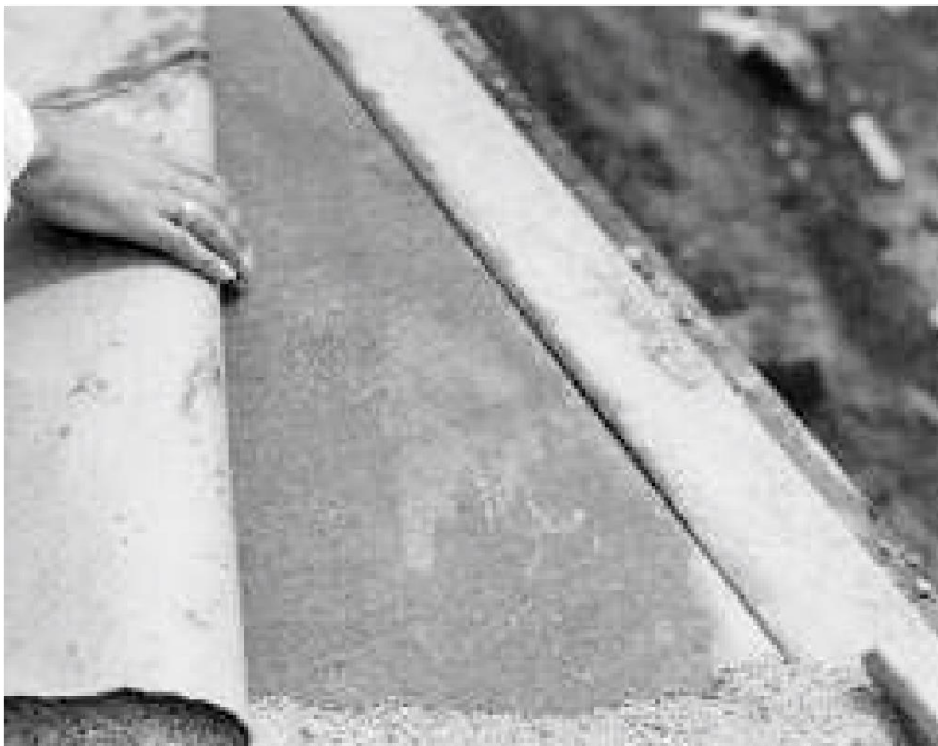
Figura 21. Papel impermeable para curado es una medida eficiente de curado horizontal de superficies. (69994)
