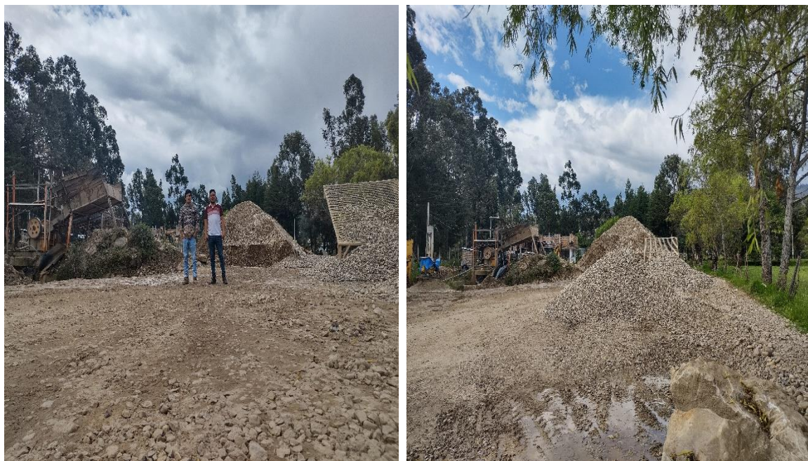
Figura 31. Agregado grueso en cantera “Agregados Aguilar” pasada de la malla 3/4.
