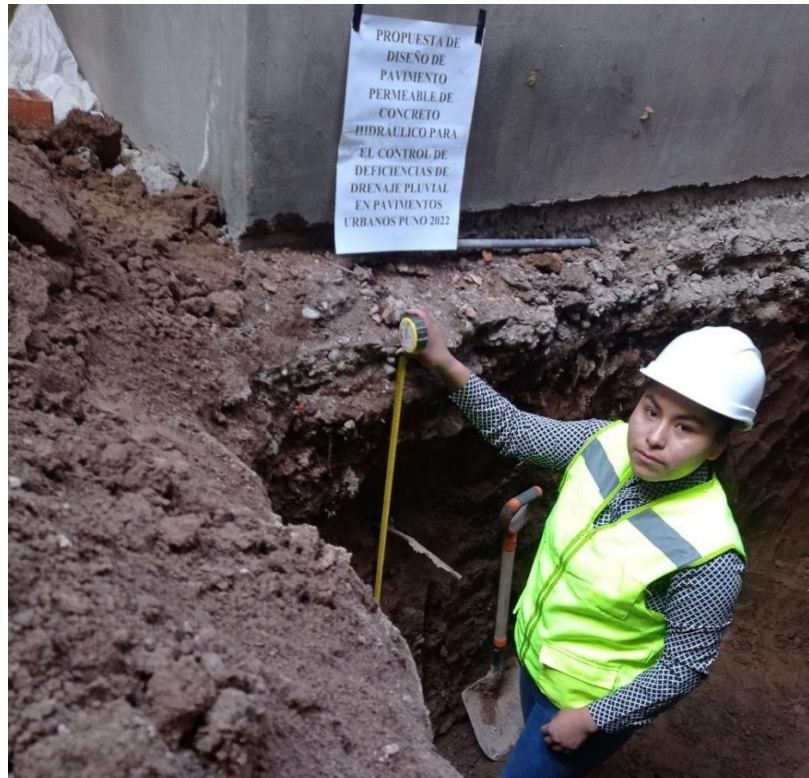
Apertura de calicata N°01 en el Jr. Lima esquina con Jr. Huayna Cápac y recojo de muestra a 1.20 metros de profundidad.
