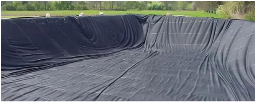
Figura 15. Geotextil no tejido de polipropileno
