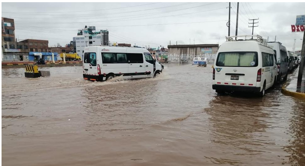
Figura 1. Estado situacional del ovalo salida Cusco - Juliaca
