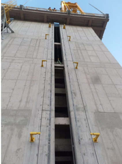
Figura 46. Inspección descenso de loseta.
