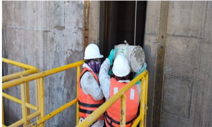
Figura 53. Verificación de la aplicación del relleno hidráulico para el sellado.
