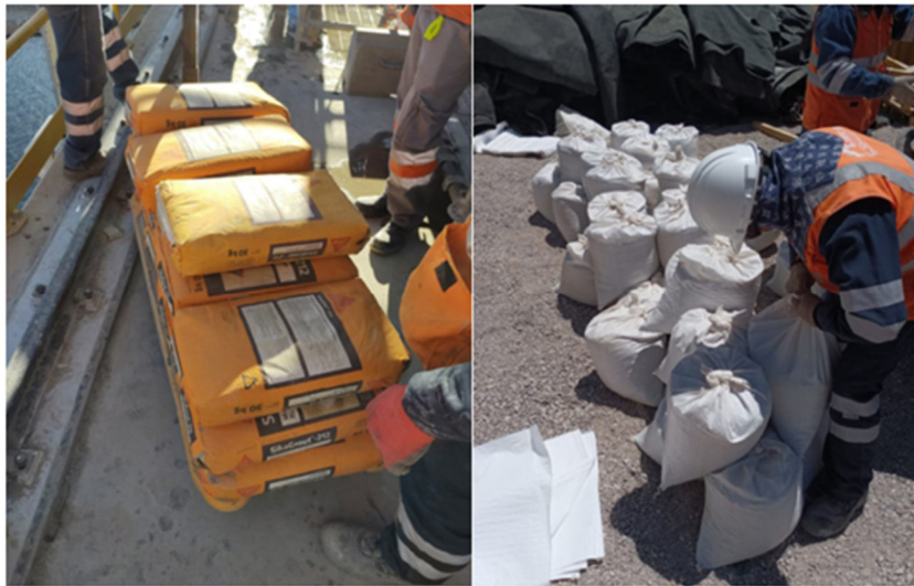
Figura 29. Inspección y verificación de Recepción de materiales.
