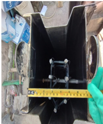
Figura 31. Verificación de las medidas del encofrado.
