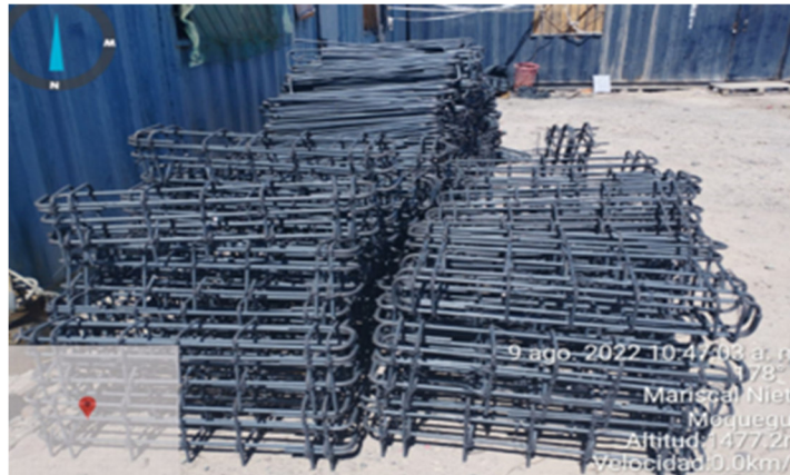
Figura 33. Inspección y verificación del armado de acero.
