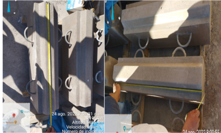
Figura 42. Verificación Control dimensional.
