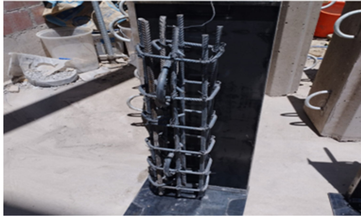
Figura 34. Instalación de acero de refuerzo al encofrado.
