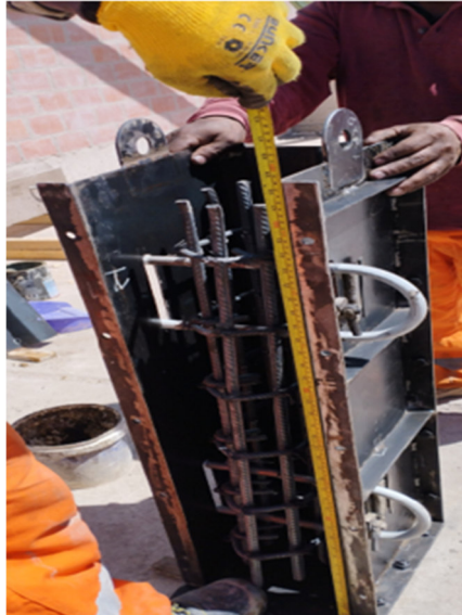
Figura 35. Verificación de las medidas del acero de acuerdo al plano.
