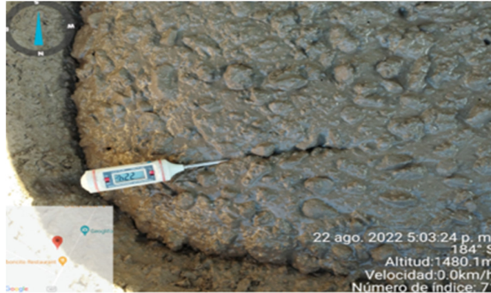
Figura 37. Temperatura al concreto (NTP 339.184 y ASTM C1064/C1064M).
