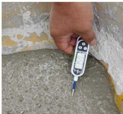
Figura 51. Medición de la temperatura de la mezcla cementicia sellado hidráulico. Fuente. Elaboración propia
