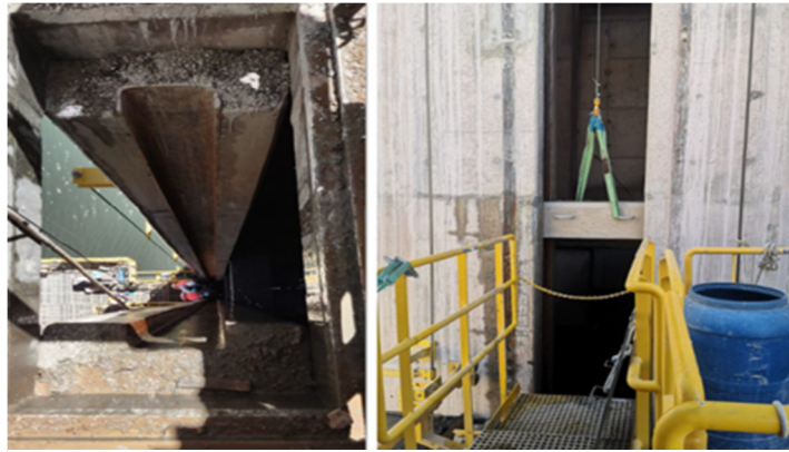
Figura 43. Verificación que la loseta ingrese por su canal sin atascarse ni sufrir daños.
