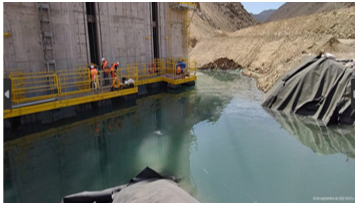
Figura 54. Torre de captación N.º 1, incremento de laguna.
