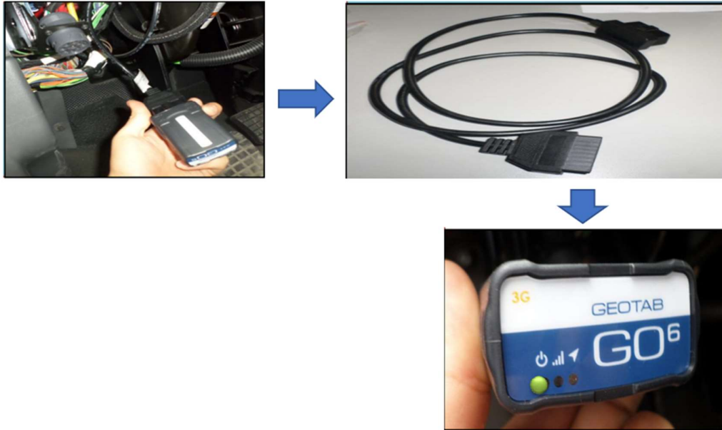
Figura 7. Instalación del sistema de telemetría (2) Fuente. Tracto camiones USA Internacional
