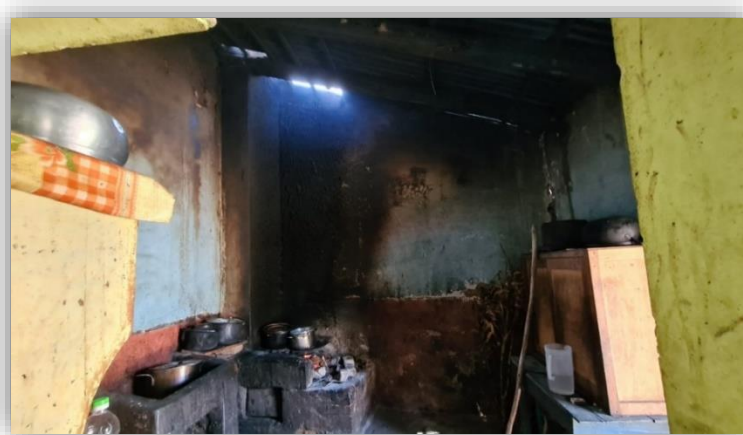
Figura 80: Estado Previo estado de la cocina.
