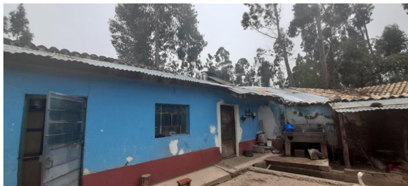
Figura 31: Fotografía de la cocina-comedor en estado real
