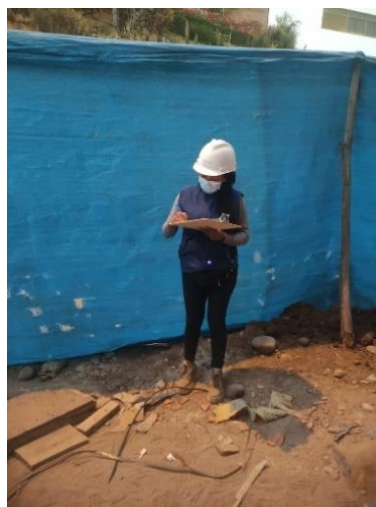
Figura 15. Rellenado de la ficha cuestionario por la ingeniera encargada de obra Galia.
