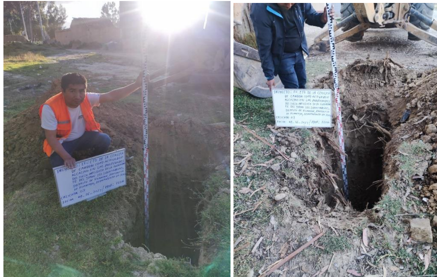
Figura 17. Vista de la calicata excavada para la extracción del suelo arcilloso.
