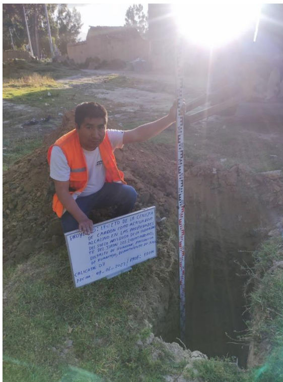
Fotografía 2. Se observa que las calicatas fueron realizadas a una profundidad mínima de 1.50 m, tal como la normativa establece.
