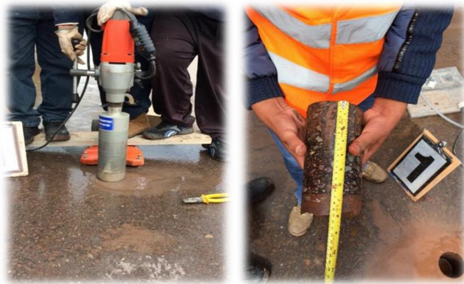
Figura 2: Extracción de Testigo con Perforación Diamantina.
