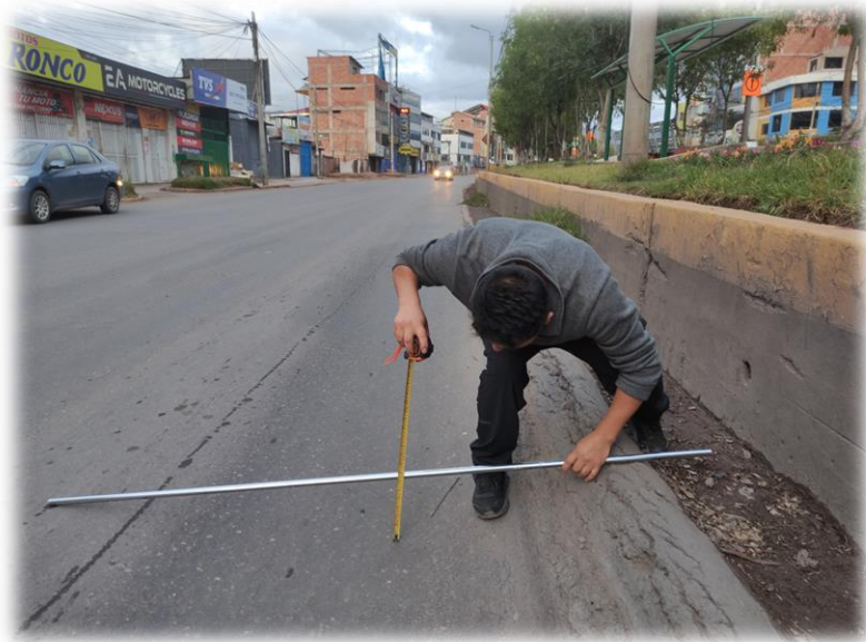
Figura 8: Falla de Ahuellamiento.
