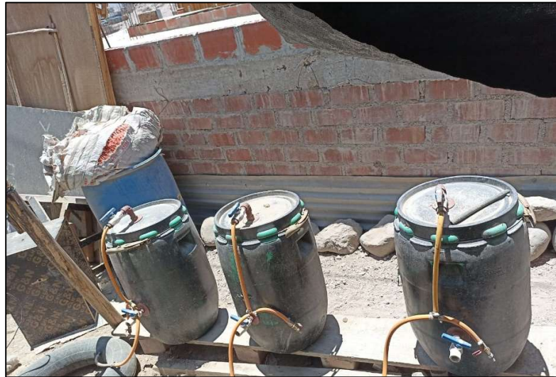
Figura 13. Construcción de tres biodigestores
