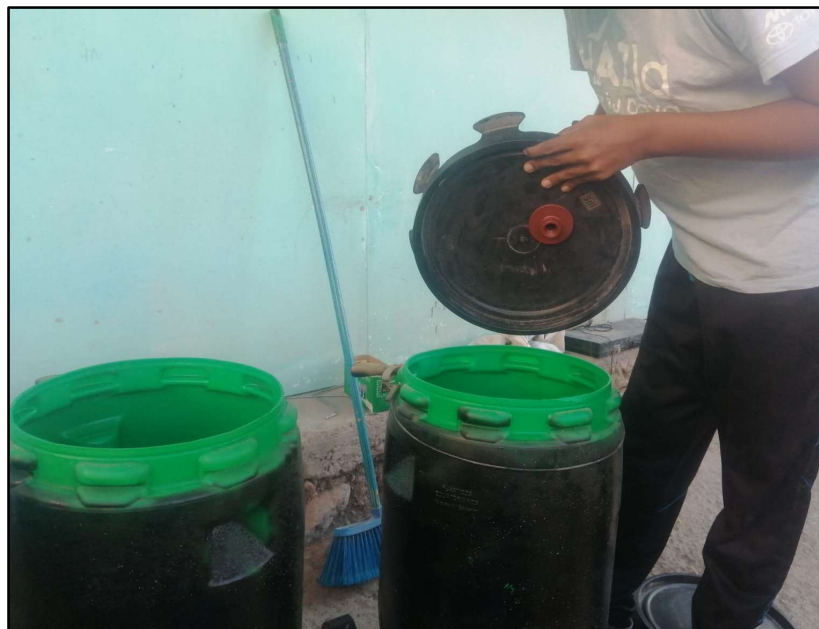
Figura A06.2. Construcción de biodigestores
