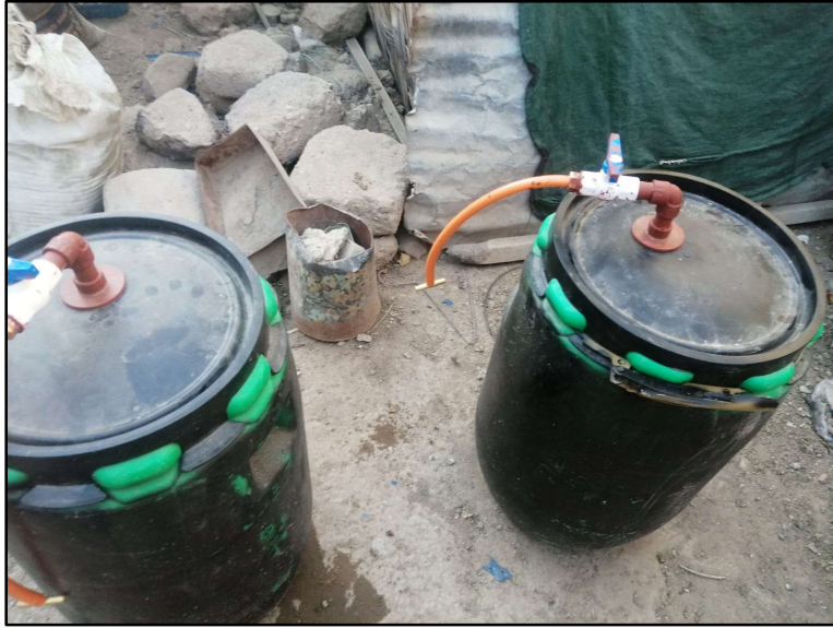
Figura A06.3. Etapa de construcción de biodigestores
