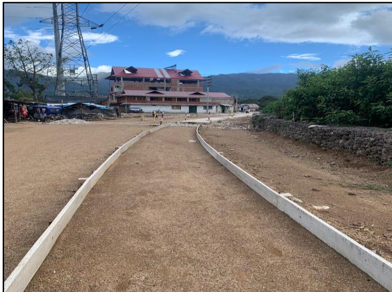
Figura 11: Evidencia de trabajo de asfalto - ESP 1
