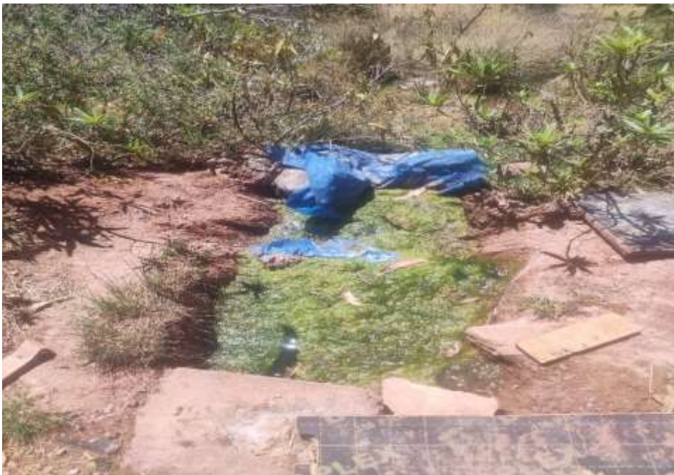
Figura 37. Aparición de algas en agua proveniente de la línea de conducción hacia el reservorio
