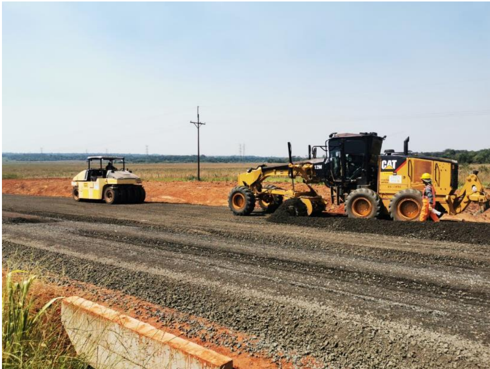
Figura 1 Tendido y Compactación de una base granular
