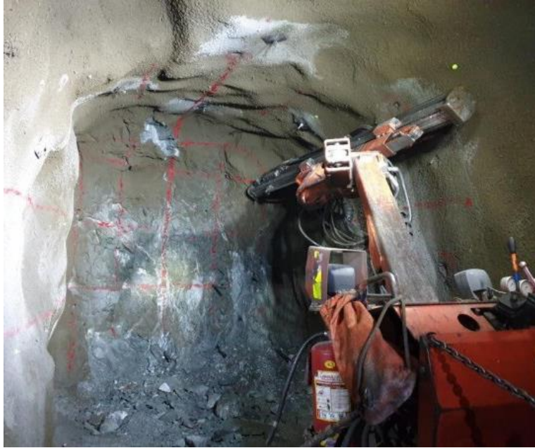
Figura 23. Perforación de corona
