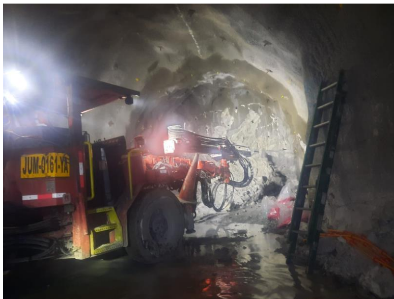
Figura 24. Perforación de taladros de producción
