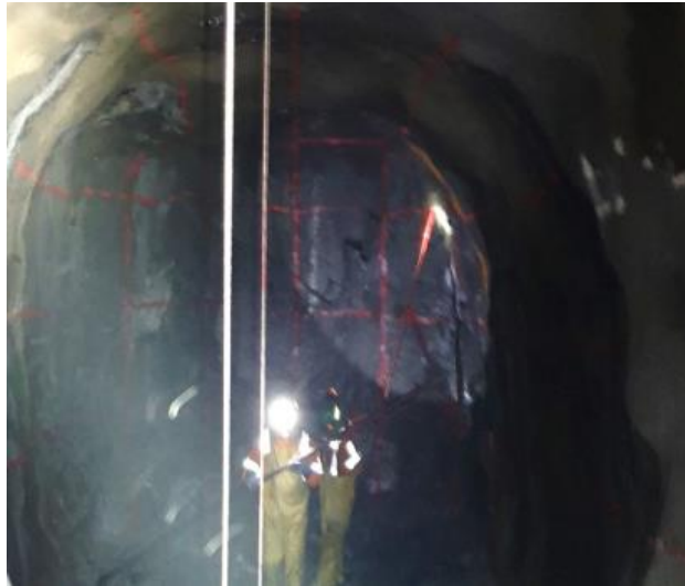
Figura 17. Marcado de malla y ejes de perforación
