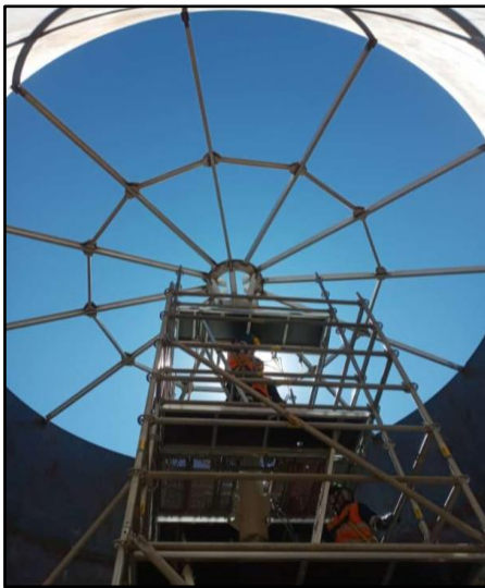
Figura 23. Vigas de soporte de techo armadas y soldadas
