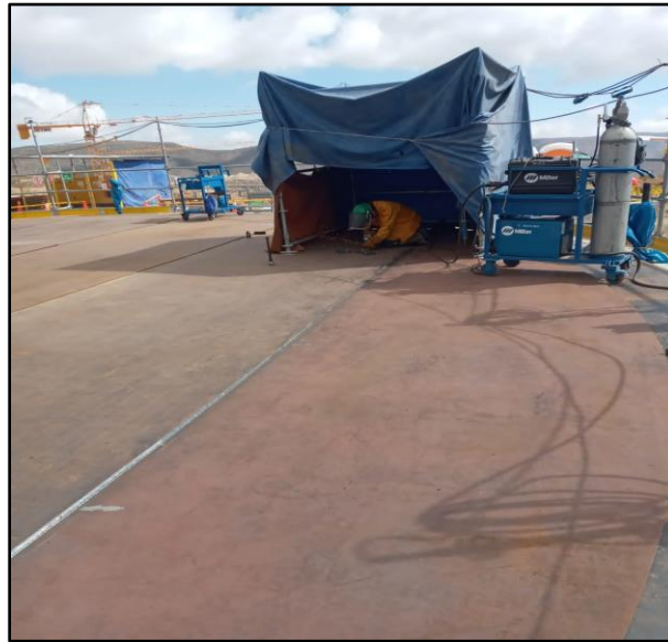
Figura 17. Soldeo de fondo de tanque
