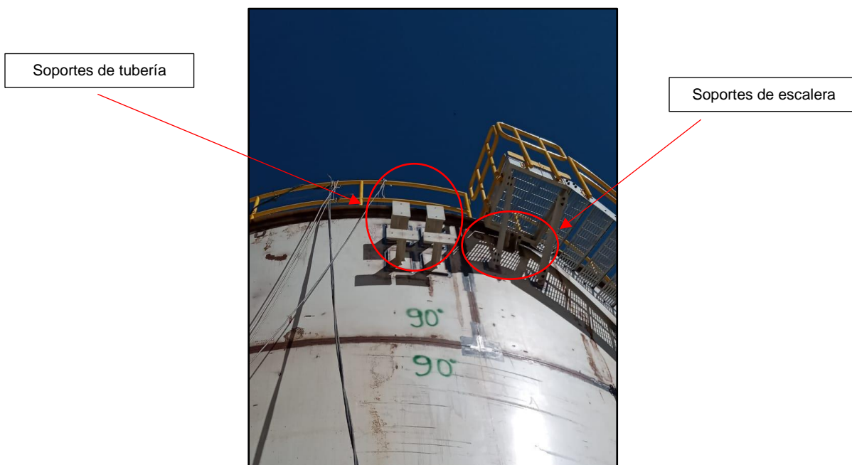
Figura 22. Soportes de tubería y de escalera armados y soldados
