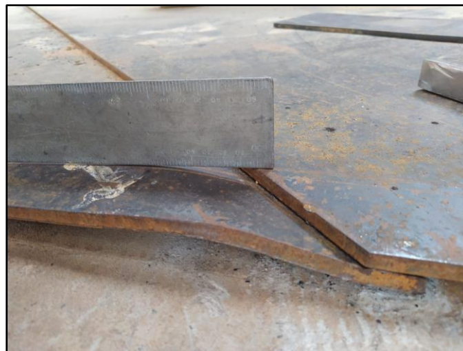
Figura 18. Plegado de fondo en zona de asentamiento de casco de tanque
