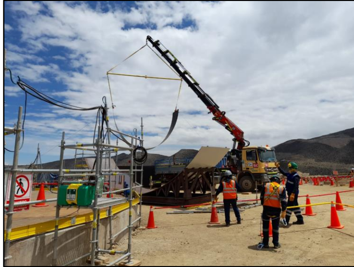
Figura 16. Descarga de materiales pre-fabricados
