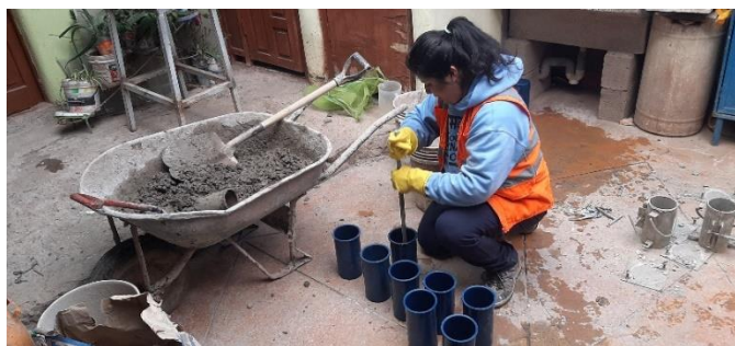
Figura 79: Fabricación de los cilindros de concreto;
