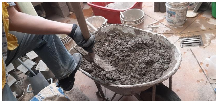
Figura 76: Mezclado de los elementos en carretilla
