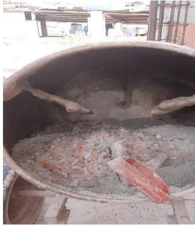
Figura 77: Mezclado de los elementos en mezcladora Fuente: Elaboración Propia;
