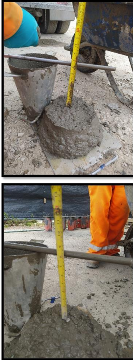
Figura 36. Preparación de pruebas en condición fresca del concreto
