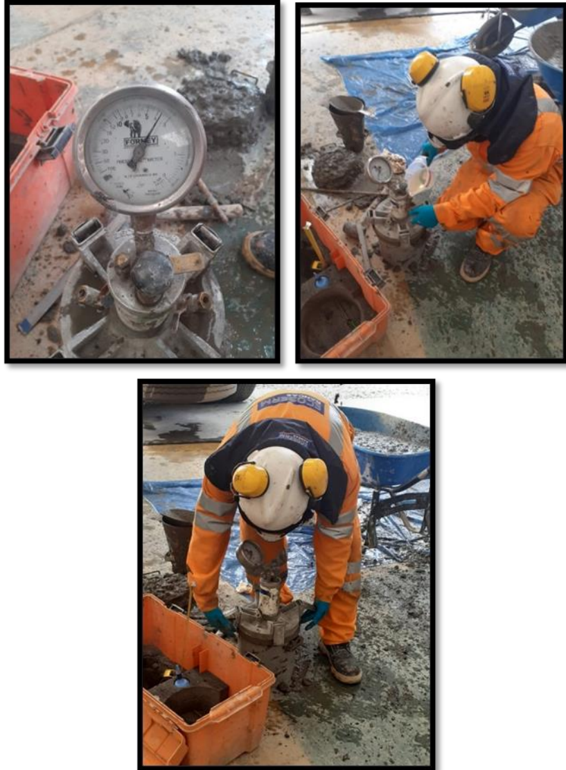
Figura 37. Preparación del contenido de aire
