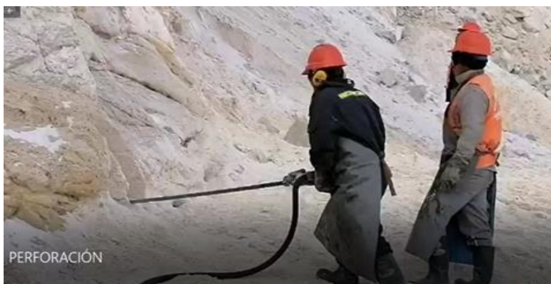
Fotografía 1: Trabajadores en el área de perforación y voladura
