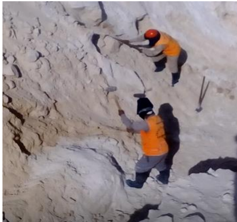
Fotografía 2. Trabajadores en el área de Banqueo
