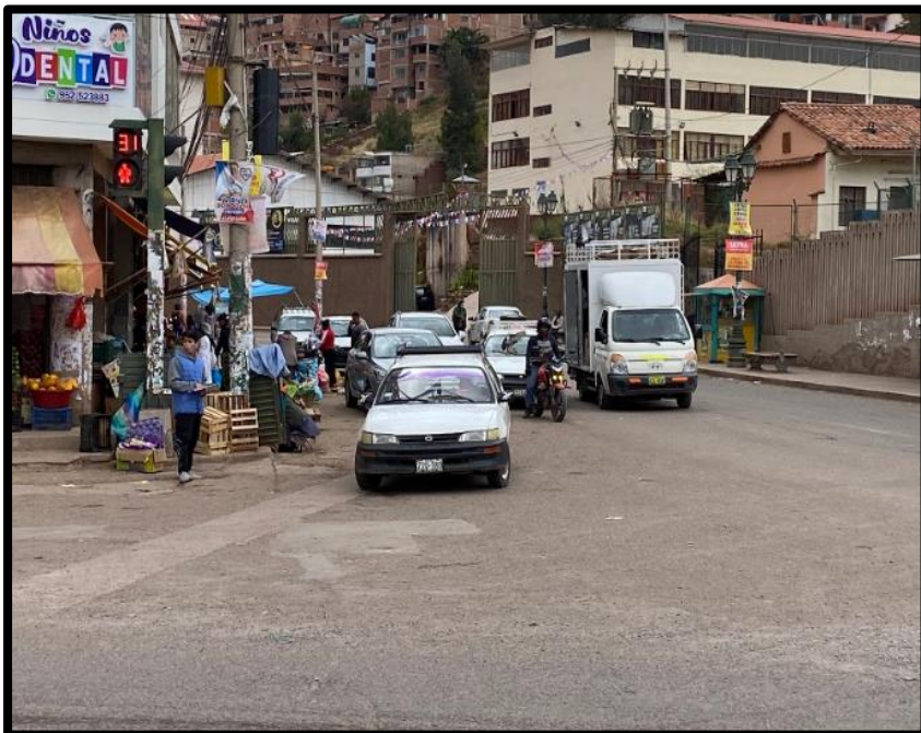
Figura 33 Señalización horizontal inexistente Av. Perú
