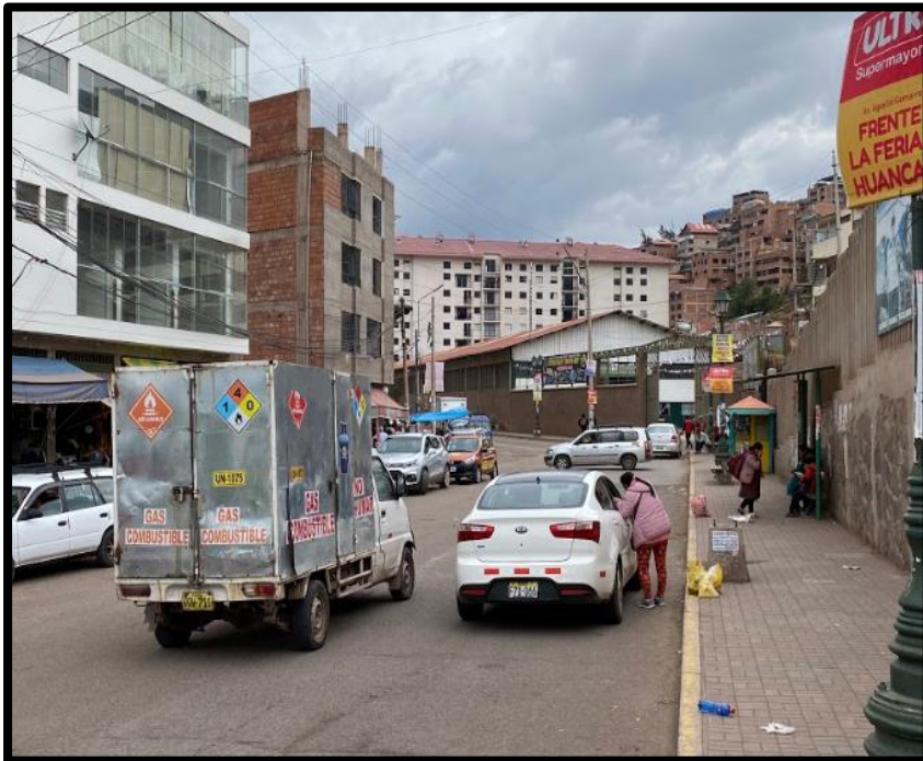
Figura 32 Señalización horizontal inexistente Av. José Luis Orbegoso
