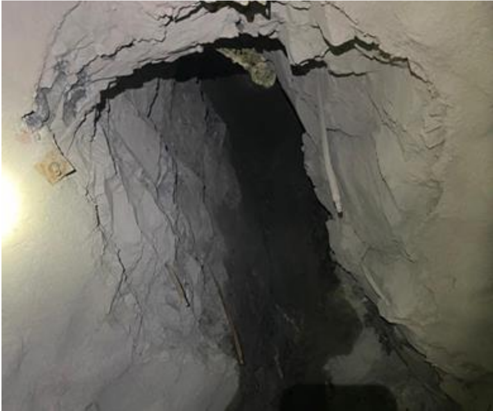
Tomada del Área de Planeamiento de la unidad minera Parcoy (10)
