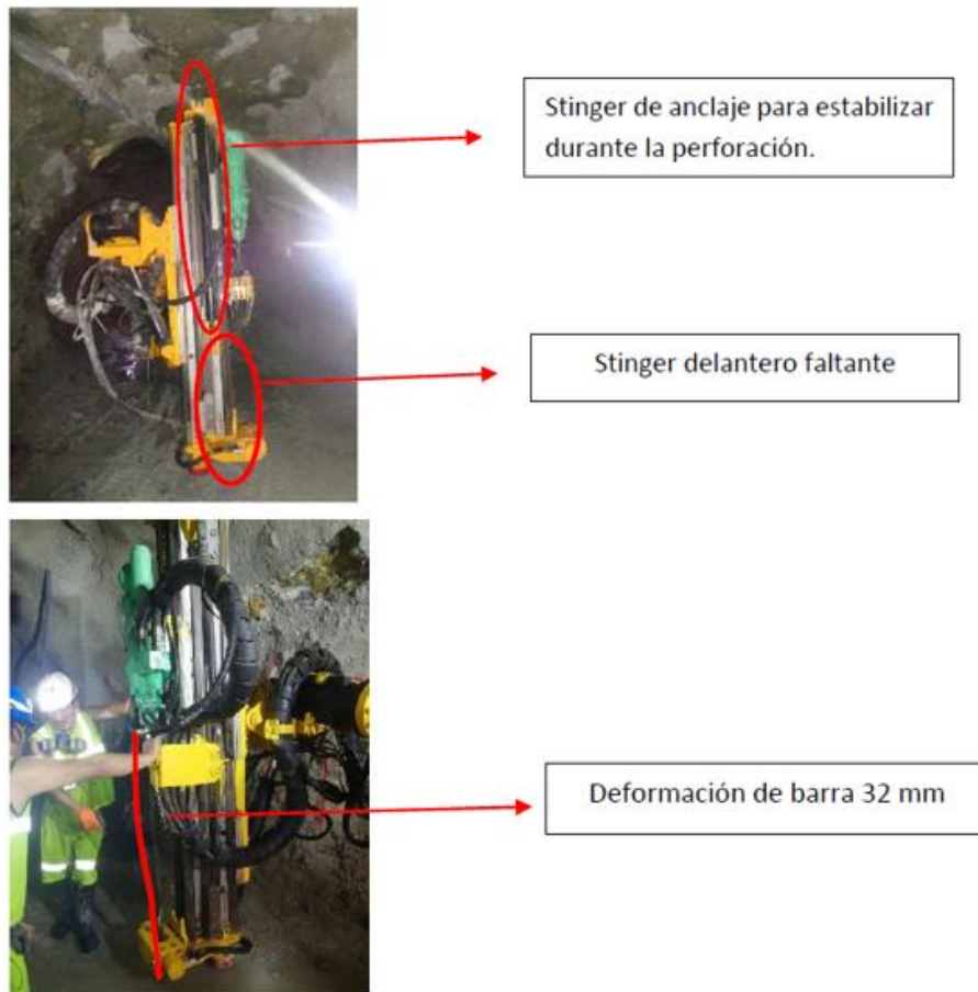
Figura 31. Deficiencias de los equipos de perforación simba del tajeo 700 del Nivel 195 en la veta Fortunata, unidad minera Parcoy Tomada del Área de Planeamiento de la unidad minera Parcoy (10)
