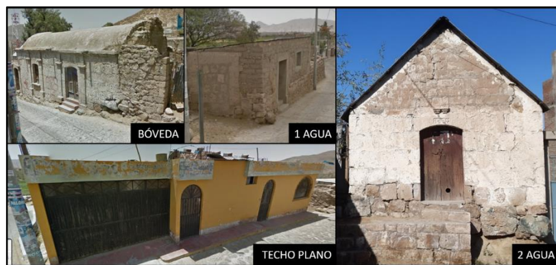
Ilustración 72: Tipología de Edificación – Quequeña. Adaptado de COFOPRI / Catastro de Quequeña.
