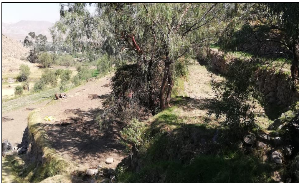
Ilustración 95: Gaviones - Terreno en Quequeña.
