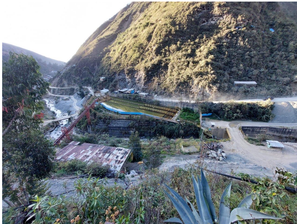
Figura 4. Planta de Tratamiento
