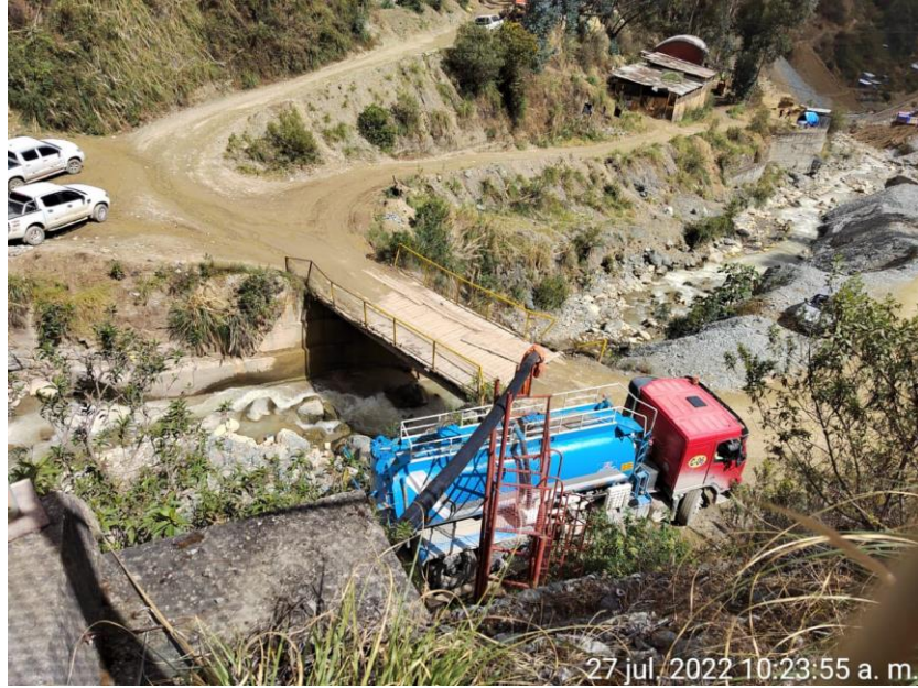
Figura 57. Transporte de lodo mediante uso de cisterna
