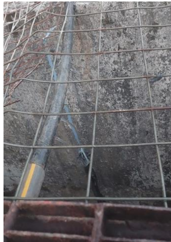
Figura 8. Quena de caída de floculante Fuente: Elaboración propia
