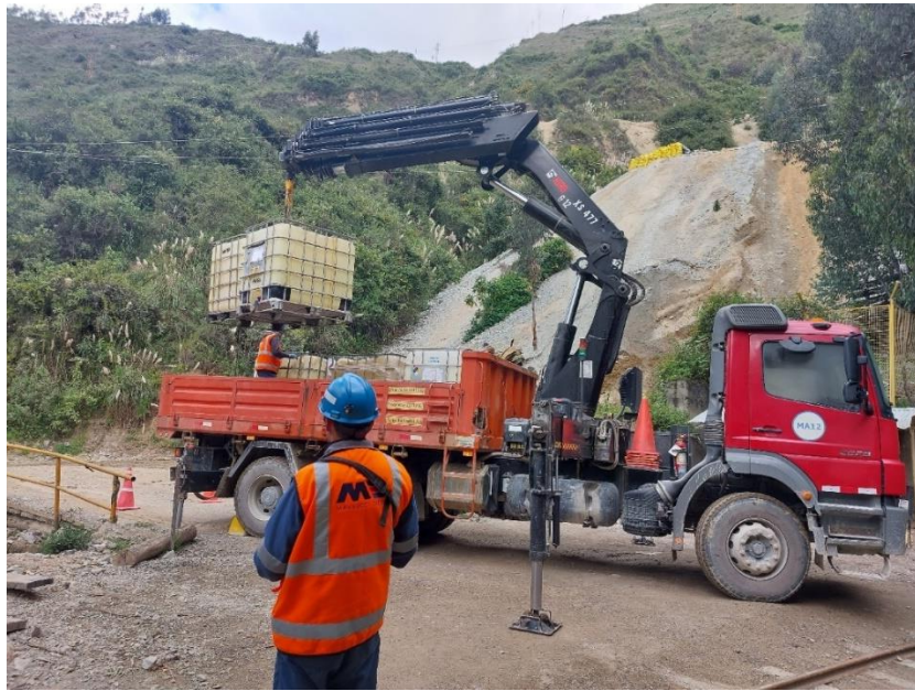
Figura 51. Recepción de floculante e isotanques de cloruro férrico
