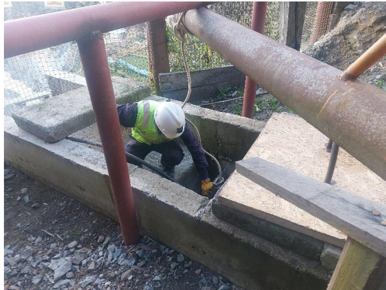
Figura 43. Limpieza de buzones y canales
