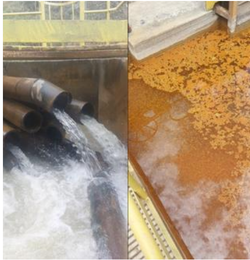
Figura 11. Formación de flóculos en el tratamiento de aguas residuales
