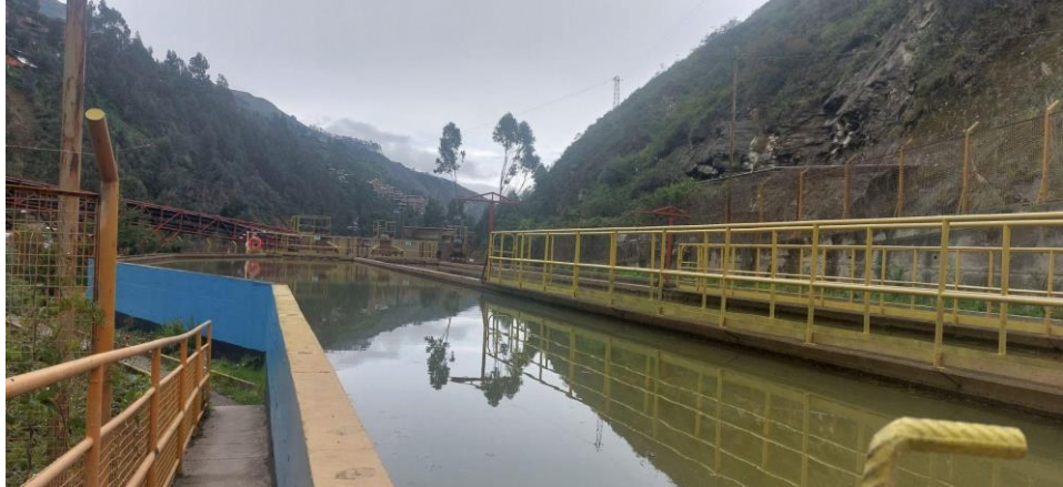
Figura 5. Pozas de sedimentación de la planta de tratamiento
