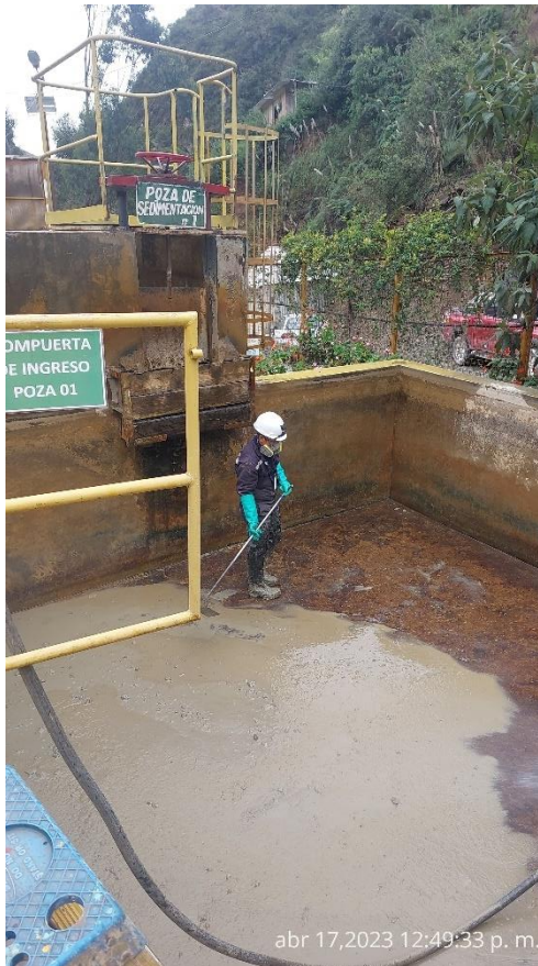
Figura 56. Limpieza de pozas de sedimentación mediante agua a presión
