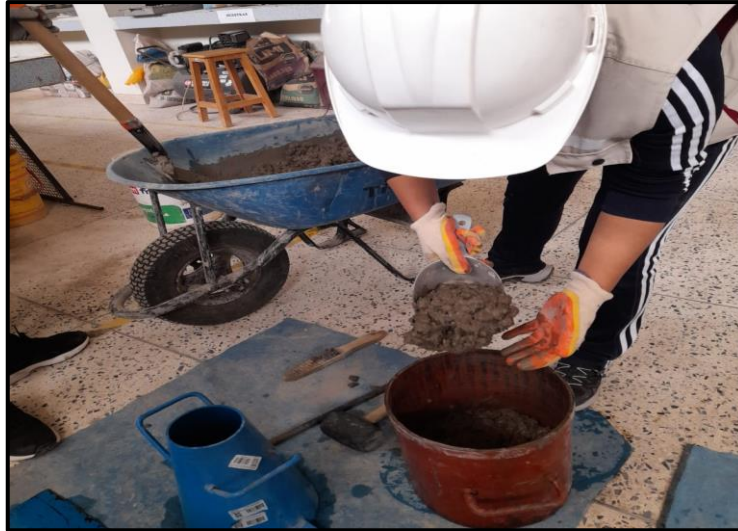
Figura 54. Colocado de capa de concreto. Elaboración propia, 2023.
