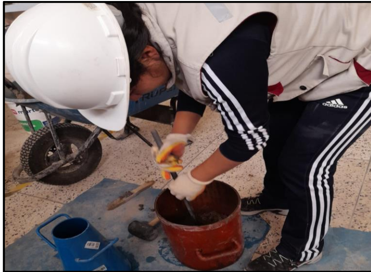
Figura 55. Chuseado del concreto con la varilla. Elaboración propia, 2023.
