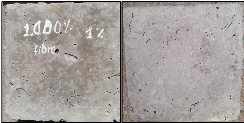
Figura 102. Fisuración del concreto con adición del 1% de fibra del tallo de quinua a los 28 días de exposición al ciclo hielo - deshielo. Elaboración propia, 2023.
