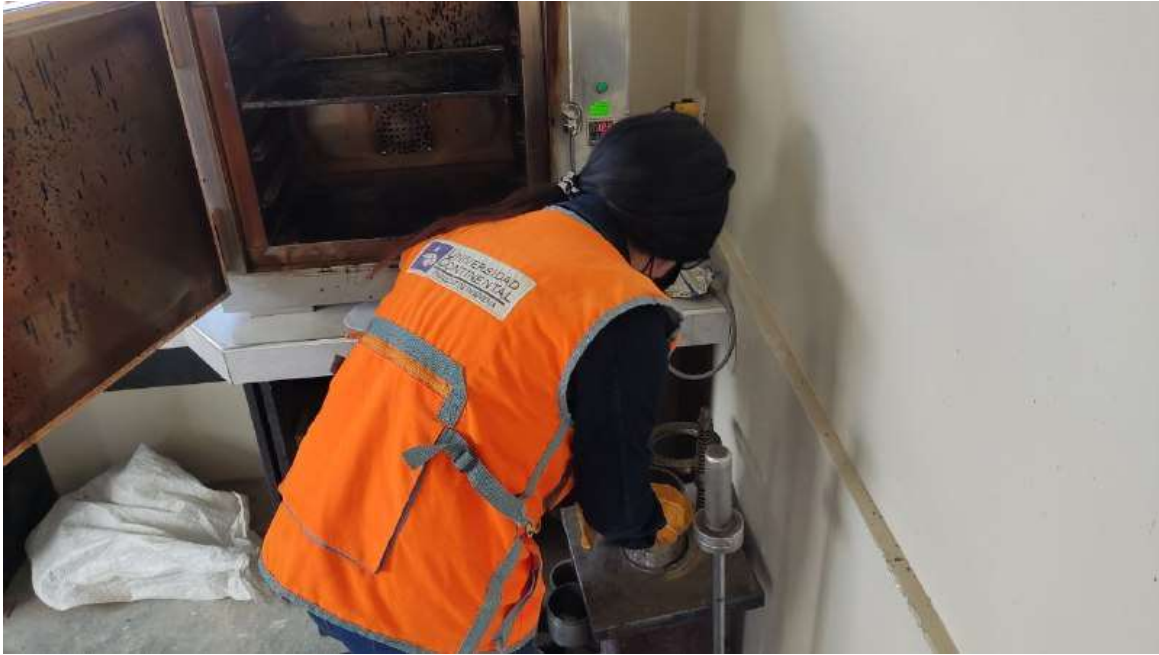
Anexo 33: colocado de los accesorios al pedestal
