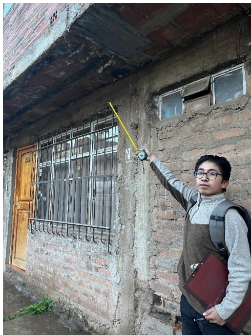
Figura 9.6 Verificación de elementos estructurales (humedad)
