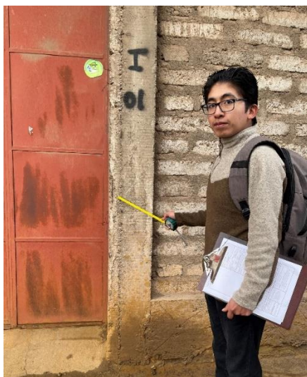
Figura 5.5 Deterioro de elementos estructurales
