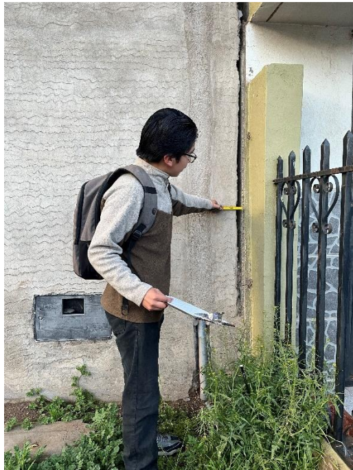
Figura 9.4 Verificación de Juntas de Dilatación sísmica
