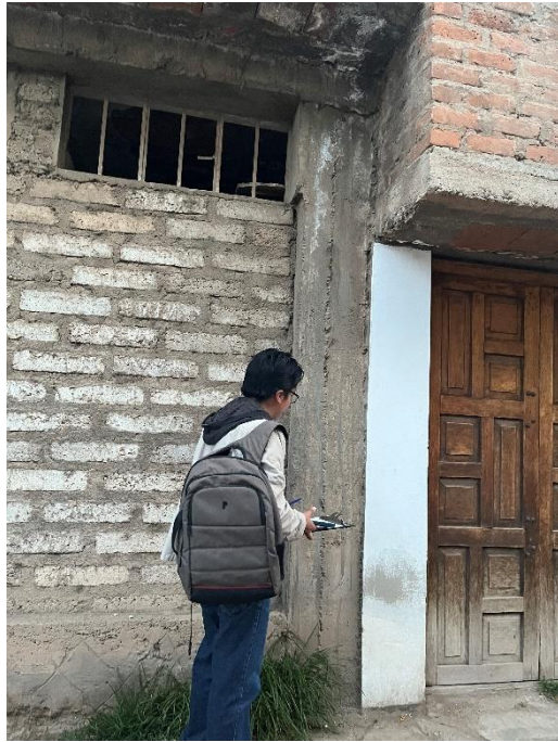
Figura 9.5 Verificación de elementos estructurales
