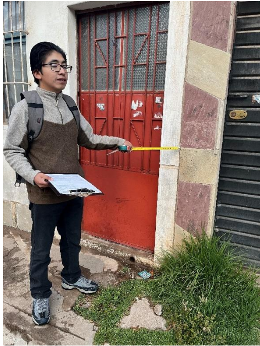
Figura 9.3 Verificación de Juntas de Dilatación sísmica
