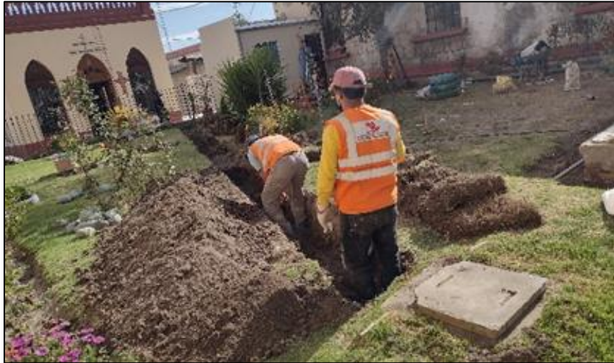
Figura 4 Instalación de tubería de agua y desague
