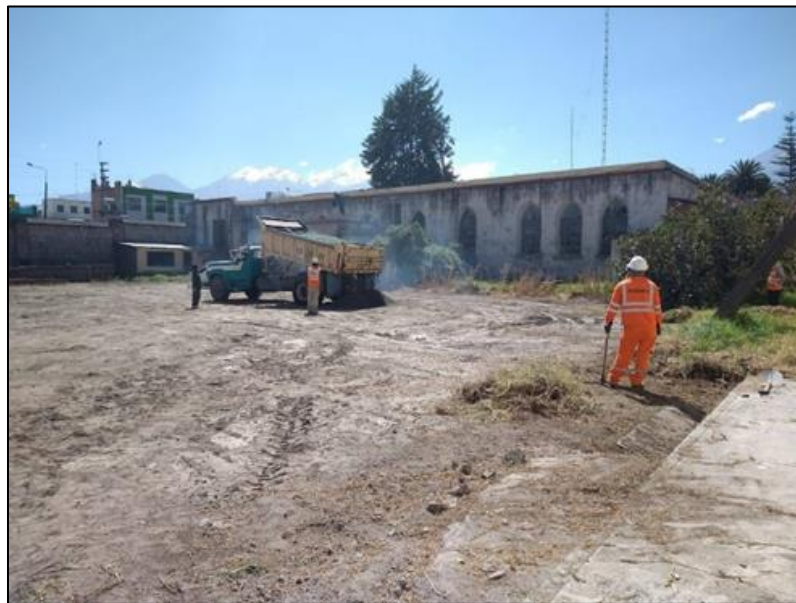
Figura 26 Construcción de piso para estacionamiento
