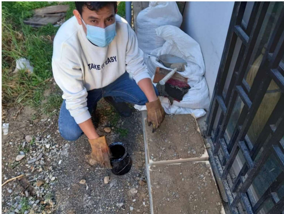
Ilustración 72 Imprimación de la Base granular
