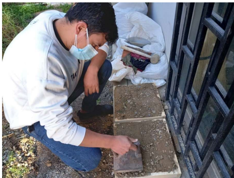
Ilustración 20 Compactación de Base Granular en el Molde
