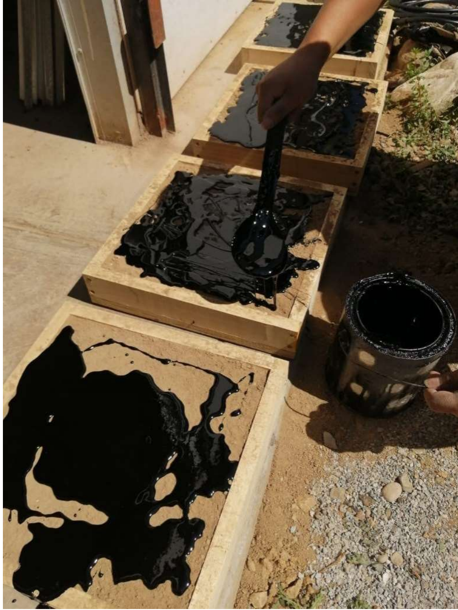
Ilustración 73 Moldes con Base Granular imprimados
