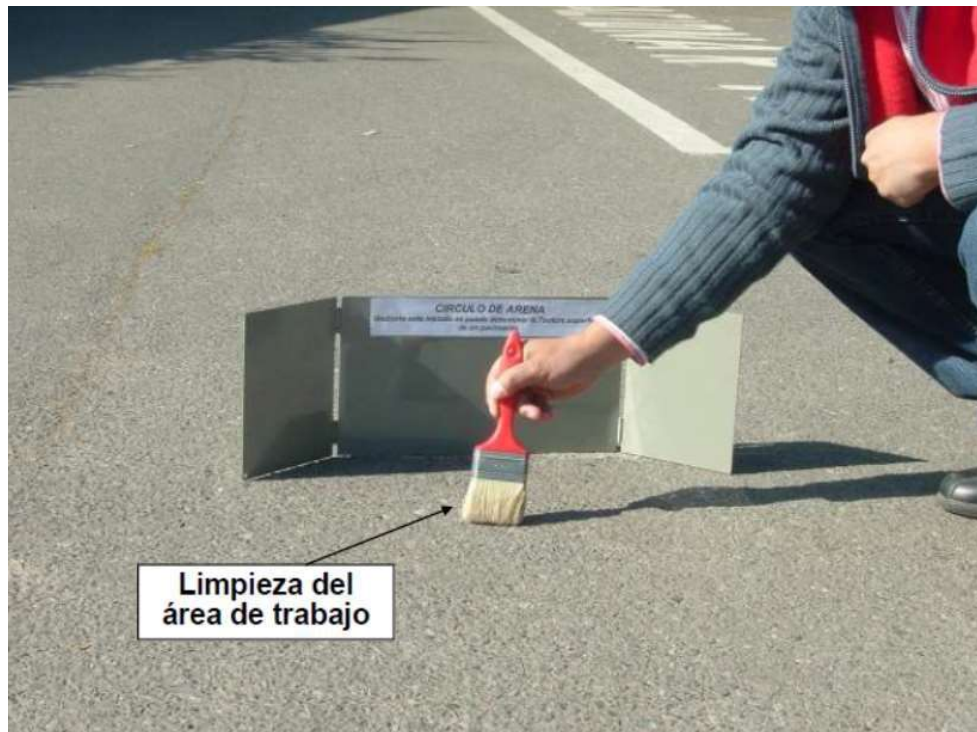
Ilustración 6 Limpieza del área de trabajo para realizar ensayo de círculo de arena
