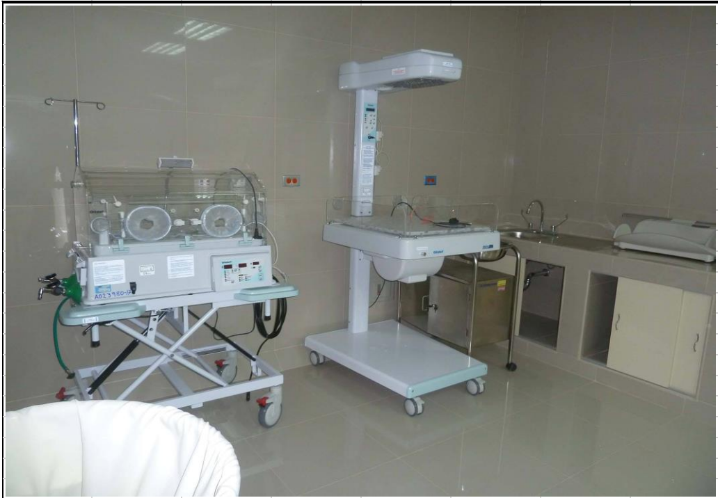
EN LA VISTA SE APRECIA LA CULMINACIÓN DE LOS AMBIENTES DE SALAS DE ATENCIÓN AL RECIÉN NACIDO DEL PROYECTO "MEJORAMIENTO DE LOS SERVICIOS DE SALUD DEL CENTRO DE SALUD DE SANTA ANA, DE LA MICRO RED SANTANA, RED HUANCAVELICA"
