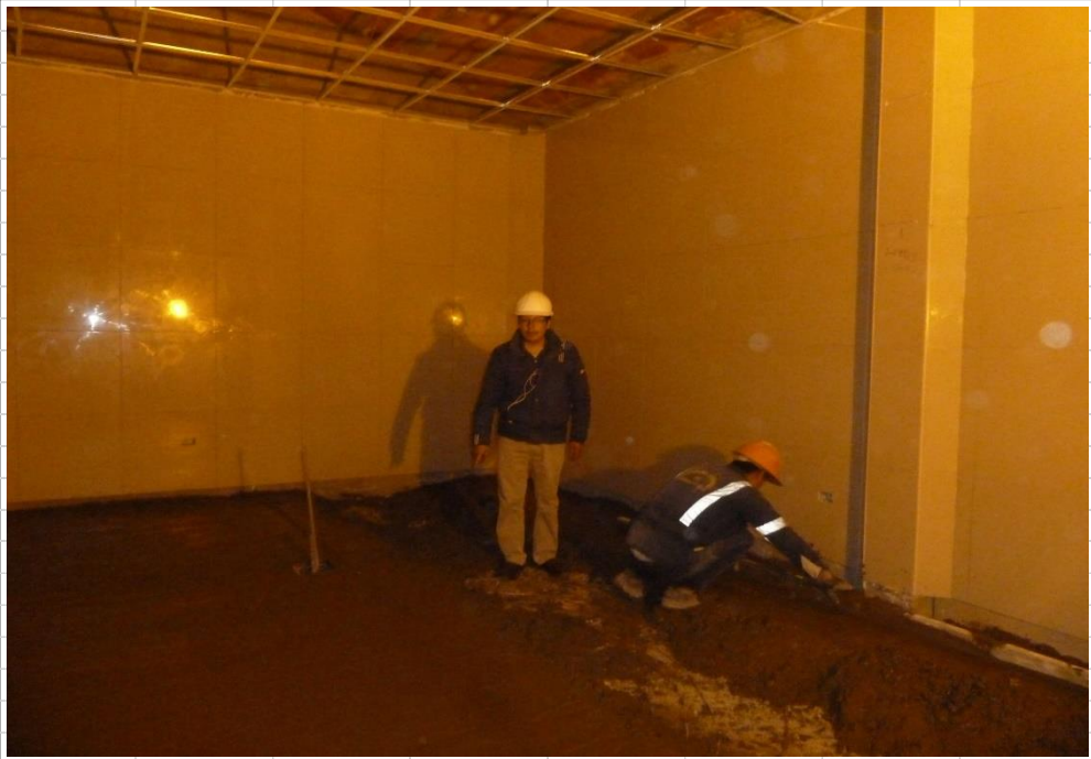
EN LA VISTA SE APRECIA EL LLENADO PARA FALSO PISO DE CONCRETO EN LA SALA DE OPERACIONES DEL PROYECTO: "MEJORAMIENTO DE LOS SERVICIOS DE SALUD DEL CENTRO DE SALUD DE SANTA ANA, DE LA MICRO RED SANTANA, RED HUANCAVELICA"
