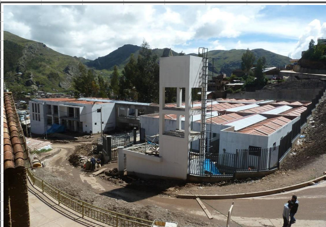
SE APRECIA UNA VISTA PANORAMICA EXTERIOR DE TODOS LOS AMBIENTES, FALTANDO POCO PARA LA CULMINACION DEL PROYECTO "MEJORAMIENTO DE LOS SERVICIOS DE SALUD DEL CENTRO DE SALUD DE SANTA ANA, DE LA MICRO RED SANTANA, RED HUANCVELICA"
