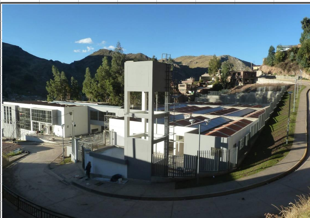
SE APRECIA UNA VISTA PANORAMICA EXTERIOR DE TODOS LOS AMBIENTES, Y LA CULMINACION FINAL DEL PROYECTO "MEJORAMIENTO DE LOS SERVICIOS DE SALUD DEL CENTRO DE SALUD DE SANTA ANA, DE LA MICRO RED SANTANA, RED HUANCVELICA"
