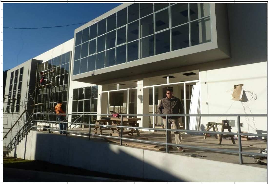
EN LA VISTA SE APRECIA EL COLOCADO DE VENTANAS PARA LA ZONA EXTERIOR DEL PROYECTO “MEJORAMIENTO DE LOS SERVICIOS DE SALUD DEL CENTRO DE SALUD DE SANTA ANA, DE LA MICRO RED SANTANA, RED HUANCAVELICA”
