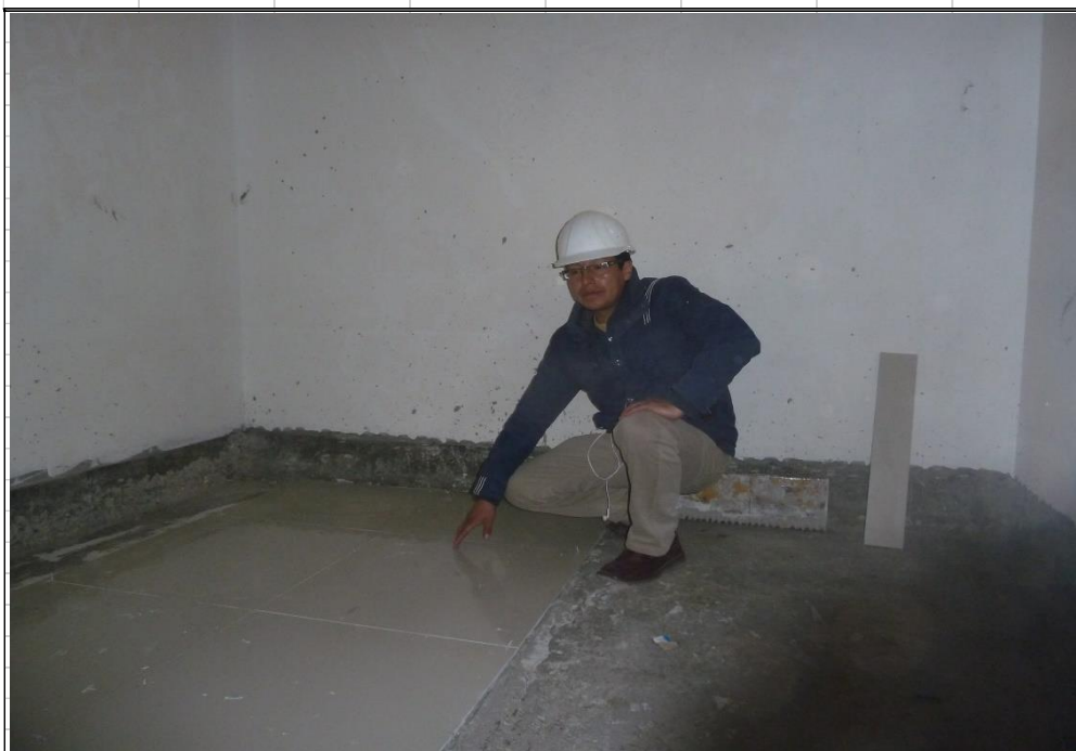
EN LA VISTA SE APRECIA LA PARTICIPACION EN LA VERIFICACION DE LOS ACABADOS DE PISOS CON PORCELANATO DE 60 X 60 CM, EN LOS AMBIENTES DEL PROYECTO "MEJORAMIENTO DE LOS SERVICIOS DE SALUD DEL CENTRO DE SALUD DE SANTA ANA, DE LA MICRO RED SANTANA, RED HUANCAVELICA"
