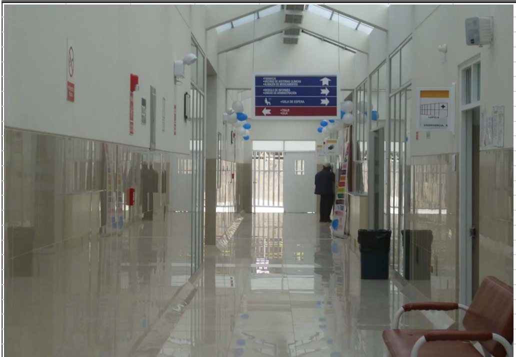
EN LA VISTA SE APRECIA LA CULMINACIÓN DE TODOS LOS TRABAJOS DE ACABADOS, PISOS DE PORCELANATOS, PAREDES TARRAJEADAS Y PINTADAS, CON INSTALACIONES ELÉCTRICAS, SANITARIAS, CÁMARAS, SISTEMAS CONTRA INCENDIO, VENTANAS, SEÑALÉTICA, ACCESOS Y PASADIZOS EN EL PROYECTO "MEJORAMIENTO DE LOS SERVICIOS DE SALUD DEL CENTRO DE SALUD DE SANTA ANA, DE LA MICRO RED SANTANA, RED HUANCAVELICA"
