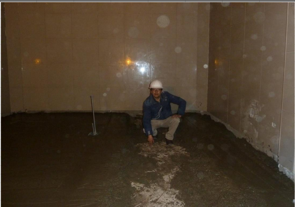
EN LA VISTA SE APRECIA LA PARTICIPACIÓN EN LA INSPECCIÓN COMO PARTE TÉCNICA, EN LLENADO PARA FALSO PISO DE CONCRETO EN LA SALA DE OPERACIONES DEL PROYECTO: "MEJORAMIENTO DE LOS SERVICIOS DE SALUD DEL CENTRO DE SALUD DE SANTA ANA, DE LA MICRO RED SANTANA, RED HUANCAVELICA"
