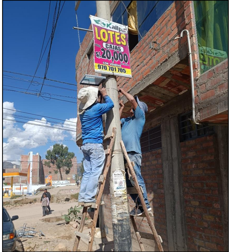
Fotografía 8: Instalación de estructura metálica y colocación de placa de vidrio (Punto NP - 9).
