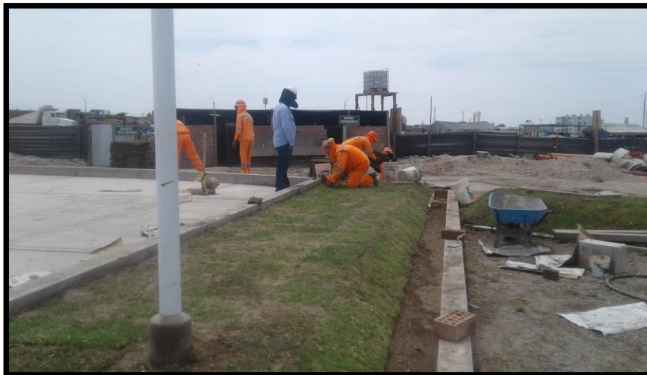
Imagen 300 Colocación de bloques de Grass en zona verde de la plaza.
