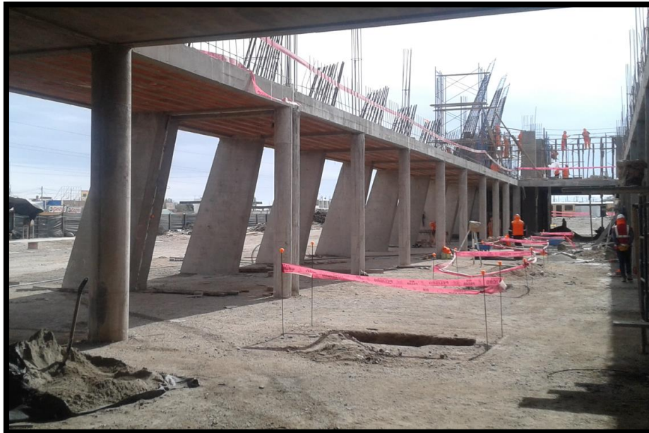
Imagen 109 Excavación para cimentación de la sub estructura para la rampa de acceso para discapacitados.
