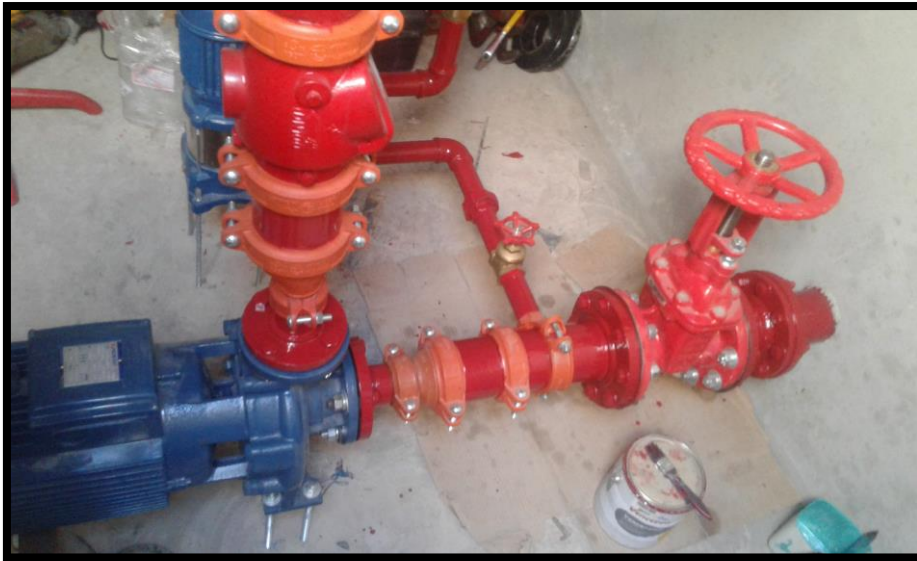
Imagen 73 verificación de la instalación de bomba hidráulica.
