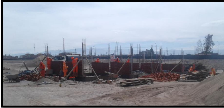
Imagen 121 Colocación de asentado de ladrillo para muros portantes de albañilería.
