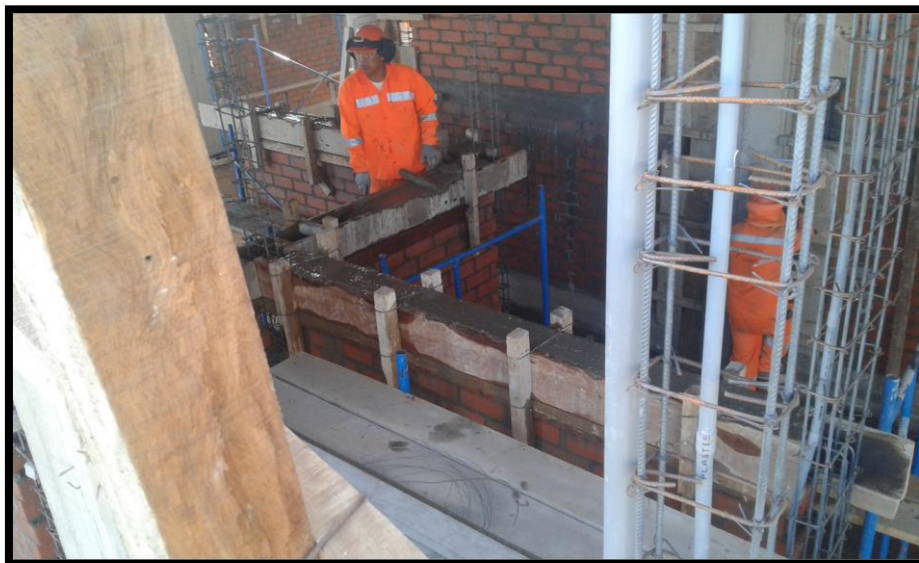
Imagen 117 Encofrado de viga intermedia de confinamiento de muro de albañilería.
