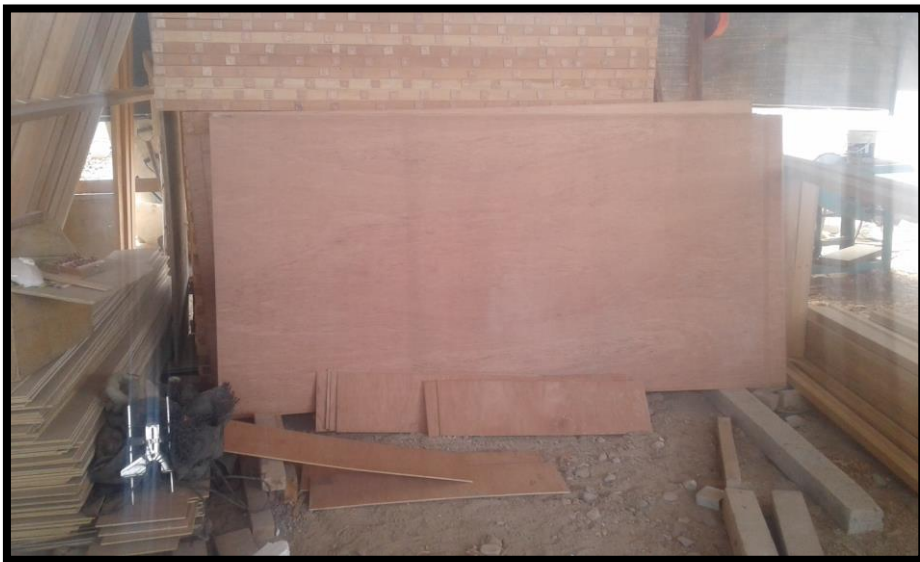
Imagen 159 Estructura de puerta contra placada.
