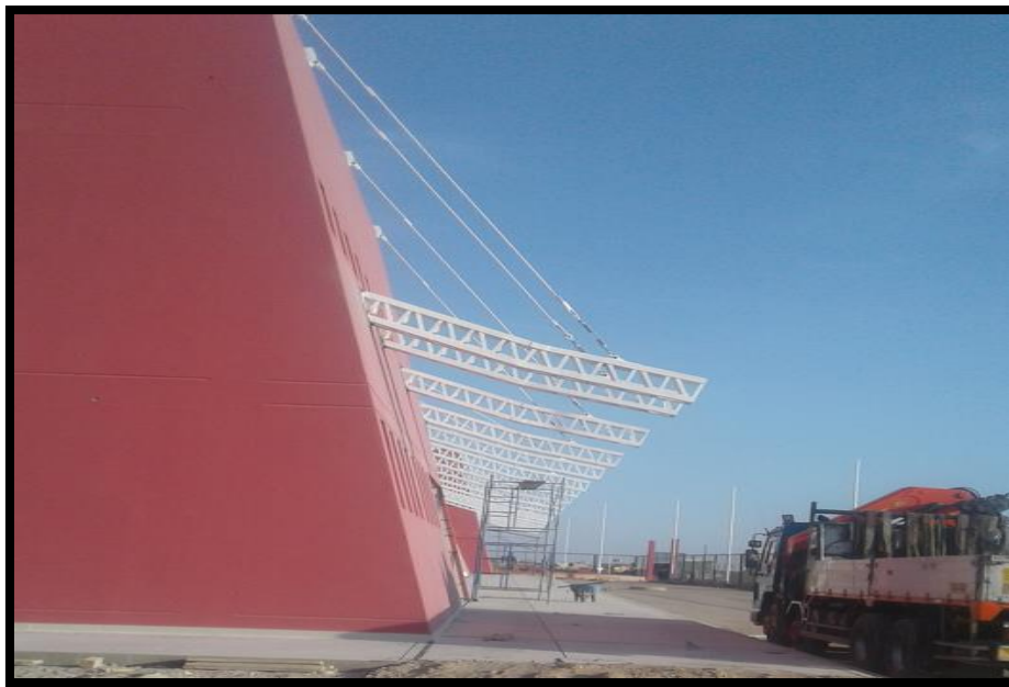
Imagen 127 Culminación de colocación de armaduras en plancha de acero soldado.
