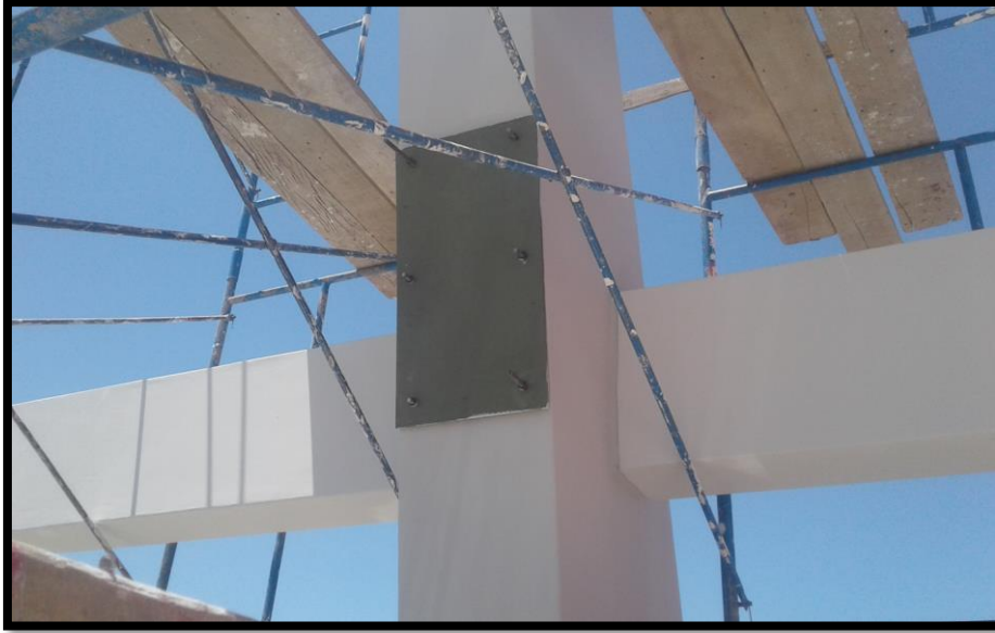
Imagen 123 Colocación de plancha 800x450x3/8" de unión de columna de concreto y armadura de acero.
