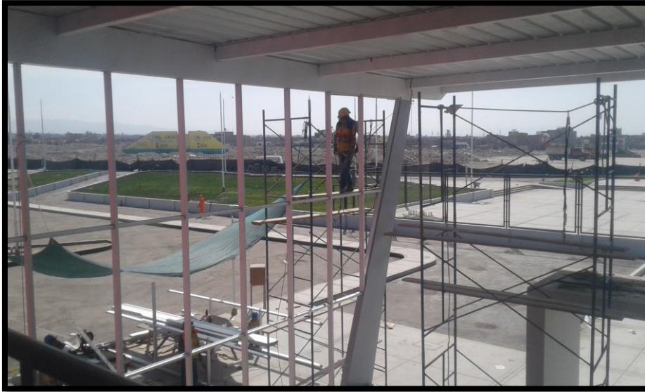
Imagen 173 Colocación de estructura de aluminio para colocación de vidrios.
