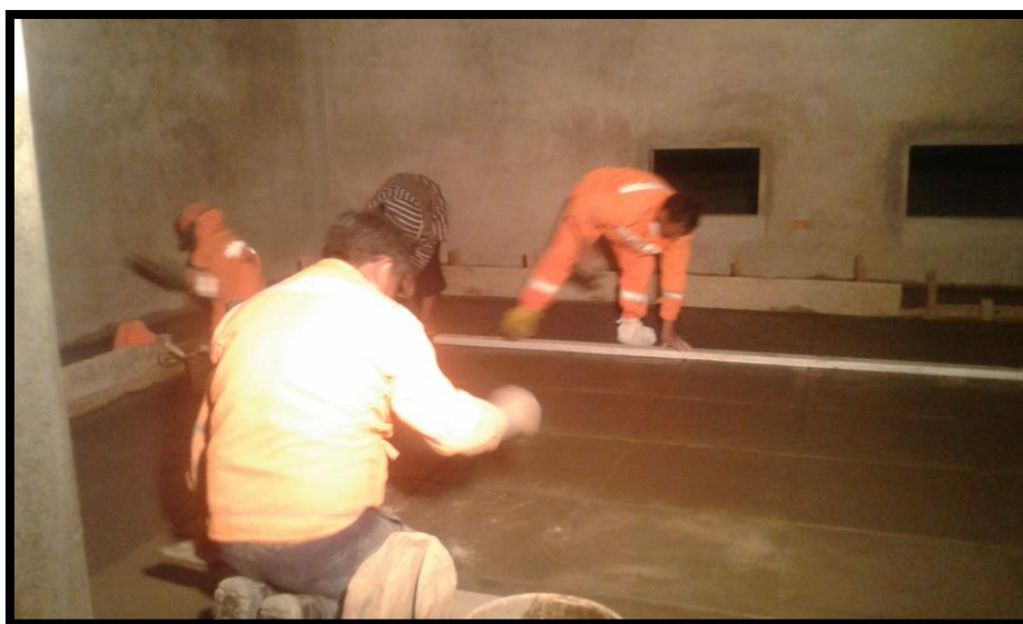
Imagen 144 Piso de cemento pulido en cuarto de máquinas.
