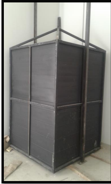
Imagen 214 Instalación de montacarga 10HP.
