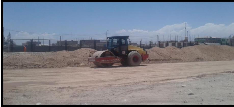
Imagen 312 Compactación de base granular.
