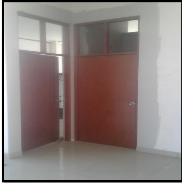
Imagen 163 Colocación de puertas contra placadas.
