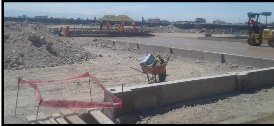
Imagen 287 Trabajo de RELLENO COMPACTADO CON MATERIAL PROPIO CONCRETO SIMPLE
