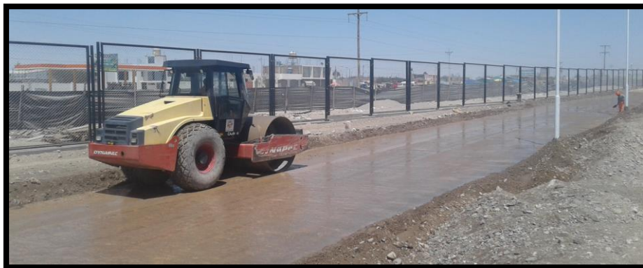
Imagen 312 Compactación de base granular.
