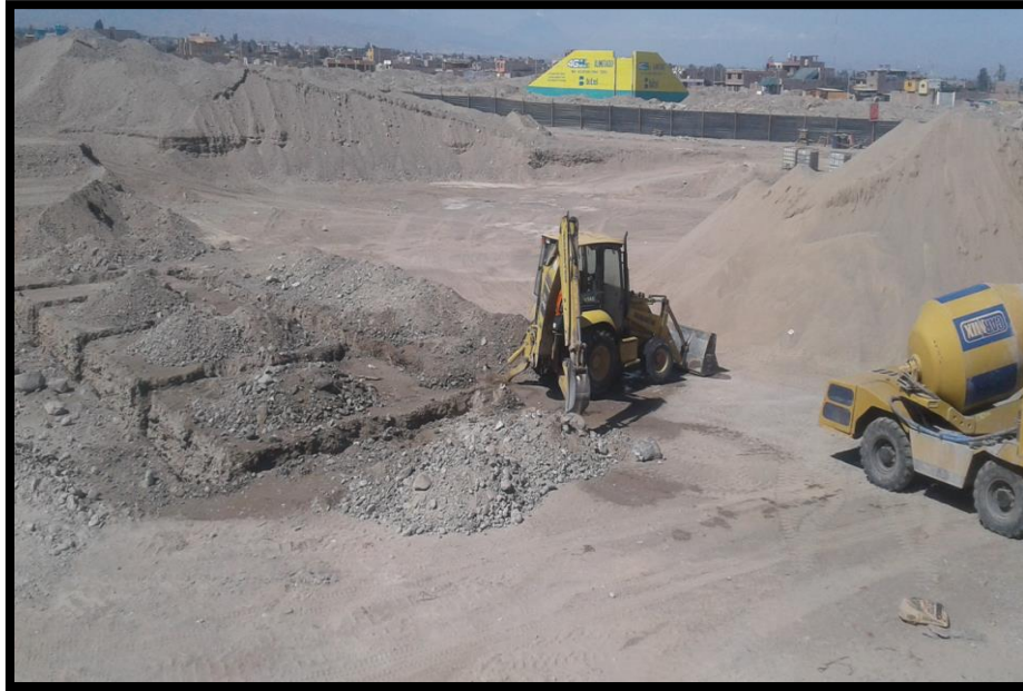
Imagen 84 Excavación de zanja de cimentación.
