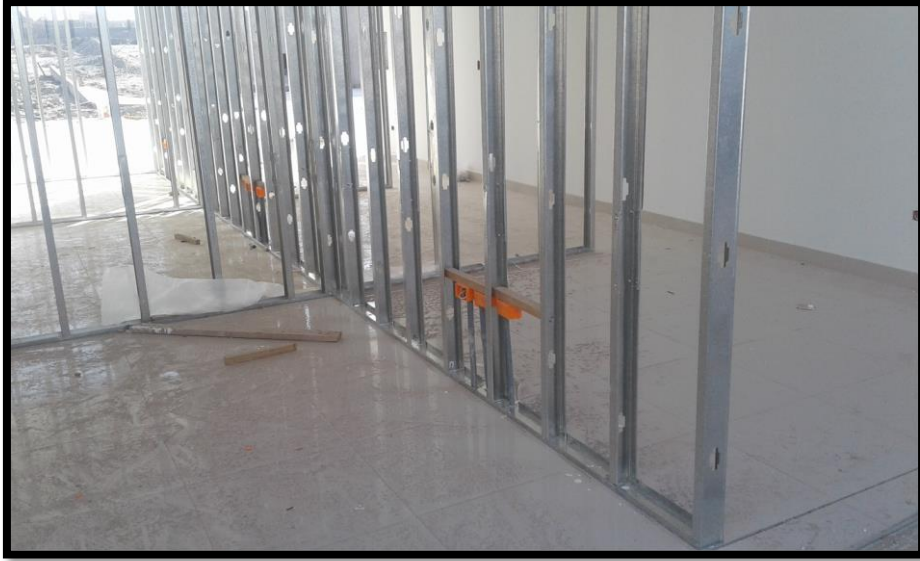
Imagen 138 Colocación de tomacorrientes en el muro de perfiles de acero.
