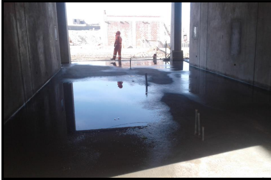
Imagen 94 Falso piso en la edificación primer nivel.
