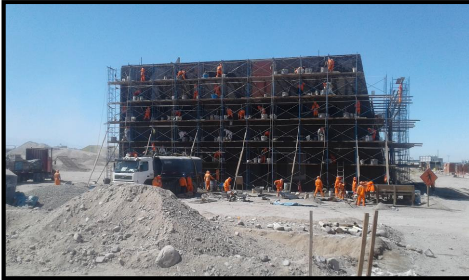
Imagen 132 Tarrajeo en muros exteriores de edificación de terminal.
