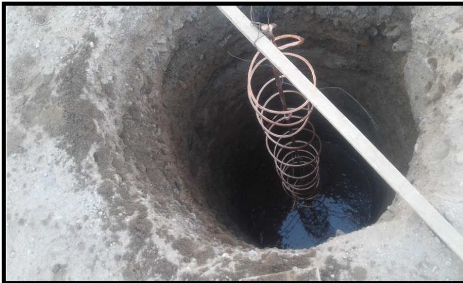
Imagen 63 Colocación de Thor gel a pozo a tierra
