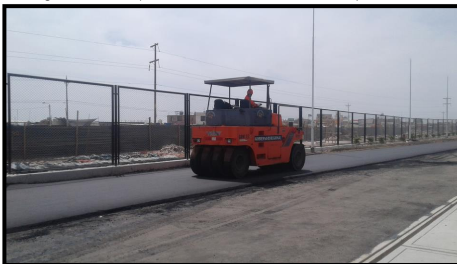
Imagen 320 Compactación con rodillo liso la carpeta asfáltica.
