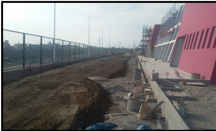
Imagen 313 Compactación de base granular.
