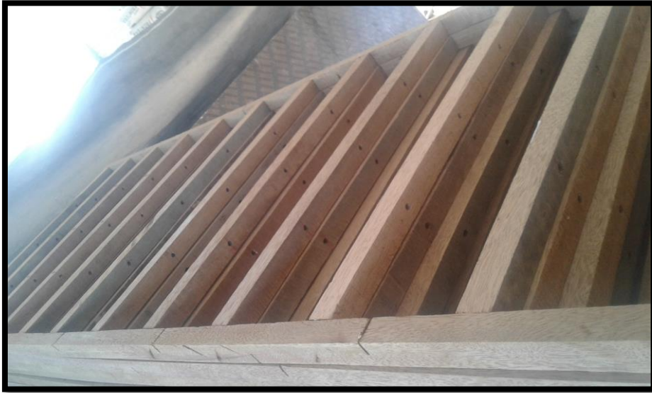
Imagen 159 Estructura de puerta contra placada.
