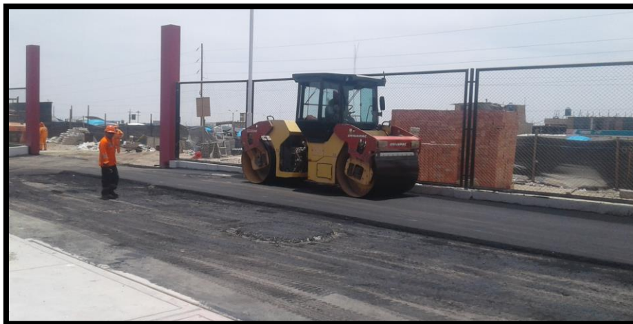
Imagen 319 Colocación de carpeta asfáltica.
