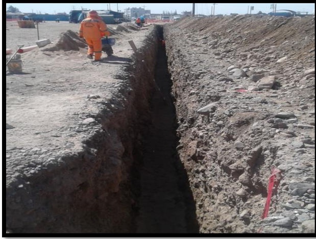
Imagen 271 Excavación de zanja para desagüe.
