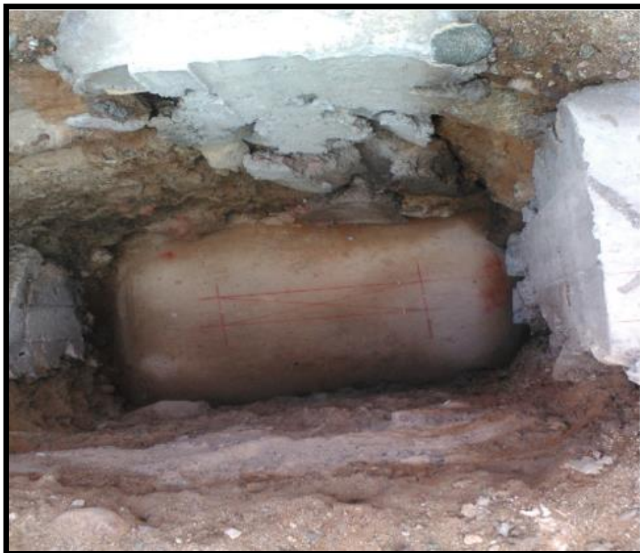
Imagen 88 Solado para vigas de cimentación.
