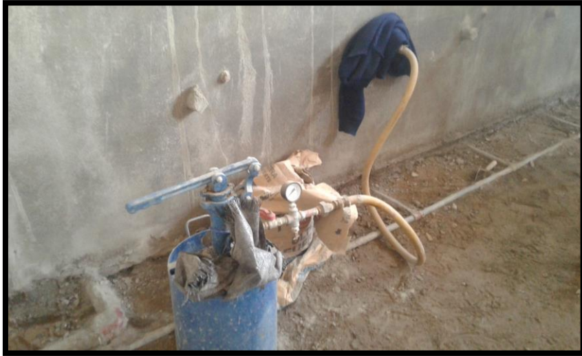
Imagen 60 Prueba hidráulica en la red de batería de baño
