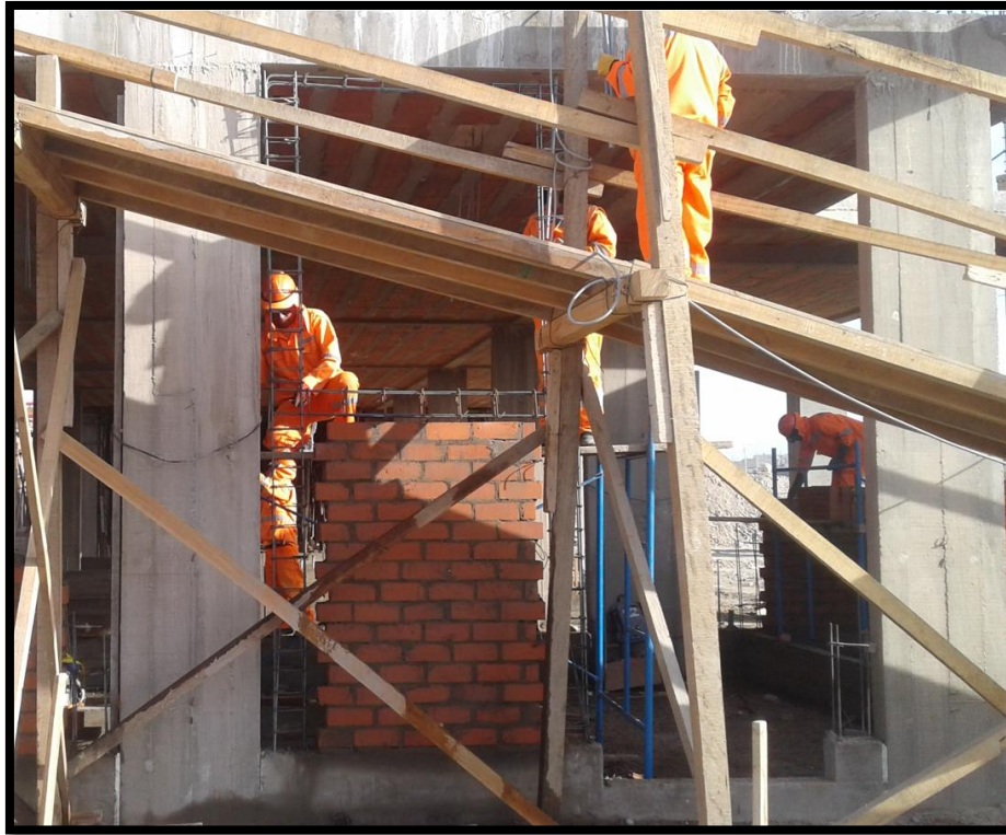
Imagen 56 Se aprecia la colocación de acero de confinamiento en el muro y el asentamiento de muro.
