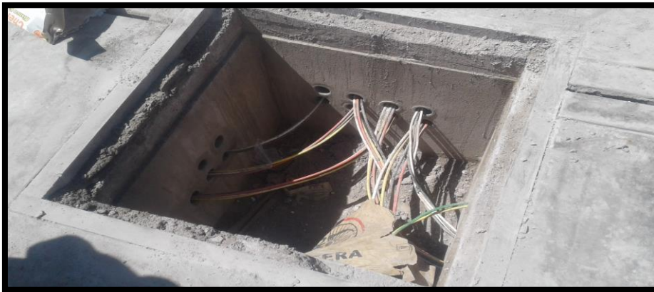
Imagen 224 Colocación de ductos de concreto 4 vías.
