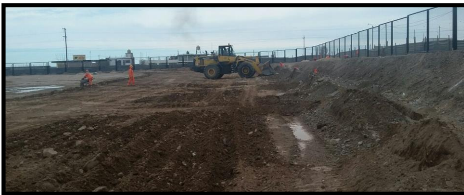
Imagen 310 Humedecimiento de base granular.
