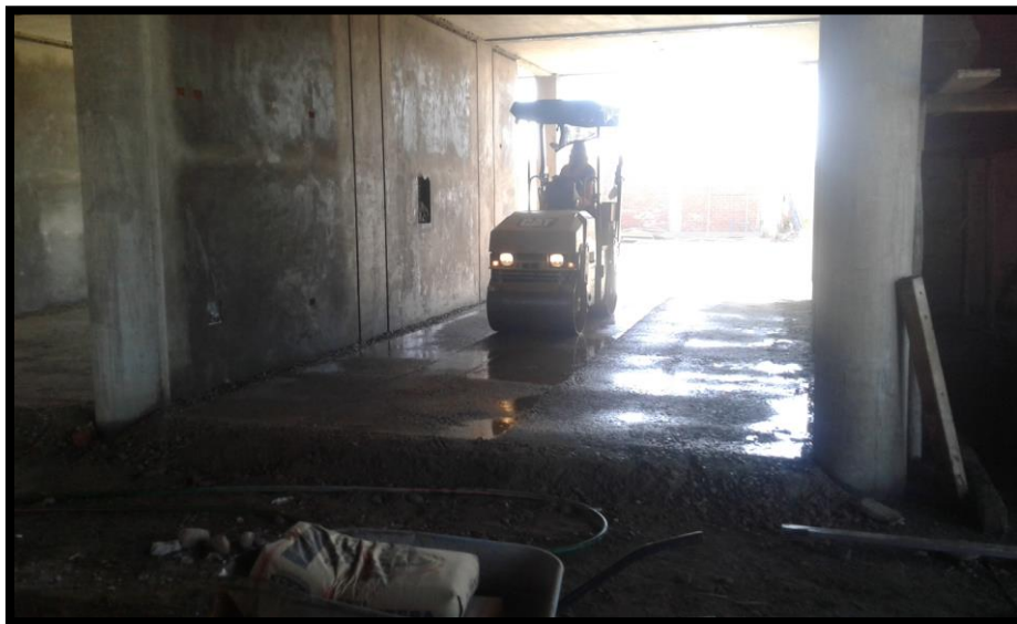
Imagen 86 Nivelación y apisonado para cimentación.
