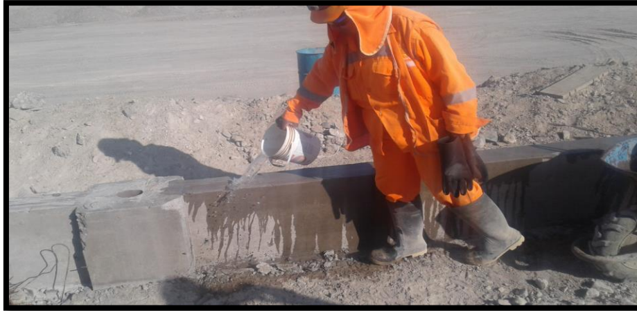
Imagen 279 Curado cimiento de concreto.
