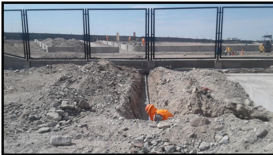
Imagen 247 Excavación de tubería de agua fría para áreas verdes.
