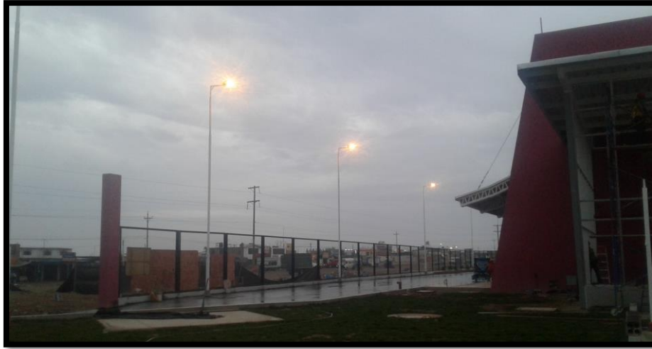
Imagen 221 Prueba de poste pastoral doble y cuádruple de 12 m 03.08 CANALIZACION CONDUCTOS O TUBERIA
