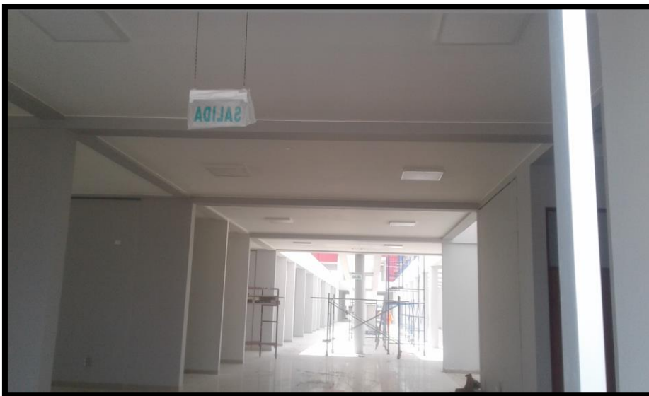
Imagen 201 Colocación de reflector en estructura liviana.
