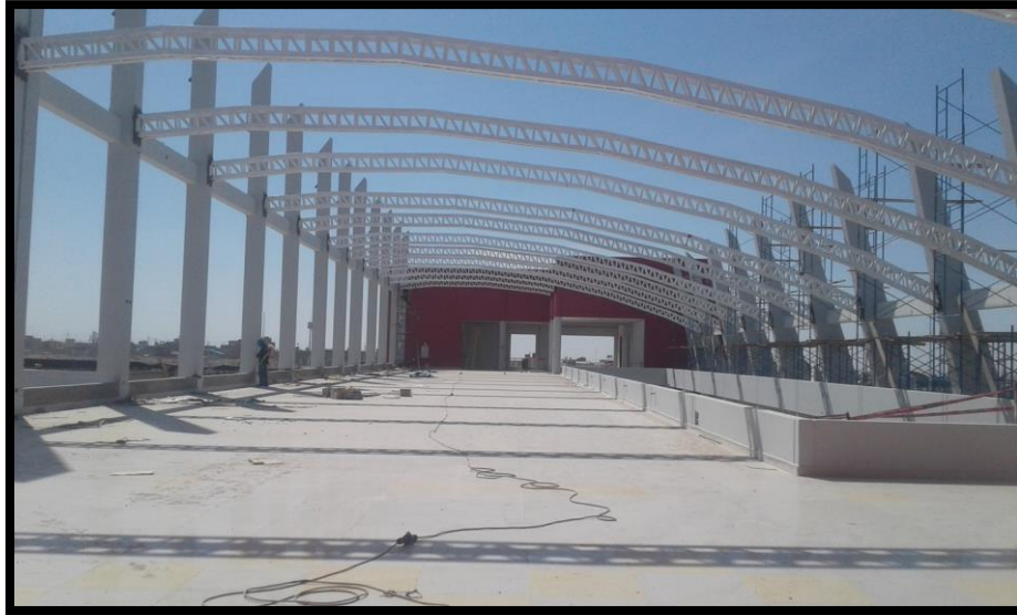
Imagen 127 Culminación de colocación de armaduras en plancha de acero soldado.
