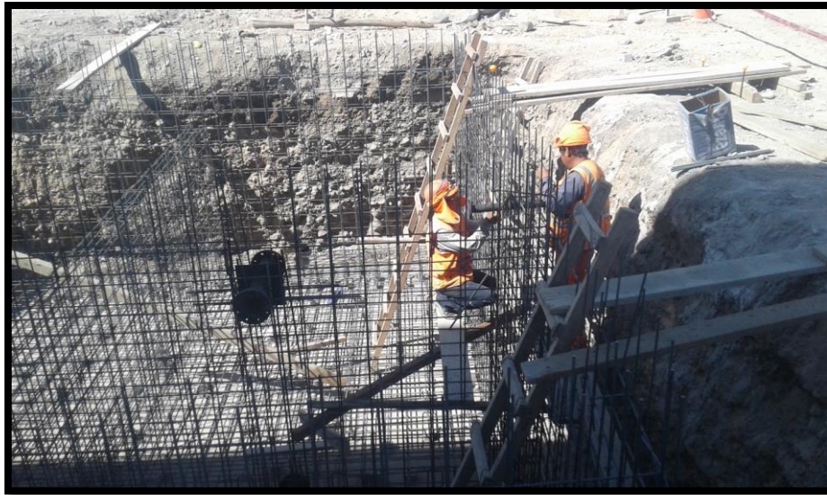
Imagen 263 Colocación de armadura de acero y brida rompe agua en la cisterna.
