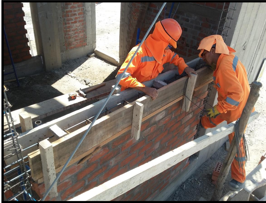
Imagen 117 Encofrado de viga intermedia de confinamiento de muro de albañilería.
