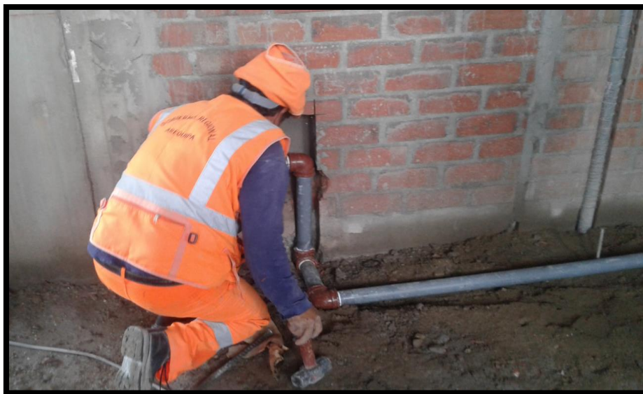
Imagen 243 Instalación de agua de tubería para instalaciones sanitarias fluxómetro.
