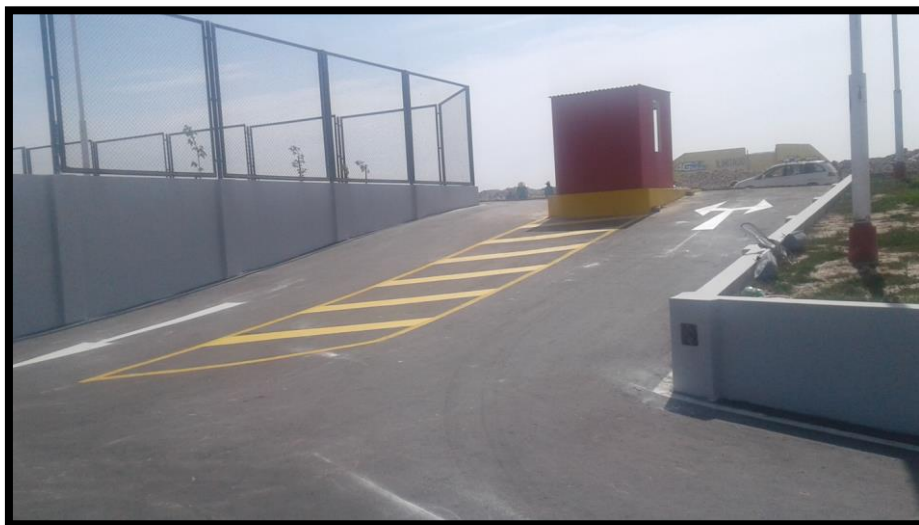
Imagen 328 Pintado de señalización de flujo de vía.
