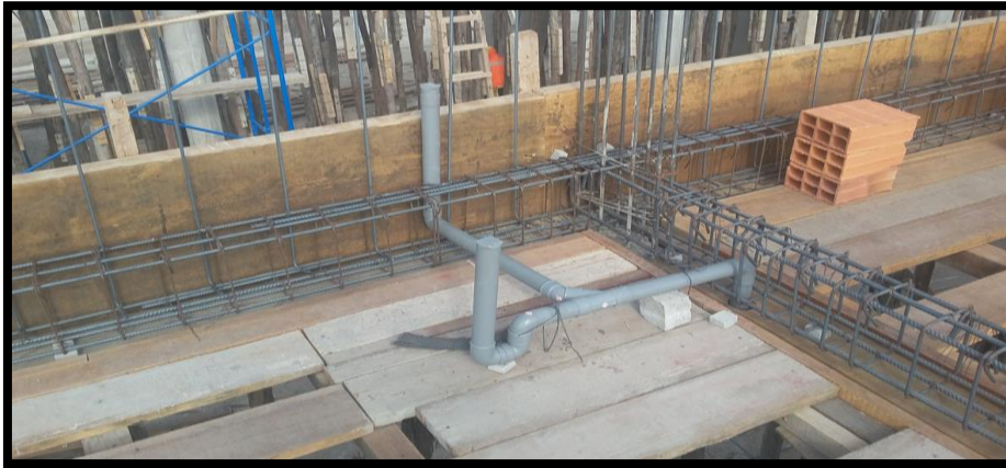
Imagen 258 Instalación de batería de desagüe en el segundo nivel.
