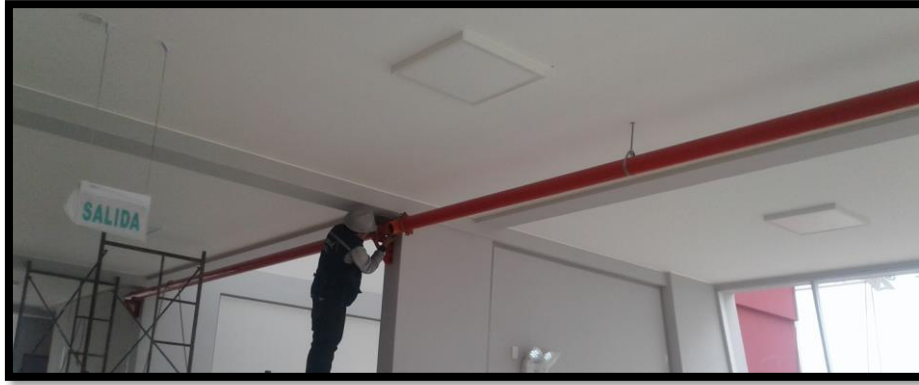
Imagen 265 Red de distribución con tubería SCH 40 2-1/2"
