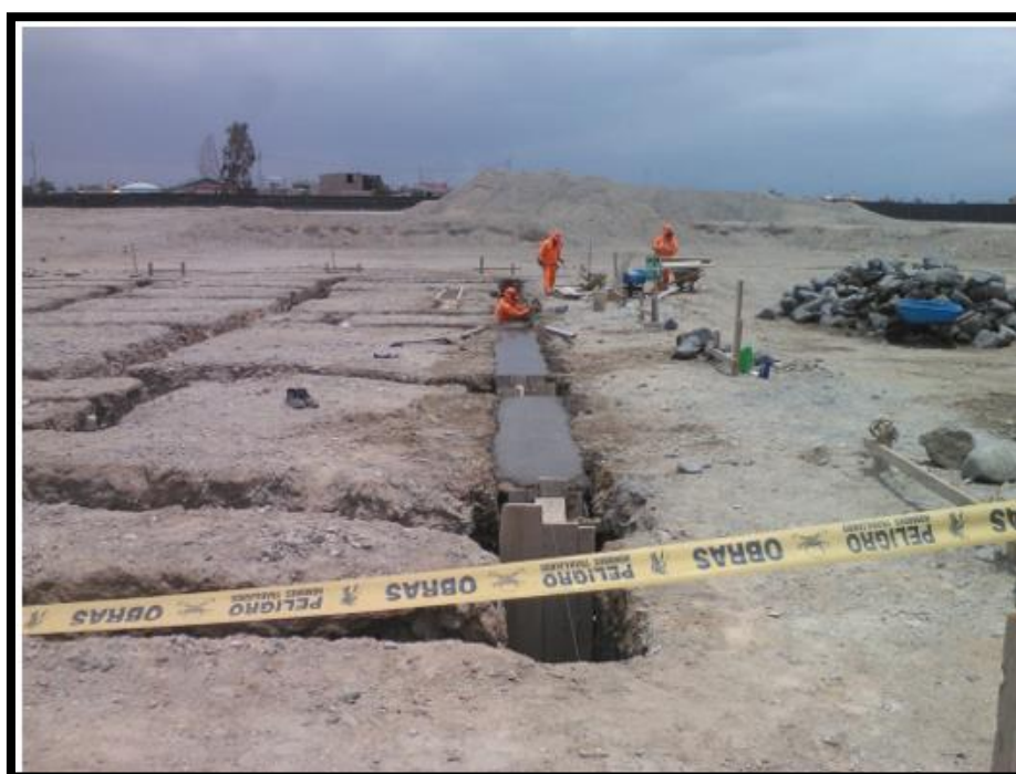
Imagen 90 Colocación de concreto cimienta corrido mezcla 1:8 (100 kg/cm 2 ) + 30% P.M
