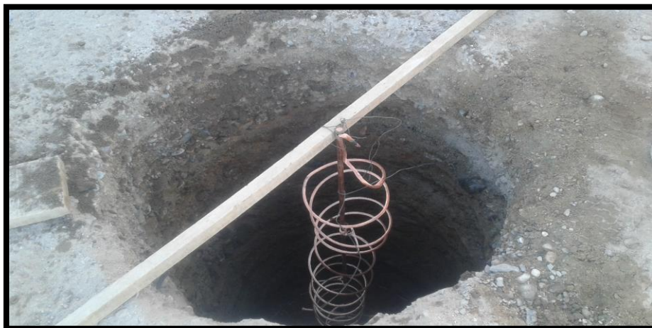
Imagen 215 Colocación de varilla electrolítico.
