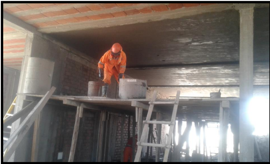
Imagen 141 Colocación de tarrajeo en cielo raso.
