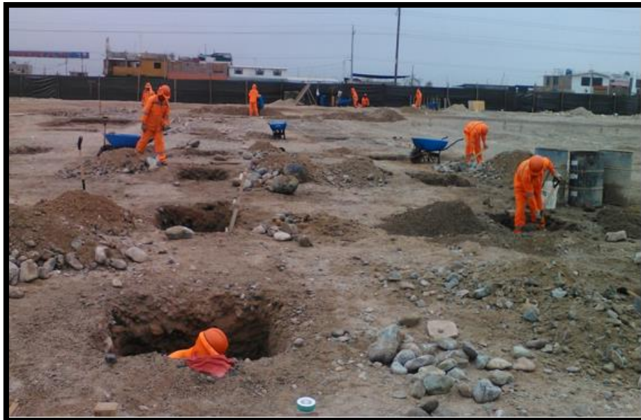
Imagen 83 Excavación de zapatas para cimentación de la edificación.
