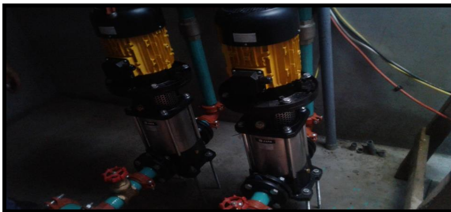
Imagen 253 Instalación de MANIFOLD.
