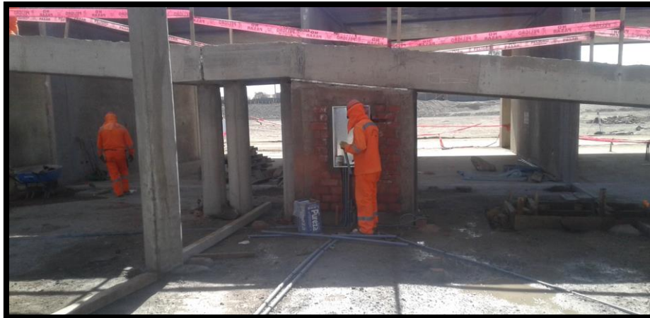
Imagen 222 Tendido de tubería hacia tablero eléctrico.
