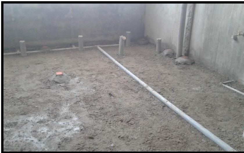
Imagen 59 Colocación de red de agua en la batería de baño Paso 3) PRUEBA DE PRESIÓN DE BATERÍA DE BAÑOS:
