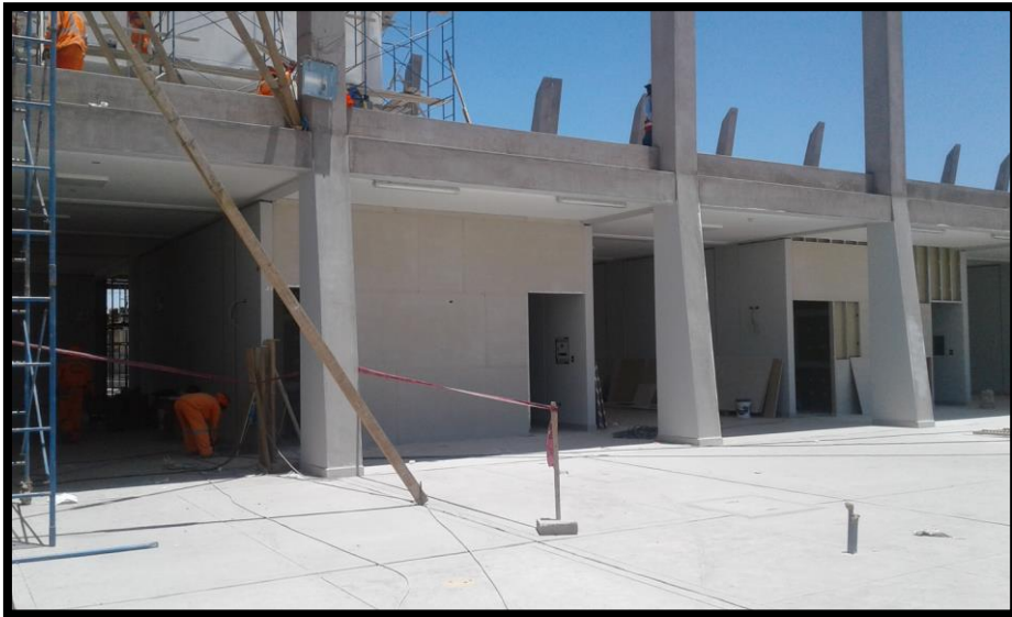
Imagen 139 Culminación de muro de tabiquería Drywall.
