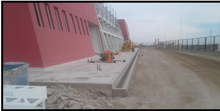
Imagen 255 Vaciado de canal de drenaje pluvial en la zona de embarque.
