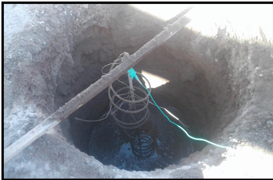
Imagen 65 Prueba de resistencia del pozo a tierra.
