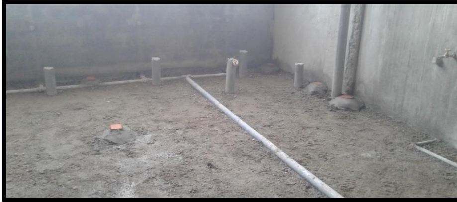
Imagen 243 Instalación de agua de tubería para instalaciones sanitarias fluxómetro.
