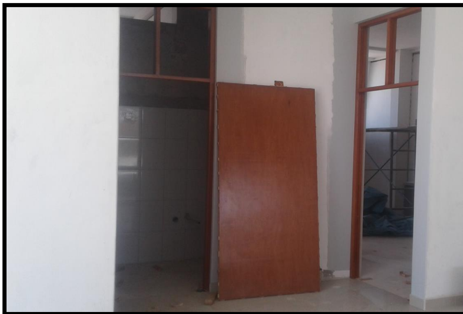
Imagen 161 Colocación de puerta contra placada de madera en el segundo nivel.
