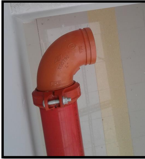
Imagen 265 Red de distribución con tubería SCH 40 2-1/2"
