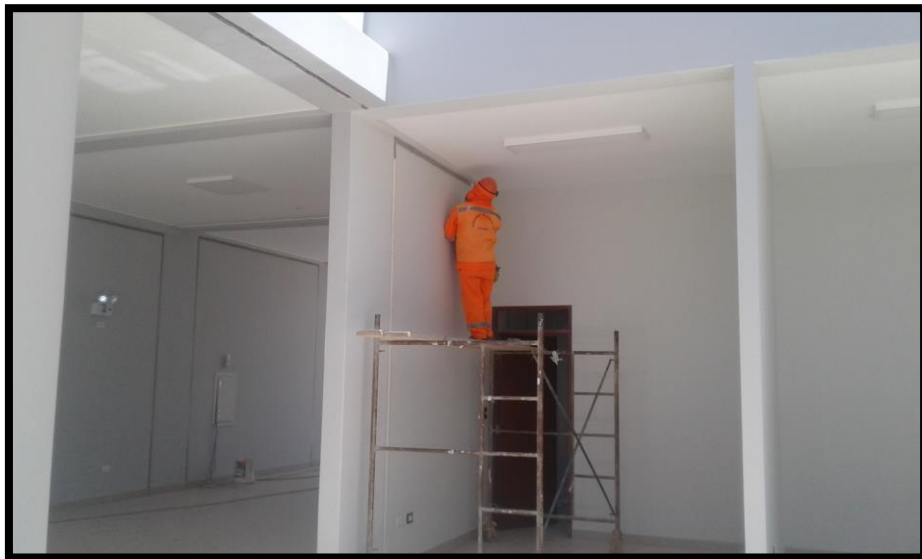
Imagen 198 Colocación de junta de construcción de 1"
