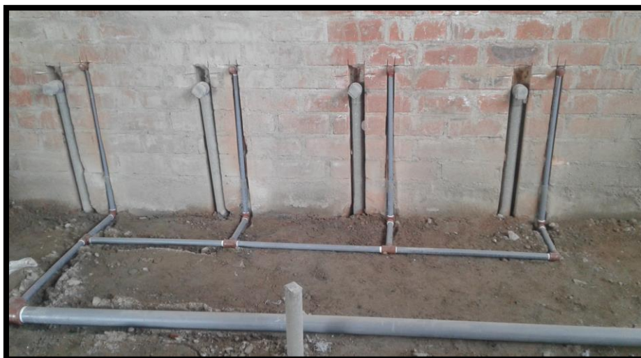
Imagen 244 Instalación de tubería de agua fría.
