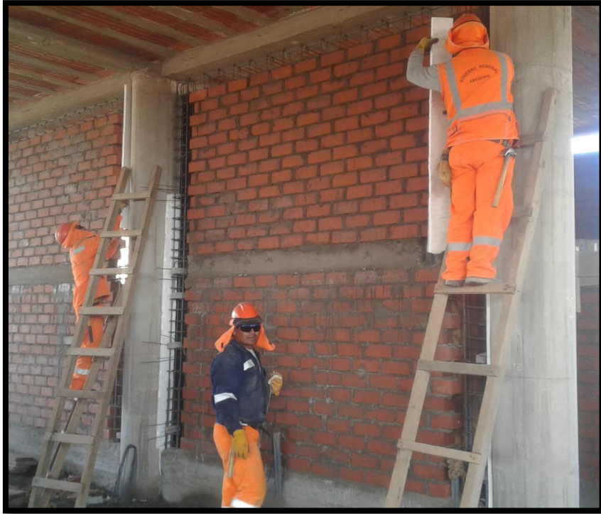
Imagen 57 Verificación de colocación de Tecnopor para el aislamiento del muro.
