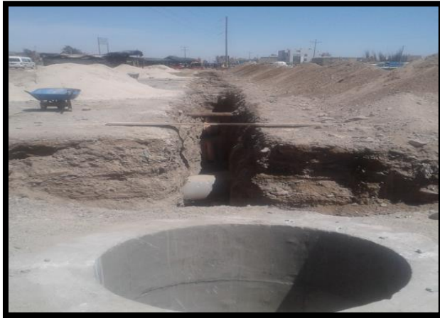
Imagen 271 Excavación de zanja para desagüe.
