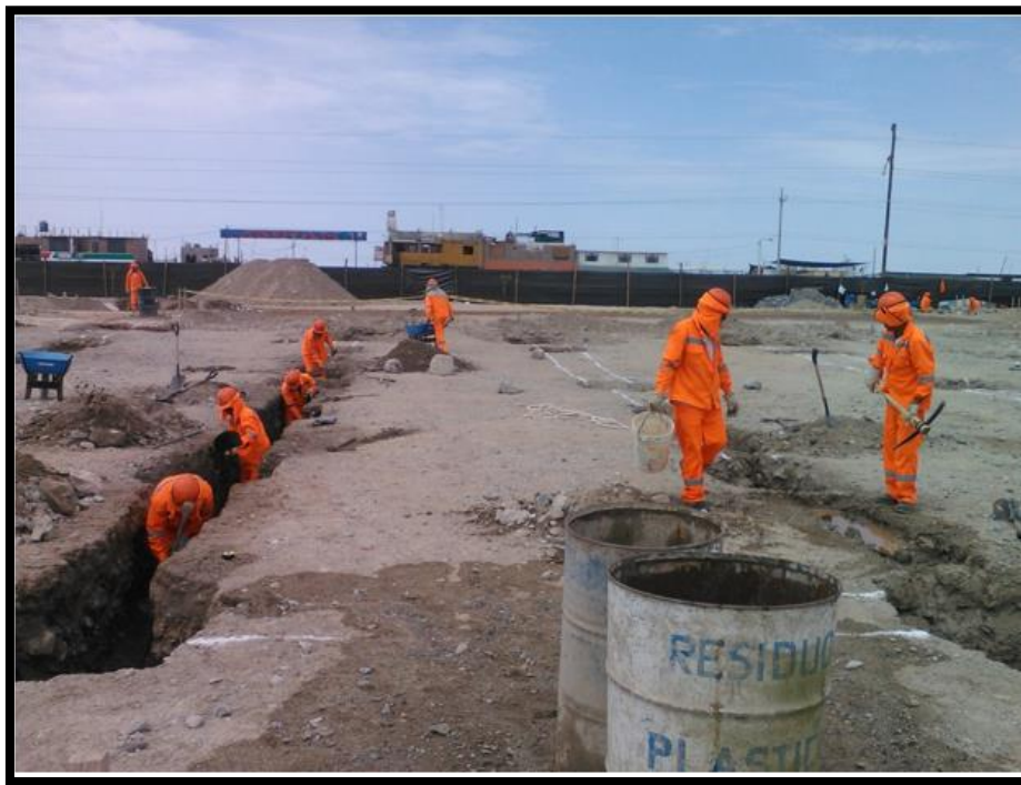
Imagen 84 Excavación de zanja de cimentación.
