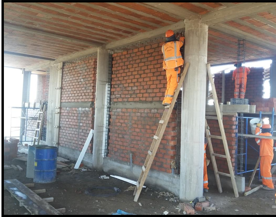
Imagen 119 Colocación de armadura de acero de columnas y vigas de confinamiento para muros no estructurales de albañilería. ALBAÑILERIA
