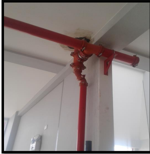
Imagen 268 Red de distribución con tubería SCH 40 2-1/2"
