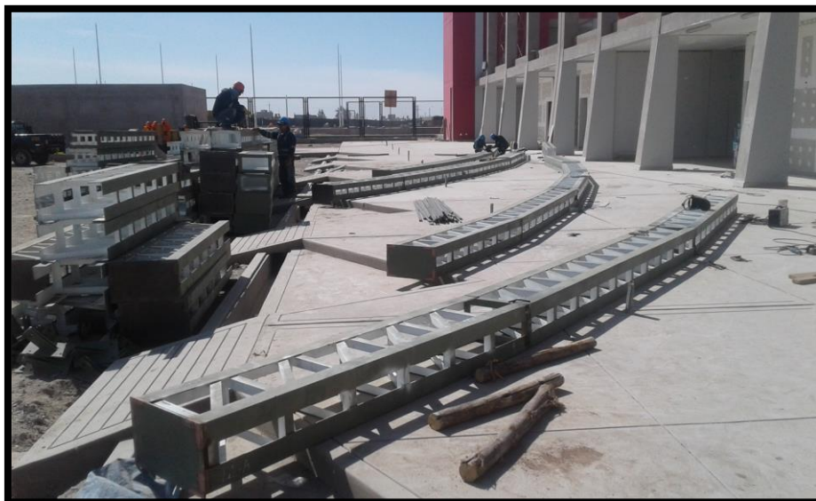
Imagen 122 Armado de armadura para cobertura.
