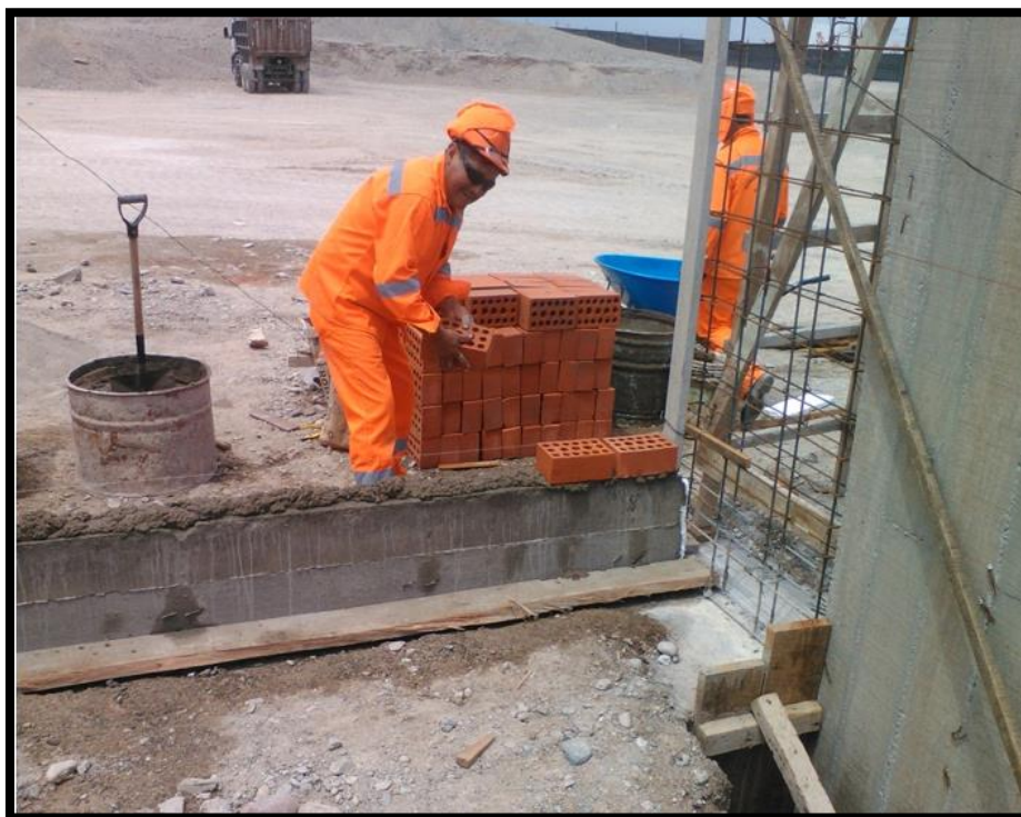
Imagen 92 sobrecimiento f'c=172 \text{ kgf/cm}^2 culminado. FALSO PISO
