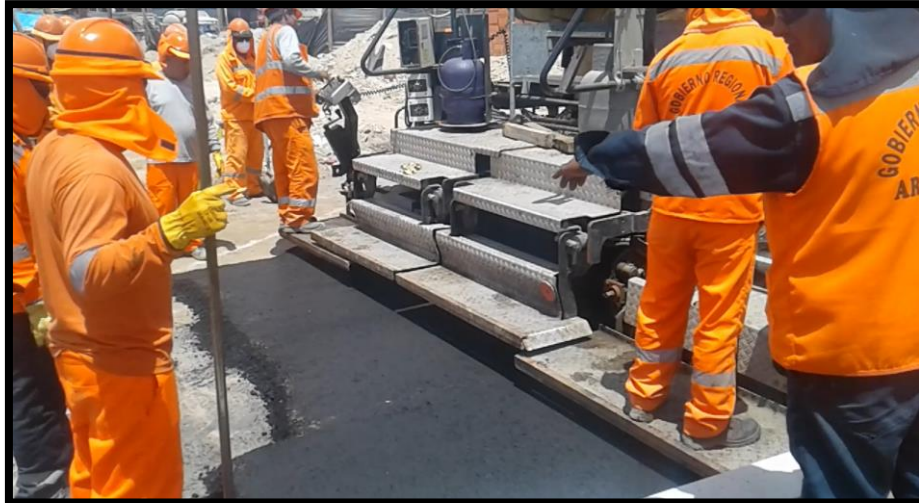
Imagen 319 Colocación de carpeta asfáltica.
