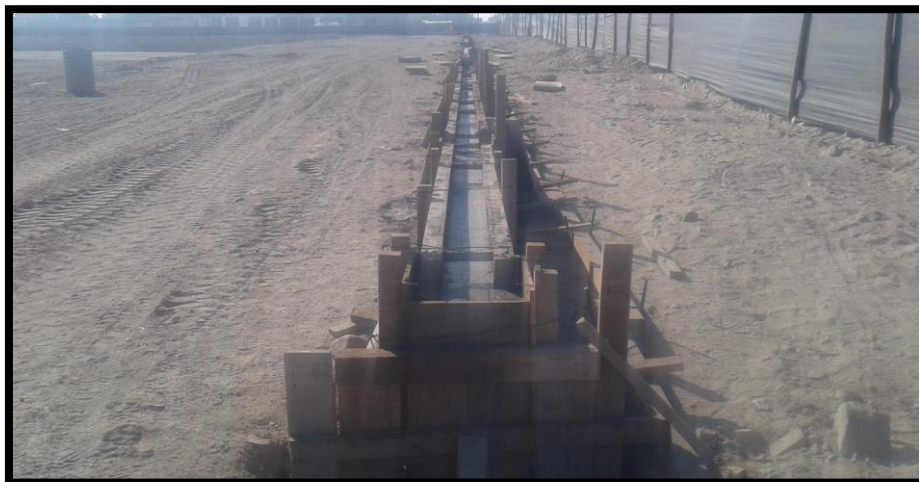
Imagen 277 Encofrado para cimientos CONCRETO F'C=175KG/CM2
