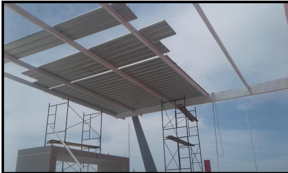
Imagen 177 Colocación de cobertura TV4, según especificaciones técnicas.
