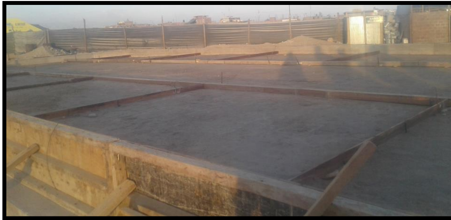
Imagen 289 Vaciado de sobrecimiento CONCRETO PARA GRADERIAS 1:8 (100KG/CM2) + 30% P.G.
