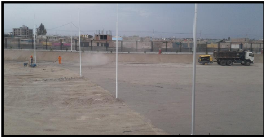
Imagen 316 Colocación de arenado en imprimante asfáltico.
