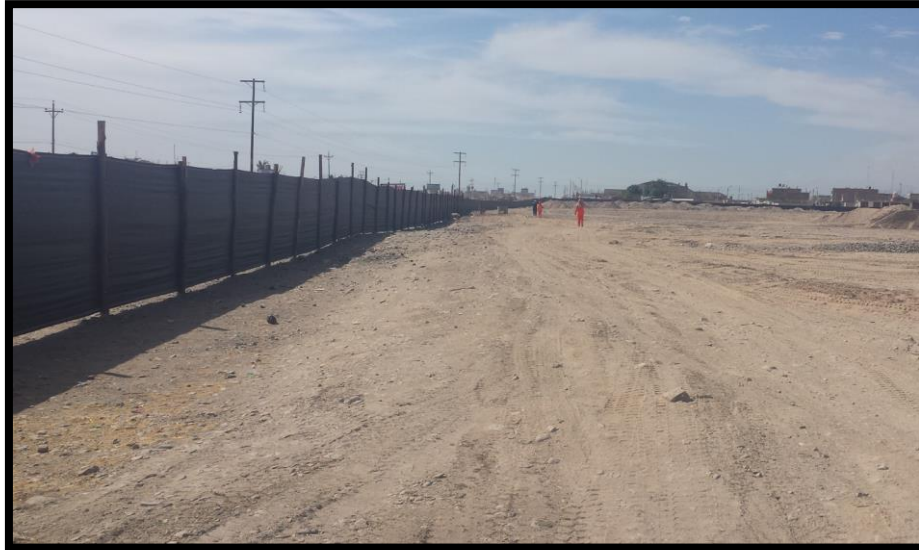
Imagen 79 Se aprecia los trabajos de colocación de cerco provisional de Obra OFICINA DE OBRA
