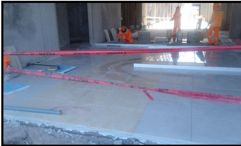
Imagen 145 Colocación de viga de porcelanato en edificaciones.
