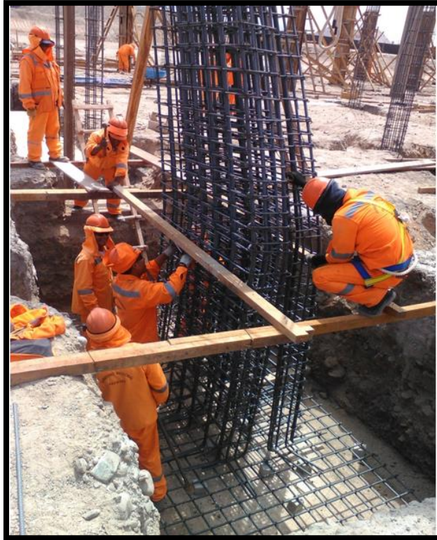
Imagen 97 Colocación de acero de zapata y columnas de concreto armado, en la edificación de terminal terrestre.
