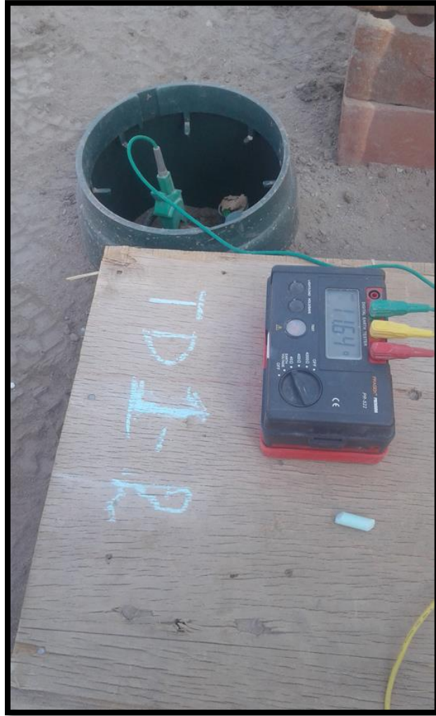
Imagen 68 Prueba de resistencia de Pozo a tierra
