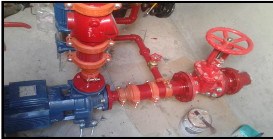
Imagen 250 Instalación de ELECTROBOMBA 1.00 HP
