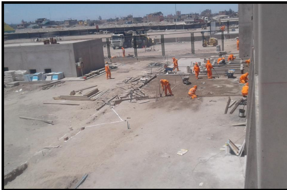
Imagen 151 Vereda de concreto, realización de tarrajeo para acabado de cemento pulido.
