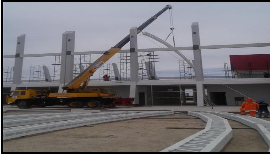
Imagen 125 Montaje de armadura de estructura metálica.
