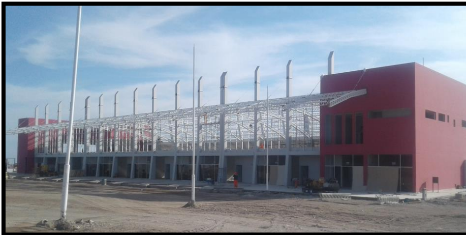
Imagen 129 Colocación de correas en cobertura.
