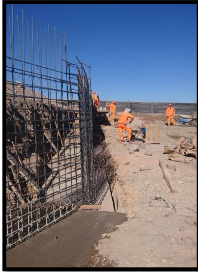
Imagen 293 Armado de acero estructural para muros de contención.
