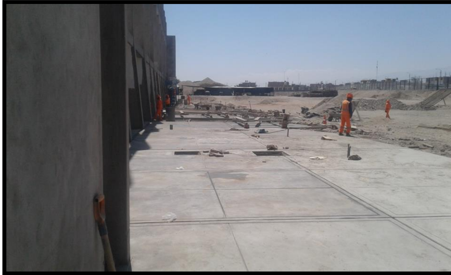
Imagen 153 Vaciado de concreto de vereda en la zona de embarque.
