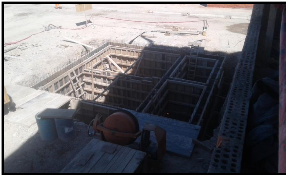
Imagen 263 Colocación de armadura de acero y brida rompe agua en la cisterna.
