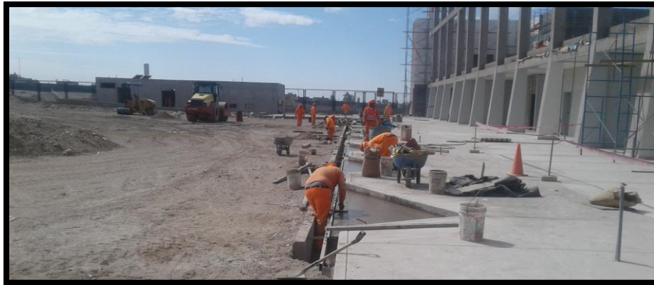
Imagen 255 Vaciado de canal de drenaje pluvial en la zona de embarque.
