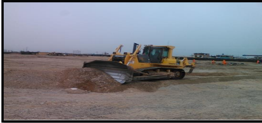
Imagen 77 Se aprecia corte de material suelto en explanación de terreno. RELLENO CON MATERIAL PROPIO DE CORTE
