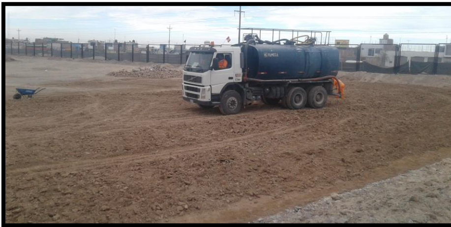
Imagen 309 Esparción de base granular y perfilado de terreno.
