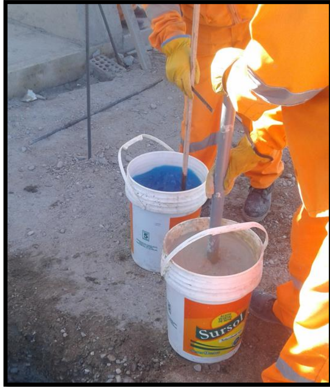
Imagen 64 Preparación de Thor Gel para el pozo a tierra. Paso 3) PRUEBA DE RESISTENCIA DEL POZO A TIERRA:
