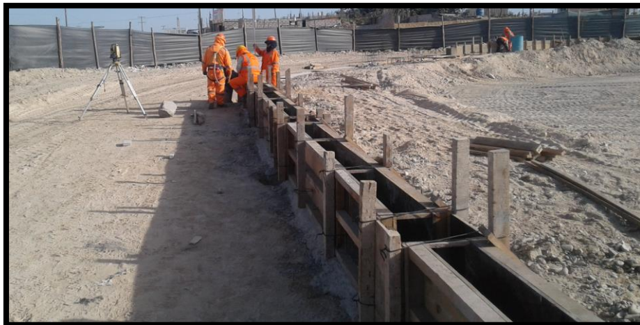
Imagen 276 vaciado de CONCRETO CIMIENTOS CORRIDOS MEZCLA 1:8 (100 kg/cm 2 )+ 30% P.M.
