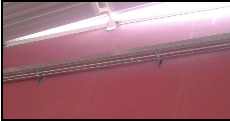
Imagen 227 Empotrado de bandeja porta cables. EQUIPOS ELECTRICOS
