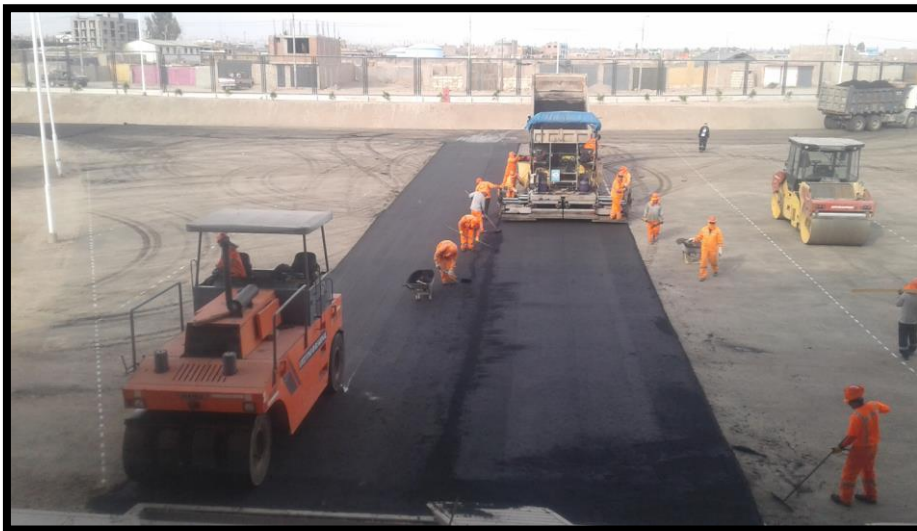
Imagen 322 Trabajos de colocación carpeta asfáltica.
