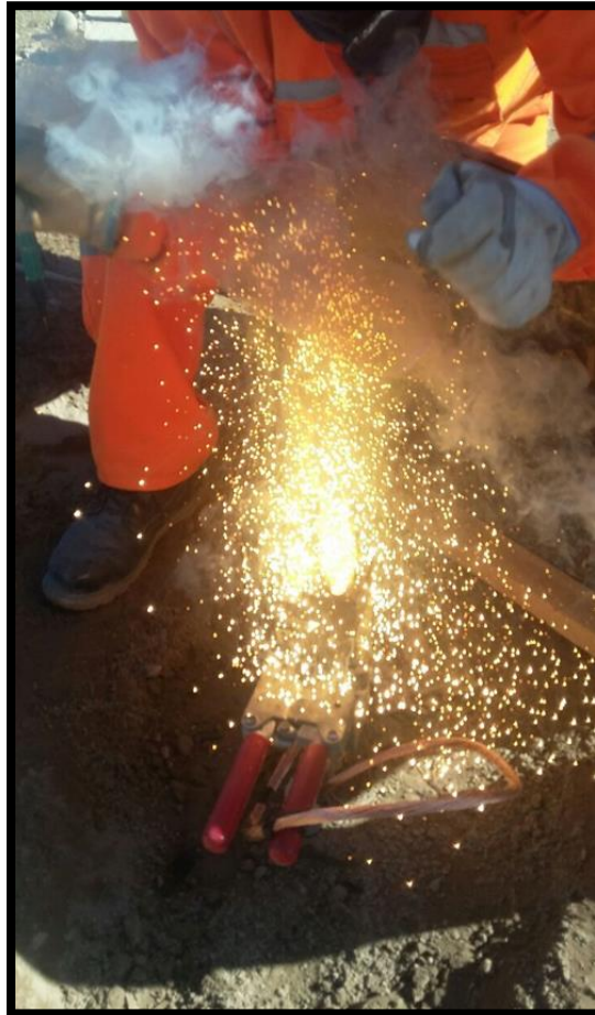
Imagen 67 Soldadura de cables a pozo a tierra
