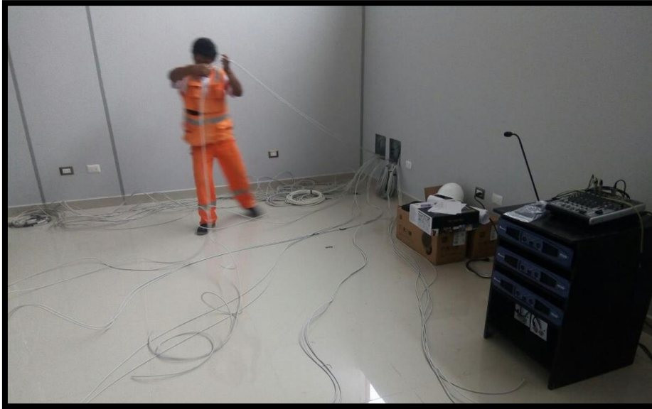
Imagen 232 Cableado de sistema voz data ha central.
