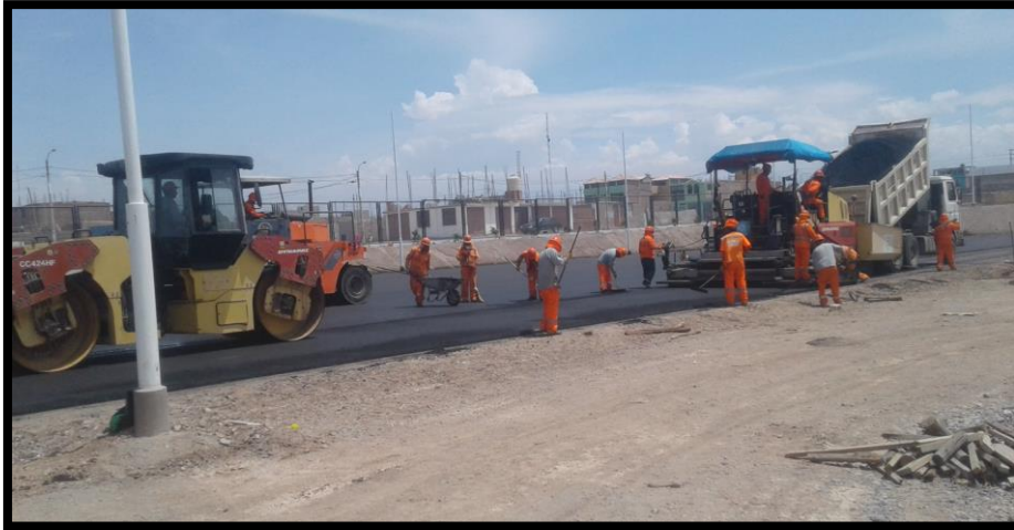
Imagen 322 Trabajos de colocación carpeta asfáltica.
