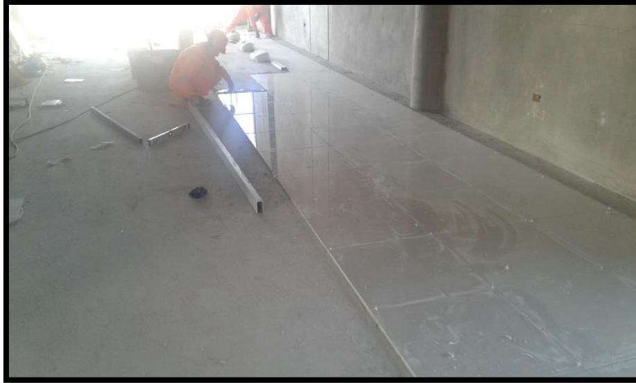
Imagen 145 Colocación de viga de porcelanato en edificaciones.
