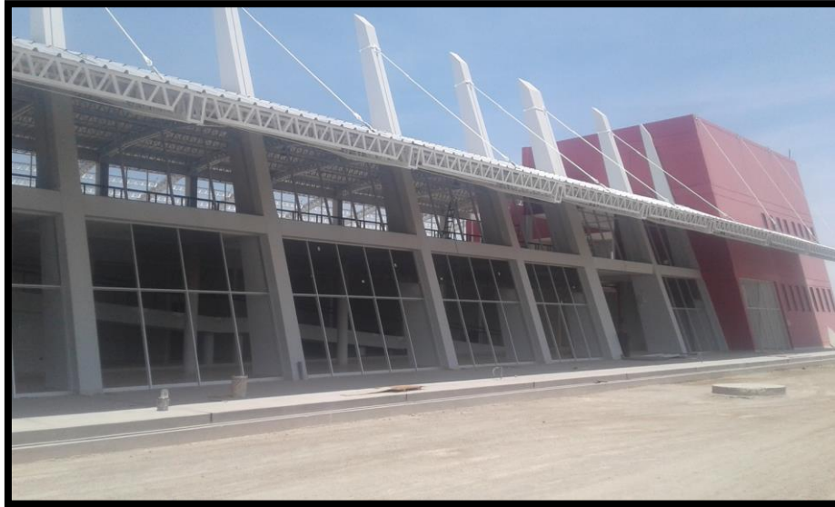
Imagen 181 Colocación de vidrio templado en el exterior de 6 mm.
