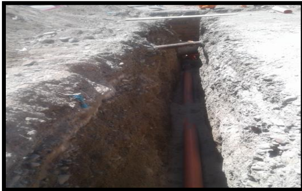
Imagen 272 Instalación de buzones de desagüe.
