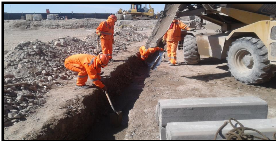
Imagen 222 Tendido de tubería hacia tablero eléctrico.
