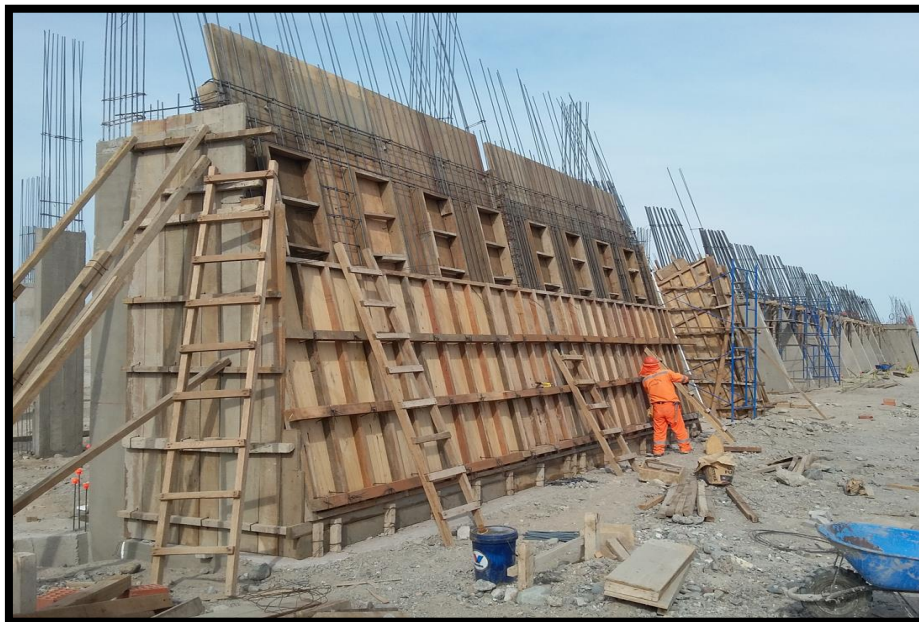
Imagen 114 Encofrado de muro de concreto armado.
