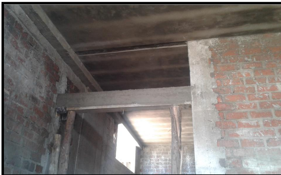
Imagen 116 Vaciado de viga dintel de concreto armado.
