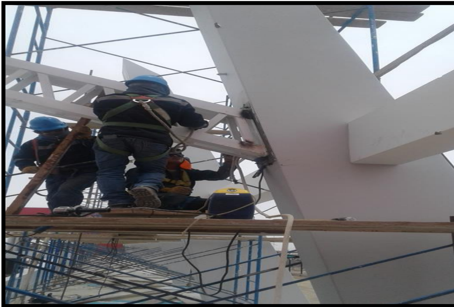
Imagen 125 Montaje de armadura de estructura metálica.
