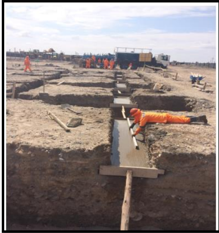
Imagen 88 Solado para vigas de cimentación.
