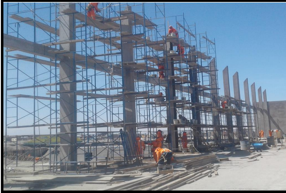
Imagen 134 Tarrajeo de columnas de segundo nivel y vigas.
