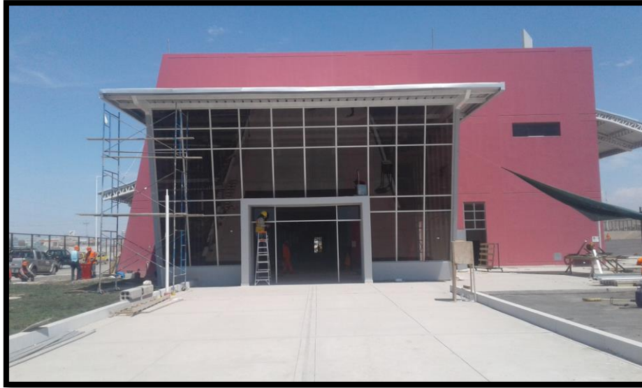
Imagen 183 Colocación de vidrio templado en el exterior de 6 mm.
