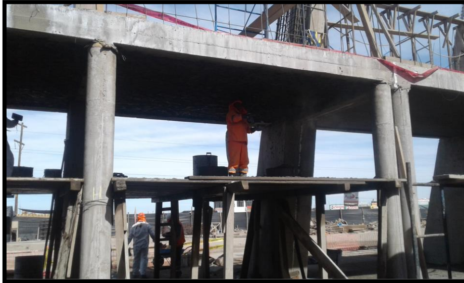
Imagen 143 Tarrajeo en cielo raso.
