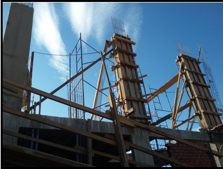
Imagen 101 Colocación de encofrado para columnas del segundo nivel.
