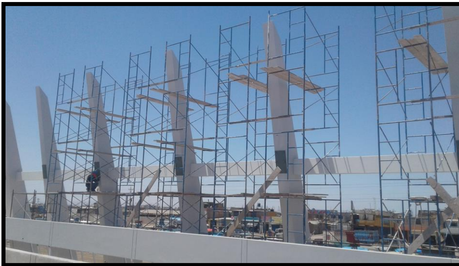
Imagen 123 Colocación de plancha 800x450x3/8" de unión de columna de concreto y armadura de acero.
