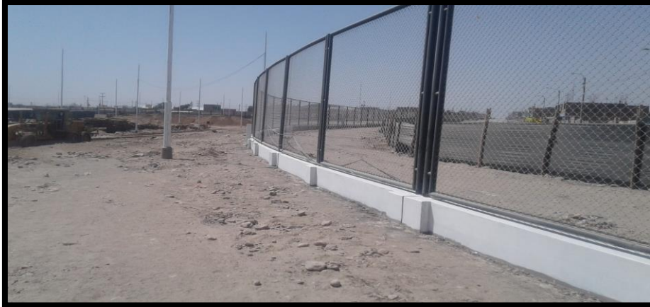
Imagen 284 Pintado de dados y solera de muro de cerco perimétrico.
