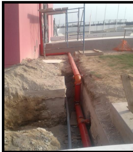
Imagen 266 Red de distribución con tubería SCH 40 2-1/2"
