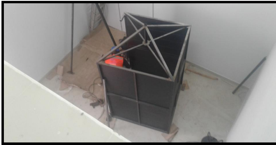
Imagen 212 Instalación de montacarga 10HP.
