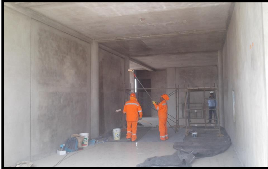
Imagen 184 Colocación de imprimante para muros para pintado.
