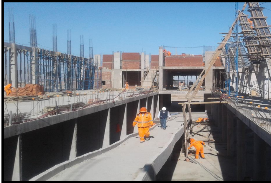
Imagen 113 Vaciado de losa de concreto para rampa. MUROS DE C°A°
