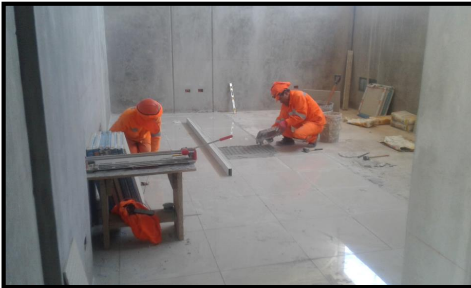
Imagen 147 Colocación de porcelanato 60x60 cm en el segundo nivel.
