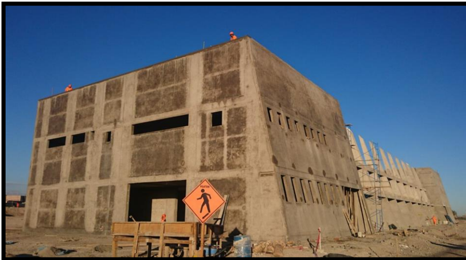
Imagen 134 Tarrajeo de columnas de segundo nivel y vigas.
