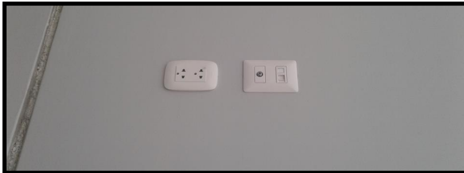
Imagen 206 Instalación de tomacorriente doble H=0.40 m.
