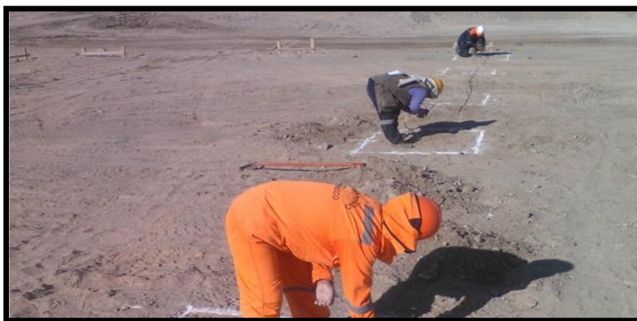
Imagen 82 Trazo inicial donde se ubican las zapatas de la edificación.
