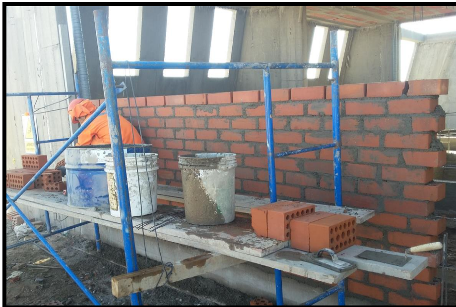
Imagen 120 Asentado de ladrillo tipo sogá en los muros no estructurales.
