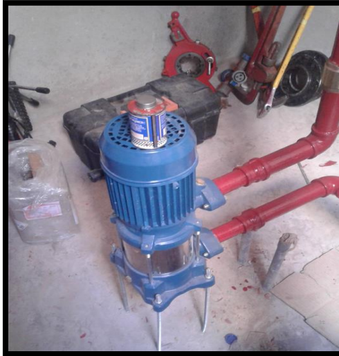
Imagen 252 Instalación de BOMBA SUMERGIBLE PARA POZO SUMIDERO DE 1 HP
