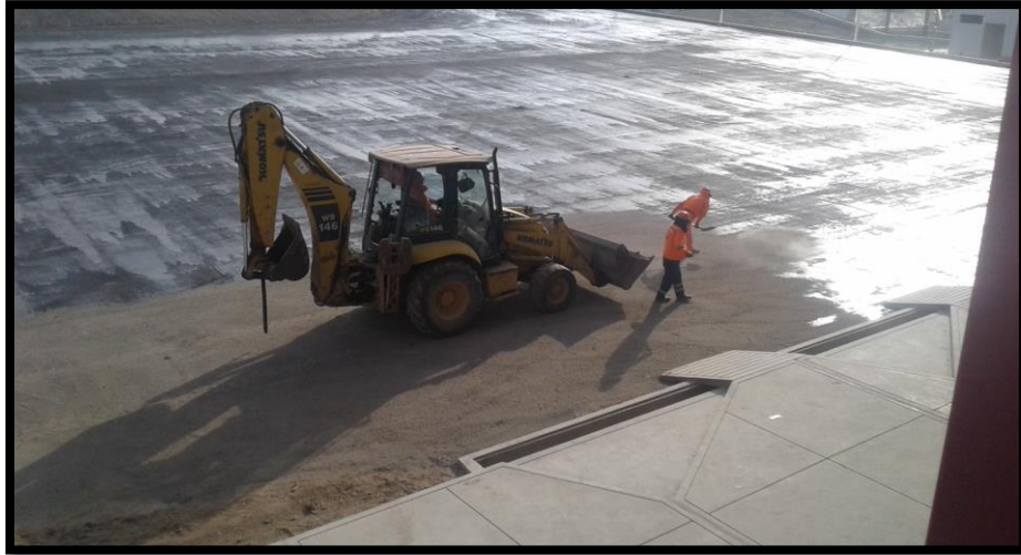
Imagen 316 Colocación de arenado en imprimante asfáltico.
