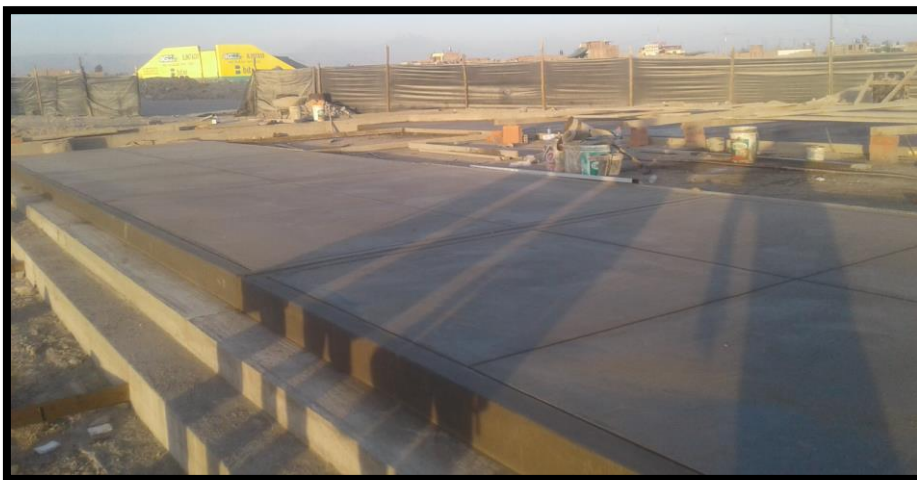
Imagen 295 PISO DE CONCRETO BRUÑADO
