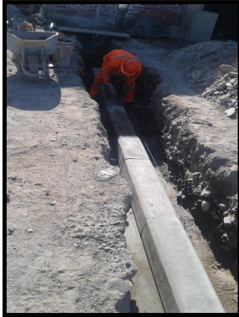
Imagen 224 Colocación de ductos de concreto 4 vías.
