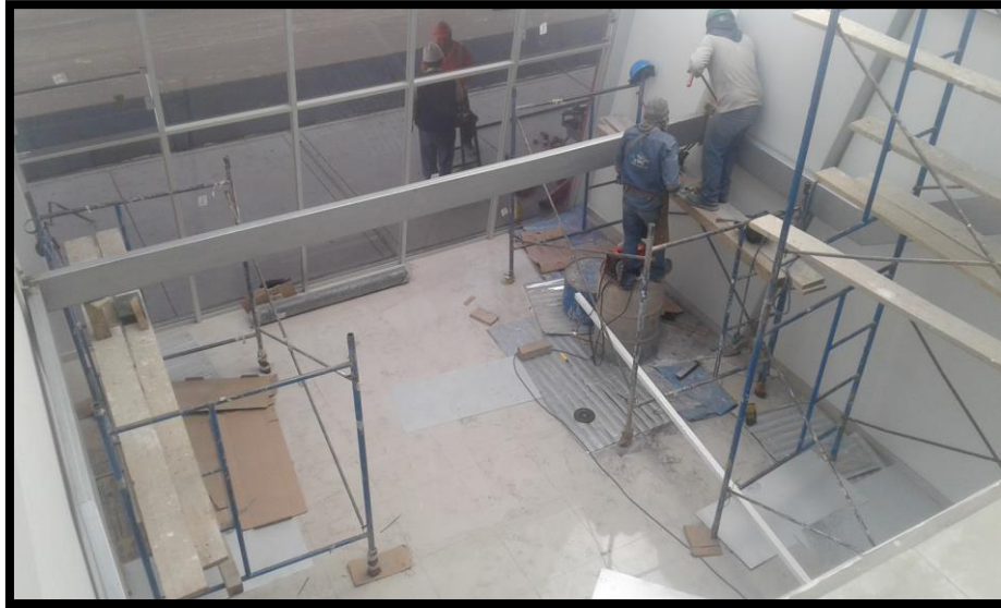
Imagen 169 Colocación de estructura metálica – vigas de 3"x10".
