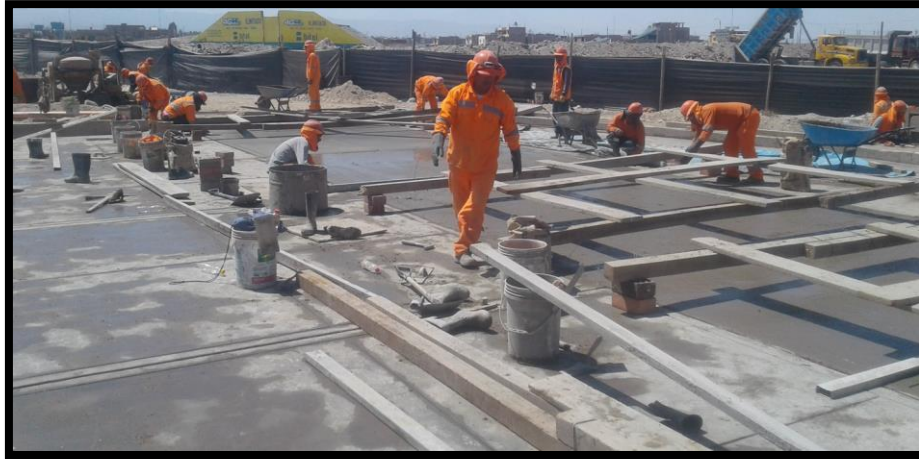
Imagen 296 Culminación de PISO DE CONCRETO BRUÑADO.
