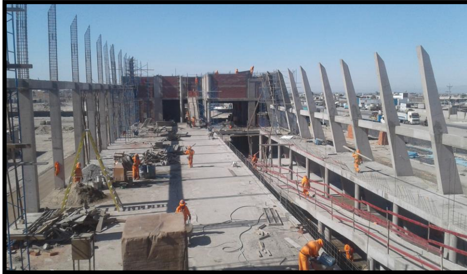
Imagen 103 Armado de columnas del tercer nivel.
