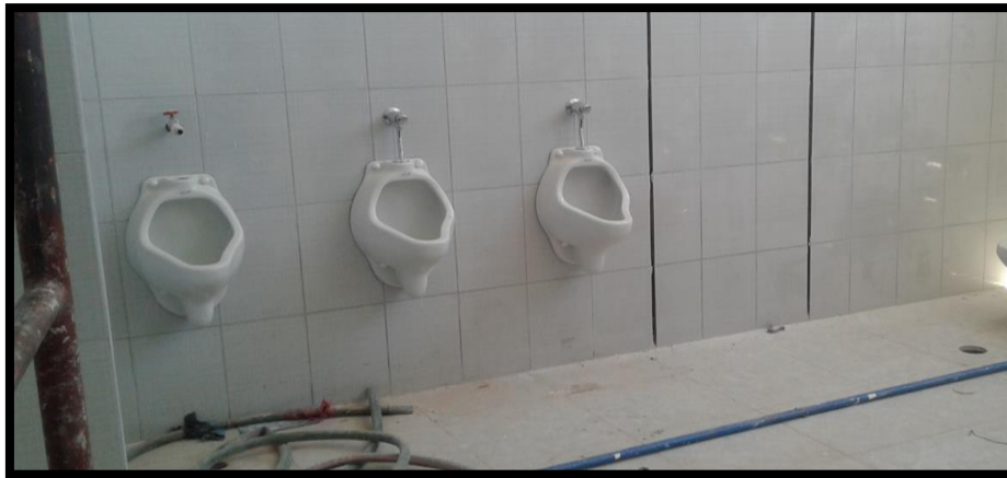
Imagen 188 Instalaciones de inodoro con fluxómetro color blanco.
