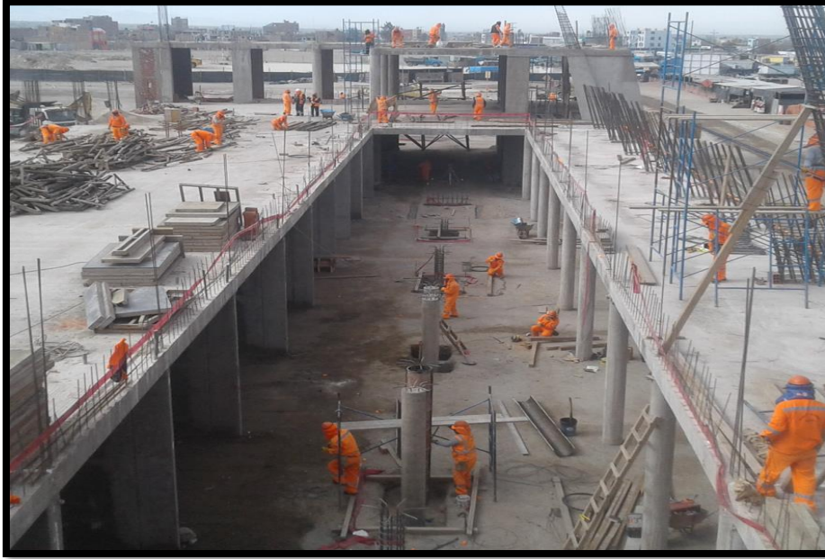
Imagen 111 Vaciado de columnas de concreto para rampa de acceso de segundo nivel.
