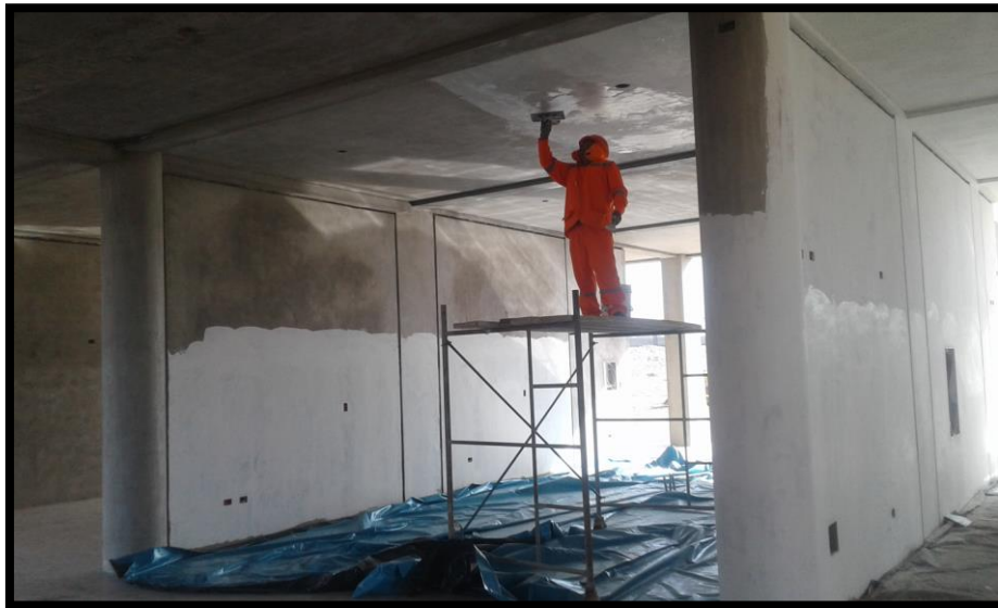
Imagen 184 Colocación de imprimante para muros para pintado.
