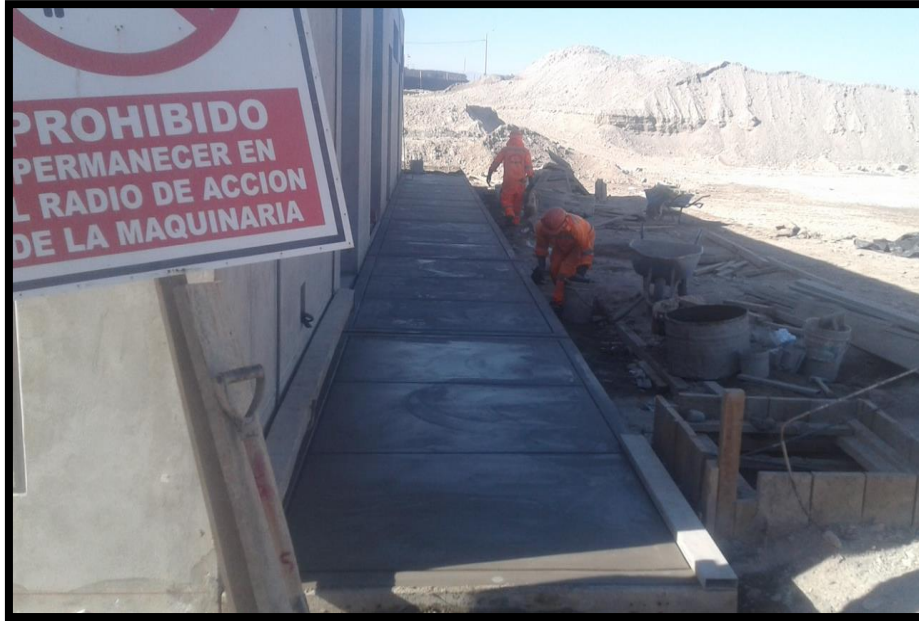
Imagen 151 Vereda de concreto, realización de tarrajeo para acabado de cemento pulido.
