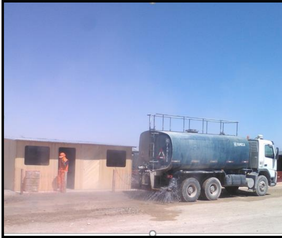
Imagen 80 Instalación de oficina de obra. SERVICIOS HIGIENICOS DE OBRA (CONTENEDORES)
