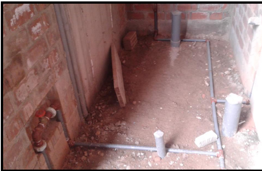
Imagen 242 Instalación de tuberías de agua fría en los SSHH.
