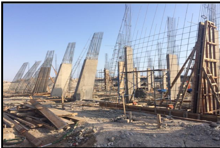
Imagen 97 Colocación de acero de zapata y columnas de concreto armado, en la edificación de terminal terrestre.
