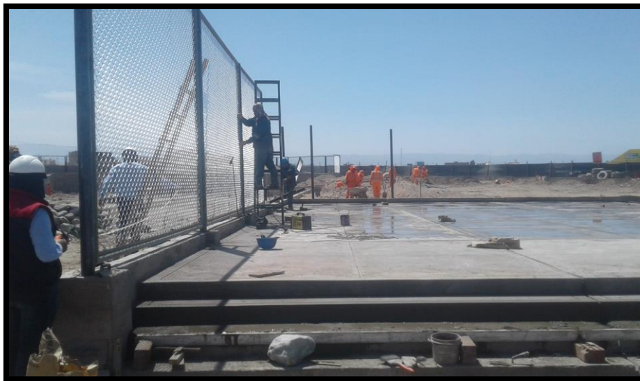
Imagen 281 Instalación de CERCO DE MALLA CUADRADA DE 2" X 2" MARCO DE TUBO CIRCULAR DE 2"
