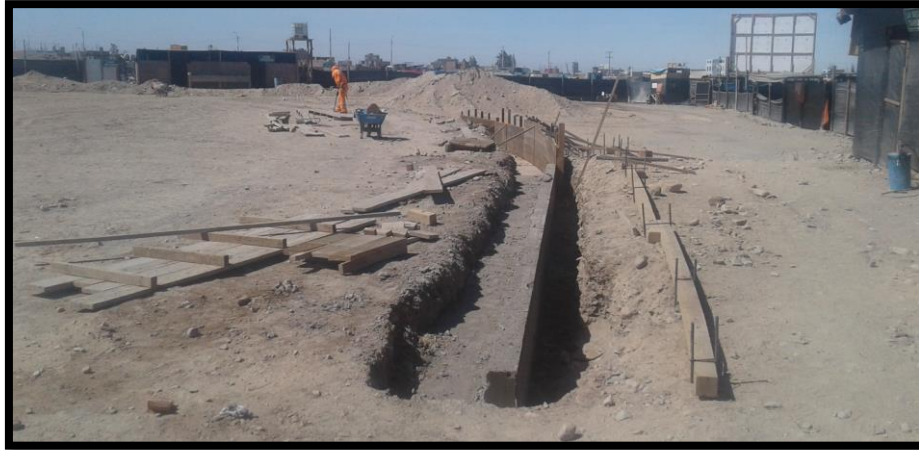
Imagen 289 Vaciado de sobrecimiento CONCRETO PARA GRADERIAS 1:8 (100KG/CM2) + 30% P.G.
