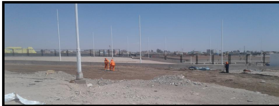
Imagen 219 Instalación de poste pastoral doble y cuádruple de 12 m
