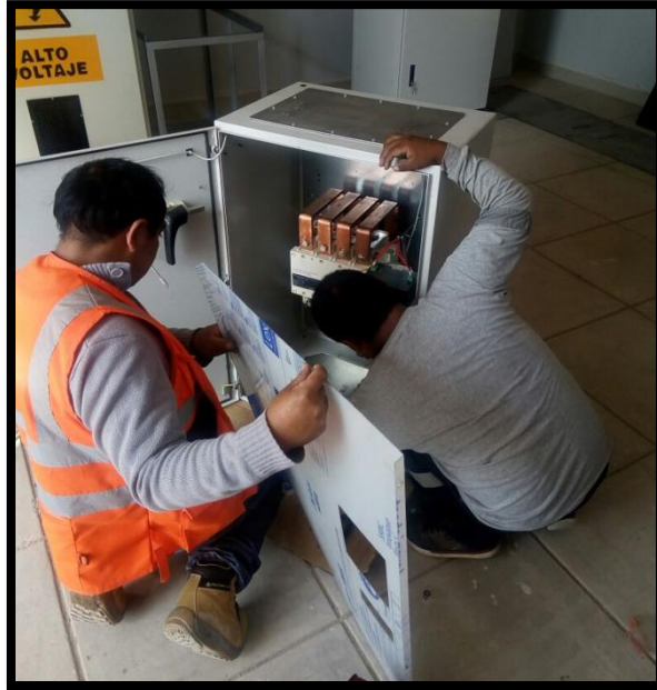
Imagen 230 Instalación de tablero de SUB ESTACION.
