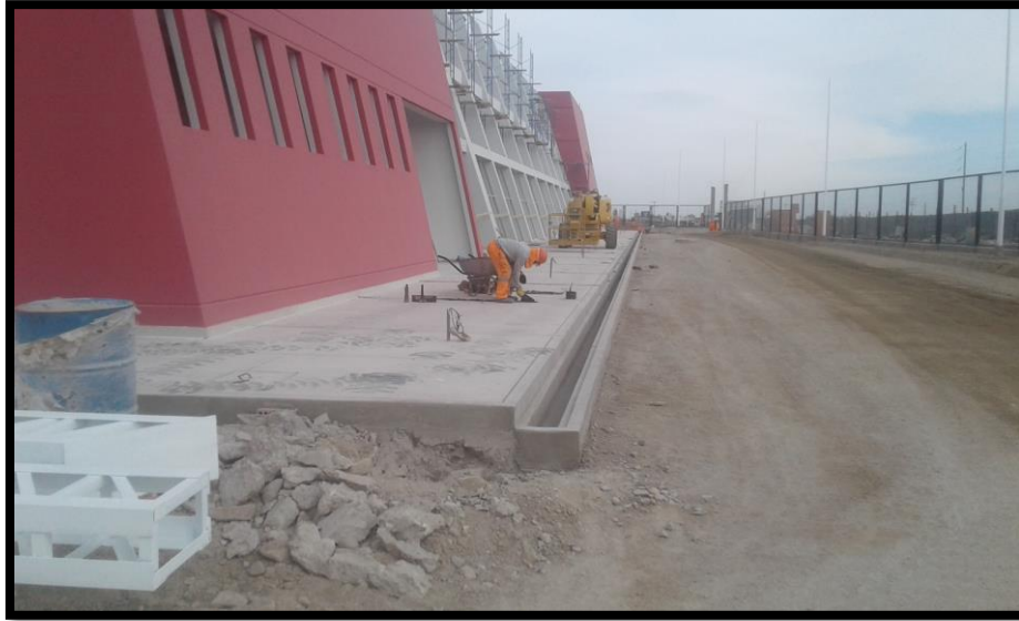
Imagen 199 Colocación de junta asfáltica de vereda. INSTALACIONES ELECTRICAS
