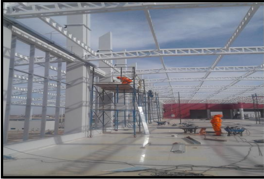
Imagen 129 Colocación de correas en cobertura.
