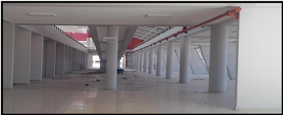
Imagen 268 Red de distribución con tubería SCH 40 2-1/2"
