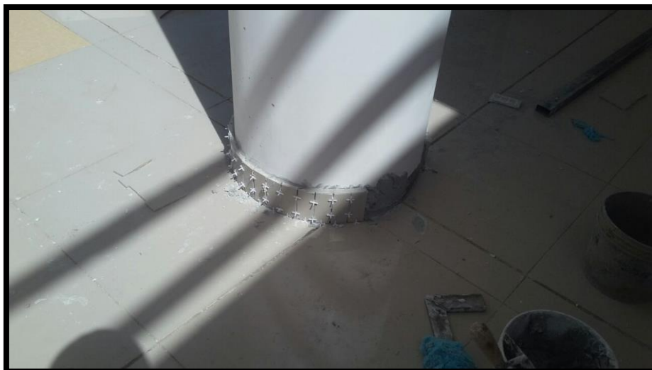
Imagen 157 Colocación de contra zócalo en columnas circulares.
