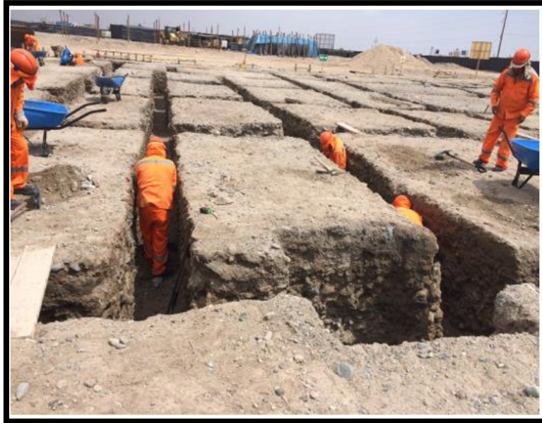
Imagen 86 Nivelación y apisonado para cimentación.
