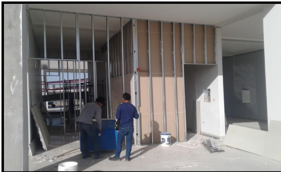
Imagen 136 Colocación de perfiles de acero para Drywall.
