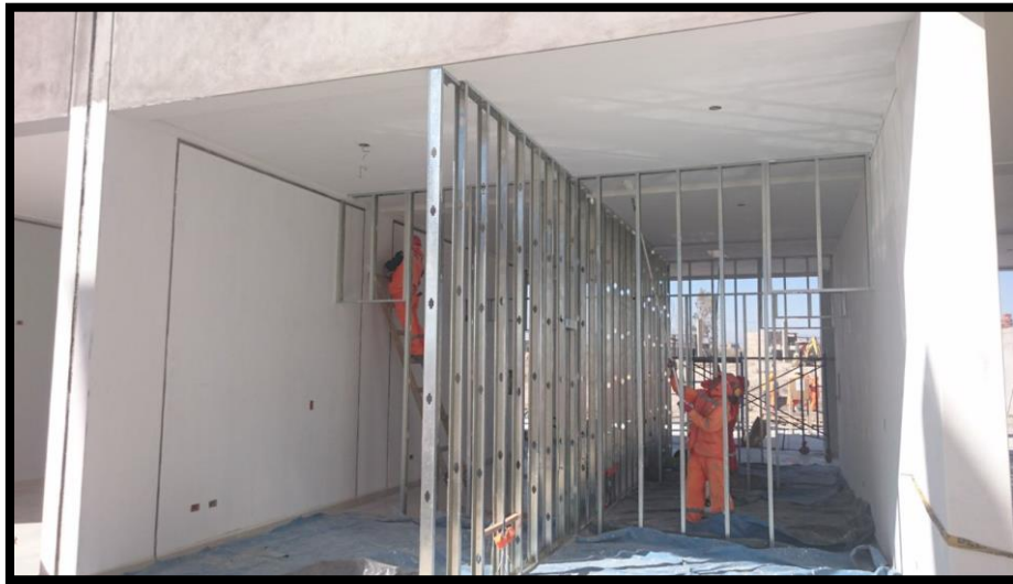
Imagen 136 Colocación de perfiles de acero para Drywall.
