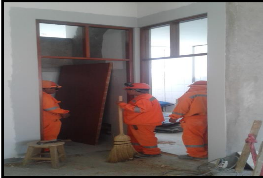
Imagen 161 Colocación de puerta contra placada de madera en el segundo nivel.
