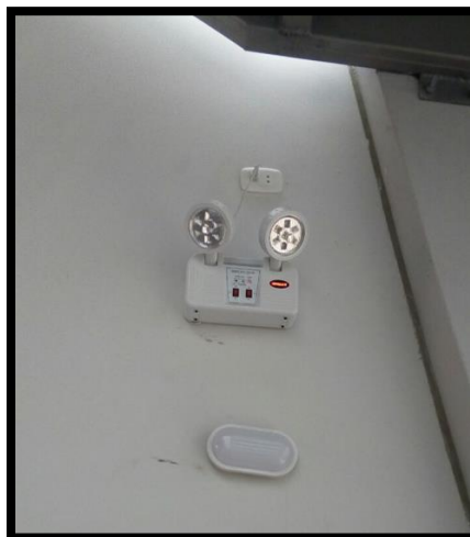
Imagen 239 Instalación de luminarias en ingreso de edificación de terminal.
