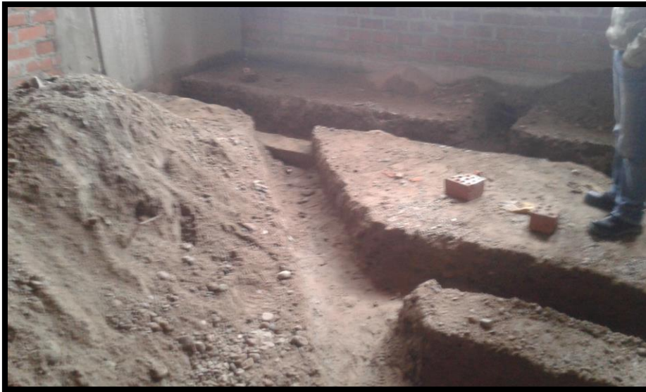
Imagen 241 Excavación para tubería sanitaria.
