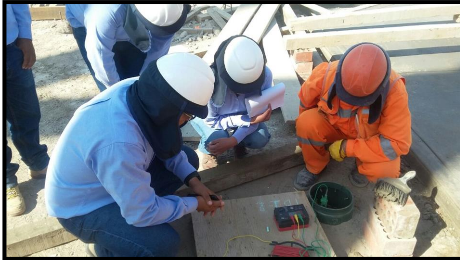
Imagen 218 Prueba de resistencia del pozo a tierra.
