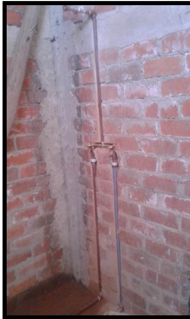
Imagen 246 Instalación de tubería para agua caliente.
