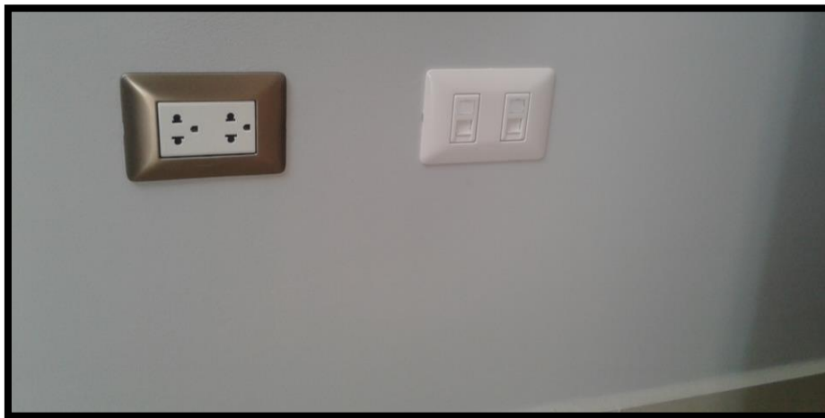
Imagen 206 Instalación de tomacorriente doble H=0.40 m.
