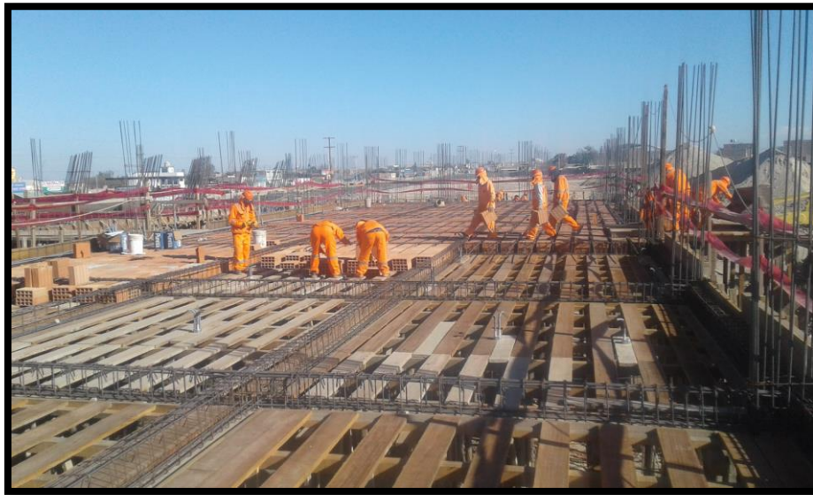
Imagen 103 Armado de columnas del tercer nivel.
