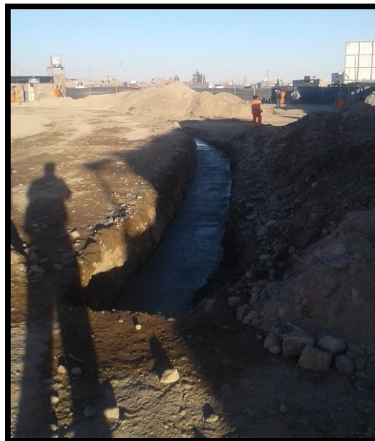
Imagen 288 vaciado de SOLADO e=2''
