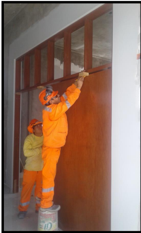
Imagen 163 Colocación de puertas contra placadas.
