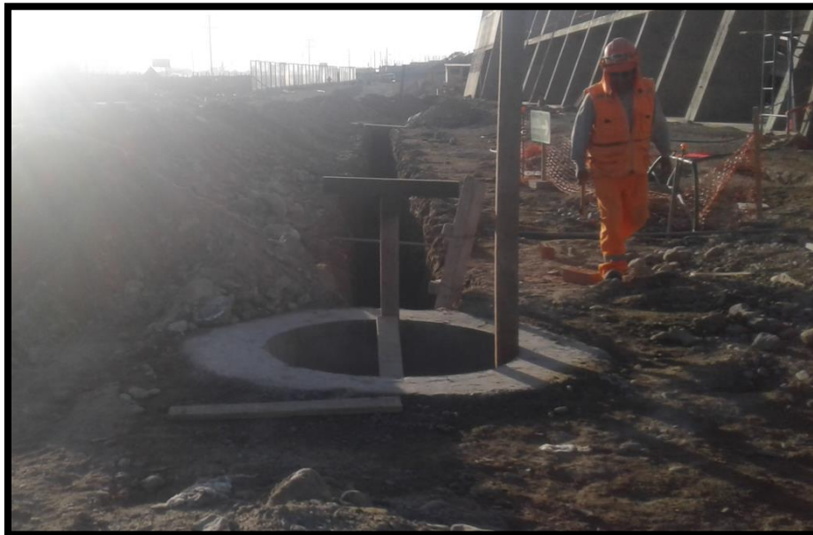
Imagen 261 Instalación de registro de concreto para desagüe.
