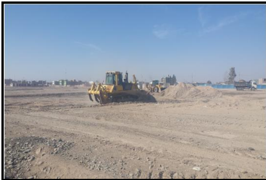
Imagen 78 Se aprecia relleno y nivelación. PERFILADO Y COMPACTACION SUB-RASANTES ZONAS CORTE
