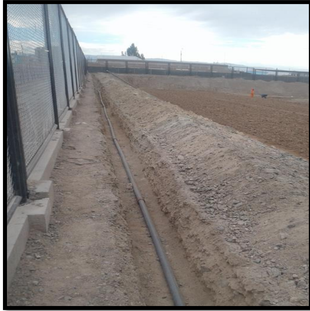
Imagen 248 Excavación de tubería de agua fría para áreas verdes.
