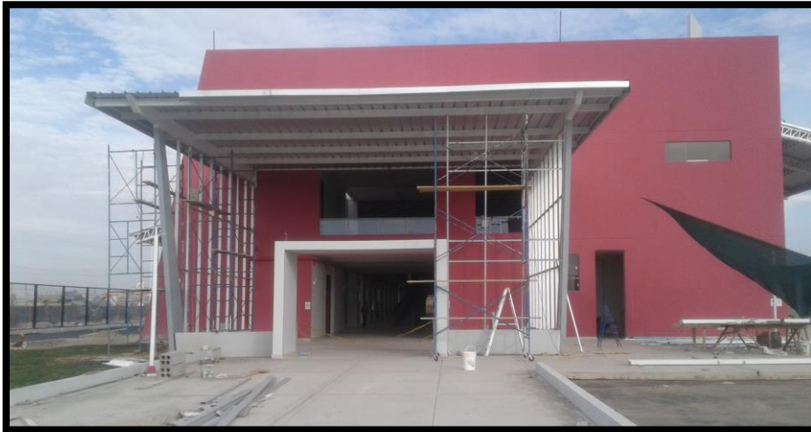
Imagen 173 Colocación de estructura de aluminio para colocación de vidrios.
