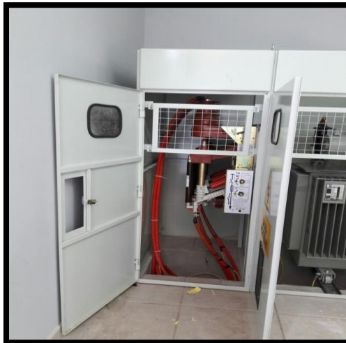
Imagen 228 Instalación de SUB ESTACION
