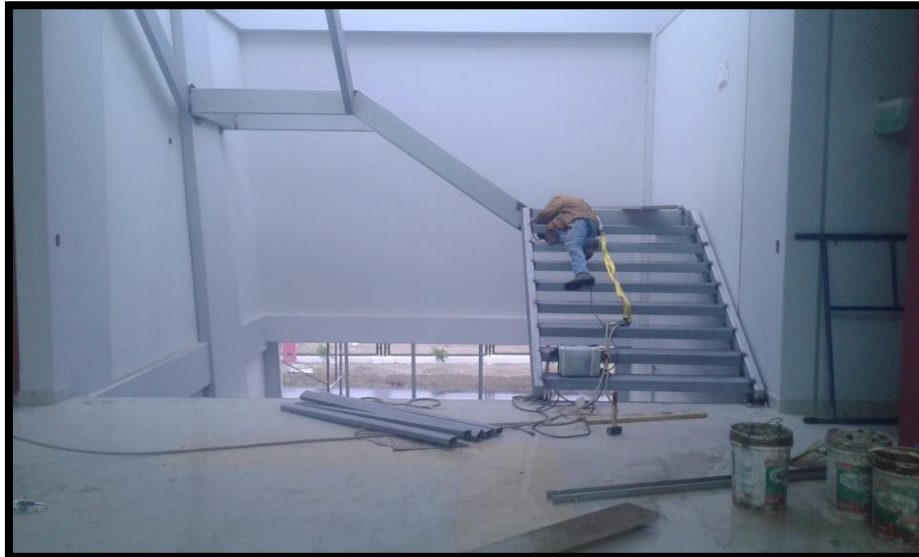
Imagen 169 Colocación de estructura metálica – vigas de 3"x10".
