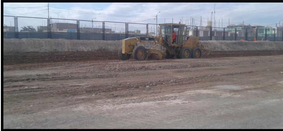
Imagen 309 Esparción de base granular y perfilado de terreno.
