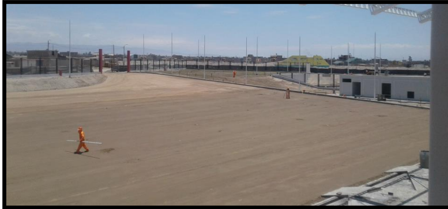
Imagen 324 Control topográfico para las alturas de carpeta asfáltica.
