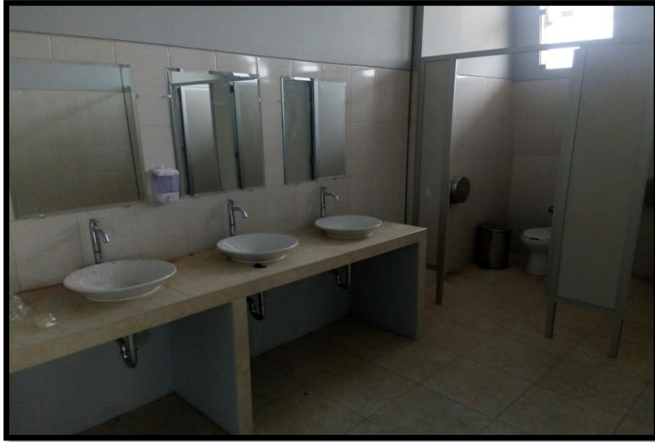
Imagen 197 Colocación de divisiones metálicas de baños.
