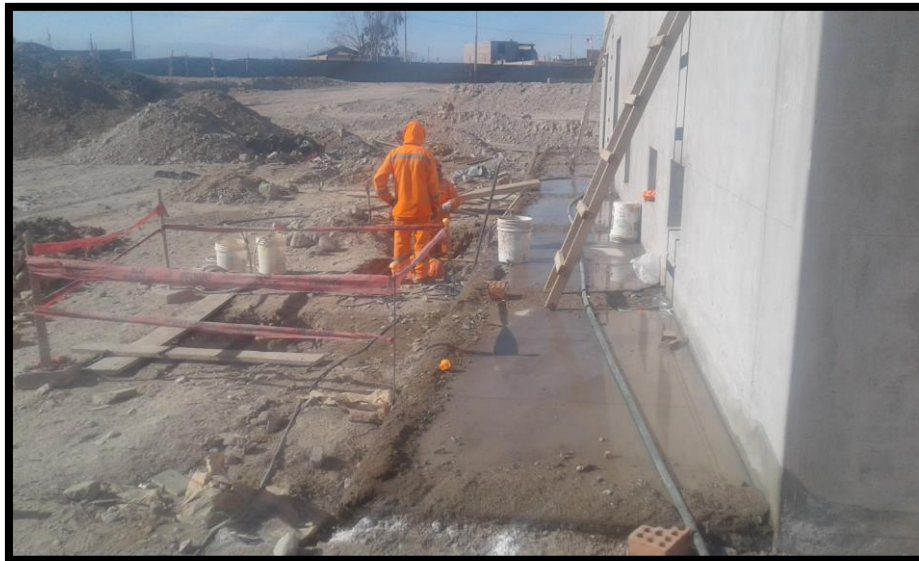
Imagen 150 Curado de vereda del cuarto de máquinas.
