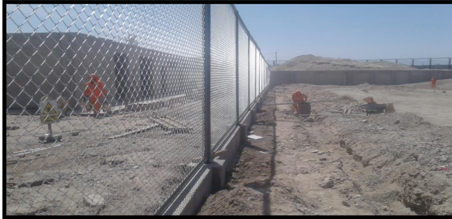
Imagen 281 Instalación de CERCO DE MALLA CUADRADA DE 2" X 2" MARCO DE TUBO CIRCULAR DE 2"
