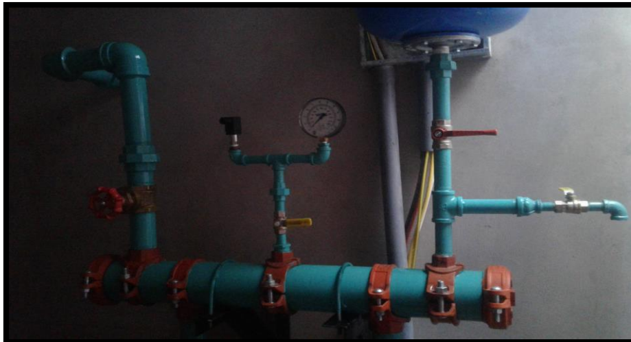
Imagen 252 Instalación de BOMBA SUMERGIBLE PARA POZO SUMIDERO DE 1 HP
