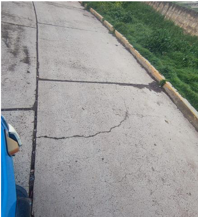
Fotografía 16. Estado y condición del pavimento de estudio.
