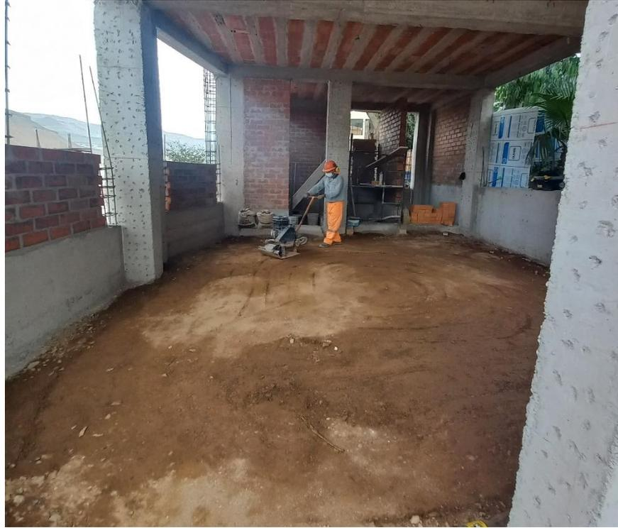
*Figura 70. Vista fotográfica de relleno compactado con material de préstamo en el bloque 05.*
