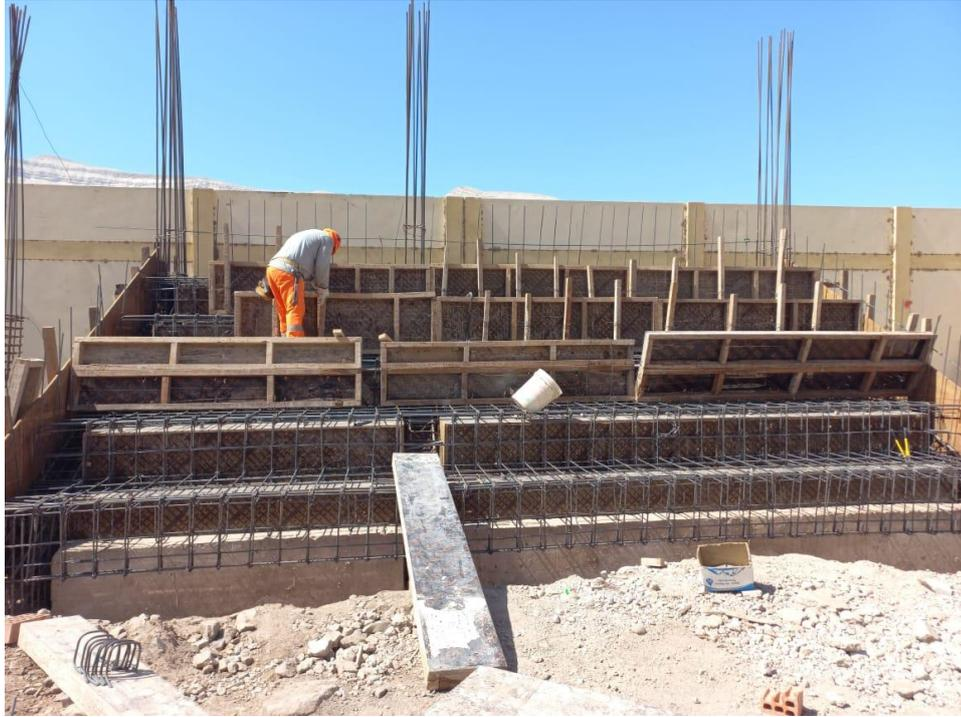
*Figura 87. Vista fotográfica de habilitado de acero y encofrado en graderías 01 tramo III – bloque 06.*
