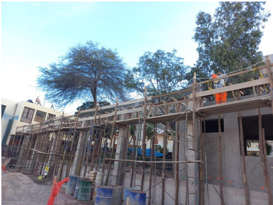
*Figura 90. Vista fotográfica de habilitado de acero y encofrado en viga principal de cobertura autoportante de gradería 02 tramo I al II – bloque 06.*
