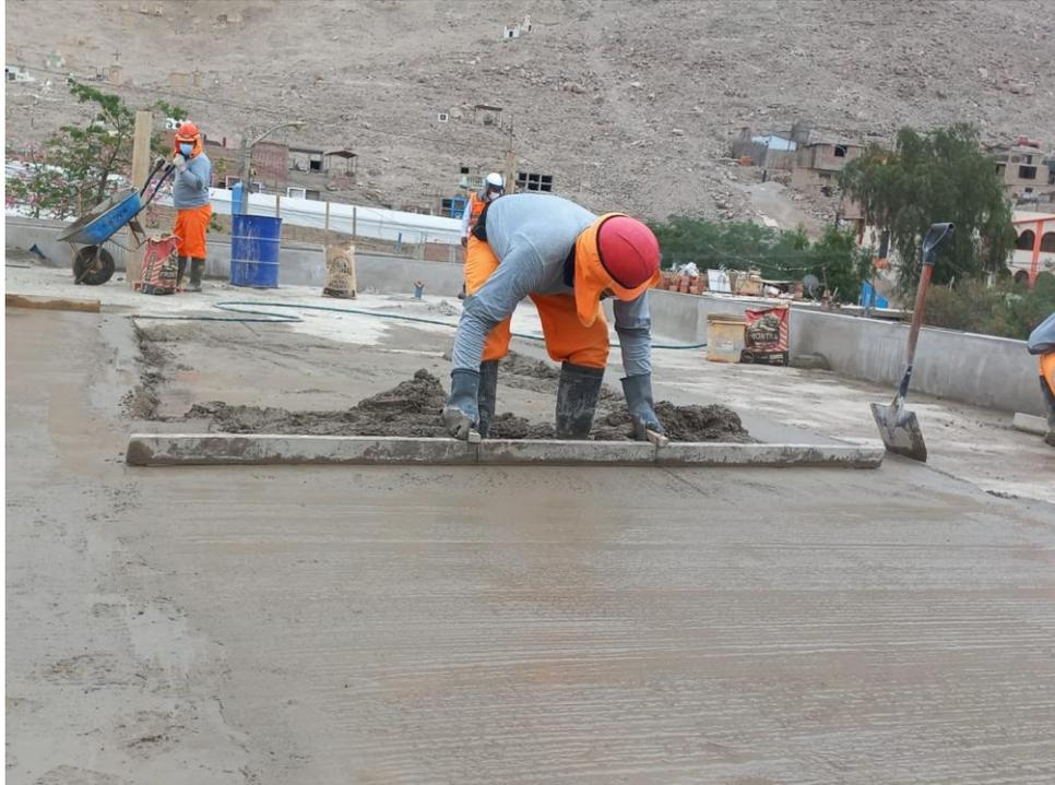
*Figura 55. Vista fotográfica de vaciado de entre piso en la azotea en el bloque 04.*
