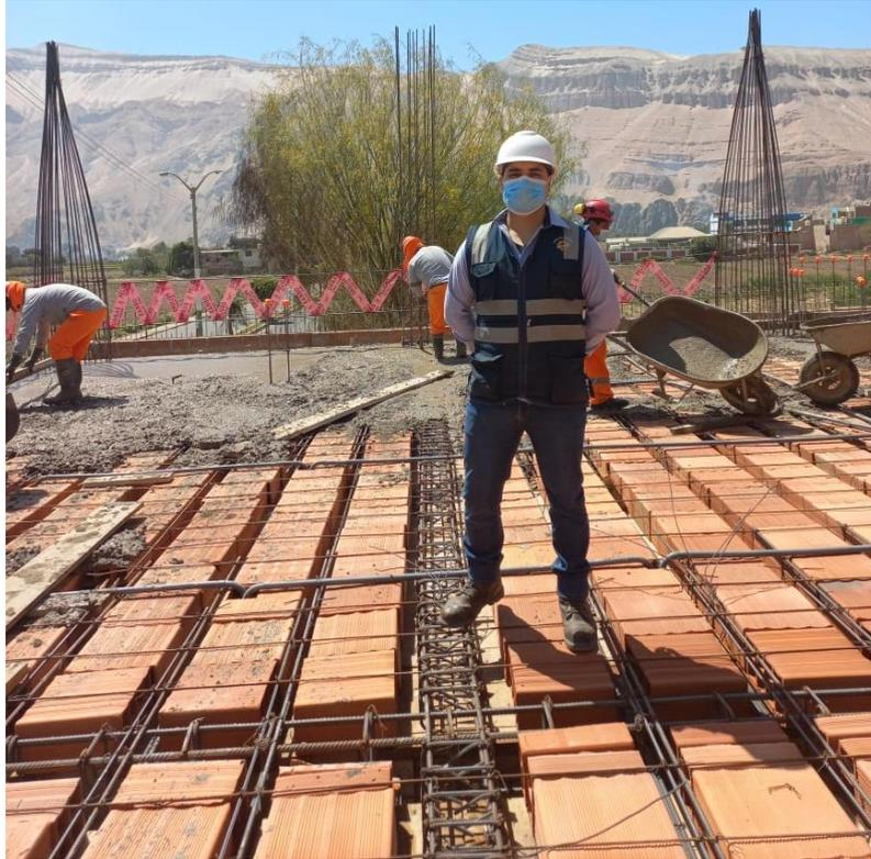
*Figura 42. Vista fotográfica de vaciado de concreto  $f'c$  0 210 kg/cm<sup>2</sup> en losa, vigas y viguetas en 2do nivel en bloque 01.*
