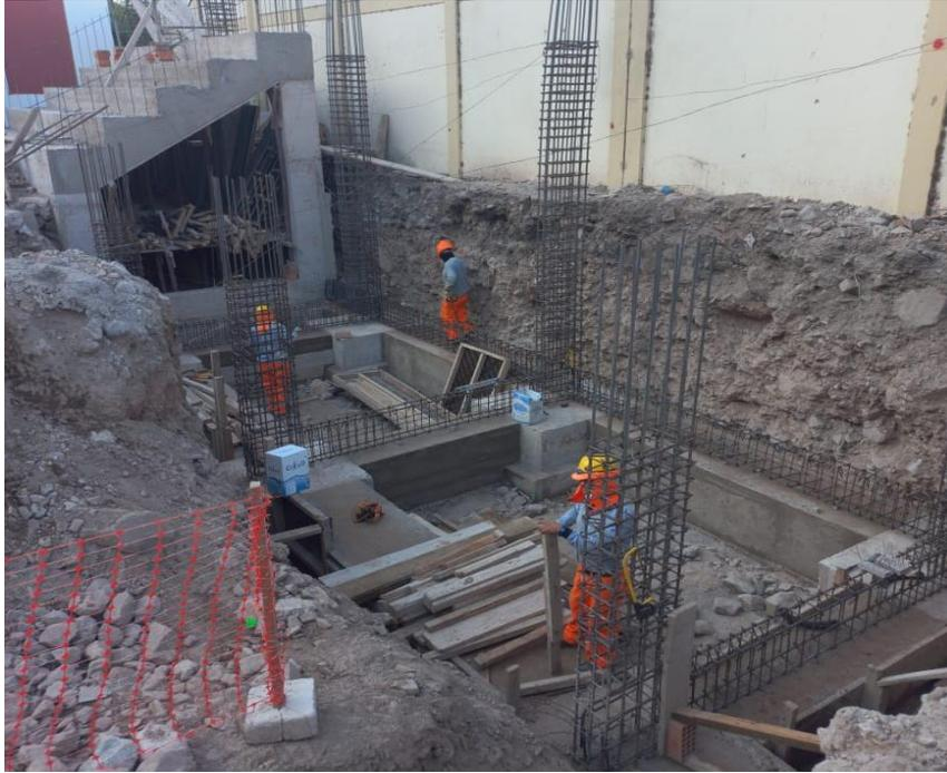
*Figura 85. Vista fotográfica de habilitado de acero de vigas de cimentación en gradería 01 tramoII – bloque 06.*
