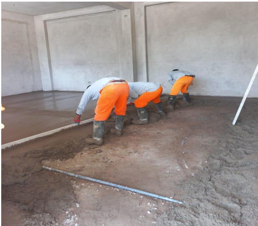
*Figura 54. Vista fotográfica de vaciado de falso piso en el bloque 04.*
