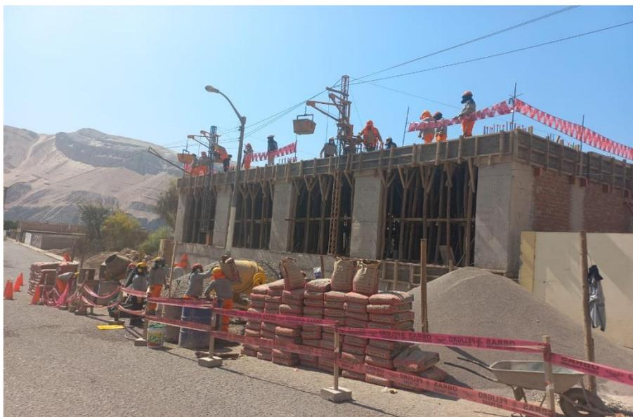
*Figura 43. Vista fotográfica de vaciado de concreto  $f'c$  0 210 kg/cm<sup>2</sup> en losa, vigas y viguetas en 2do nivel en bloque 01.*
