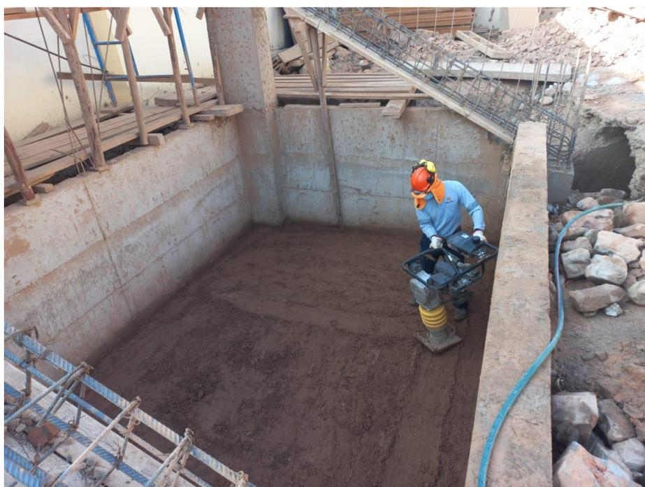
*Figura 92. Vista fotográfica de relleno compactado con material de préstamo de gradería 01 tramo II – bloque 06.*
