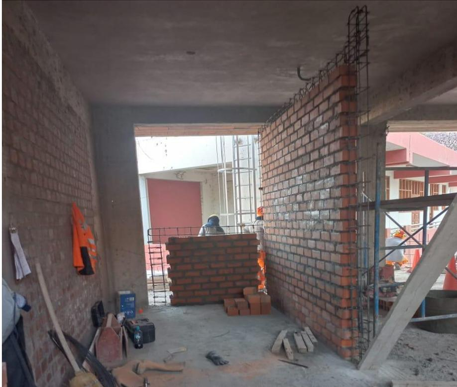
*Figura 44. Vista fotográfica de asentado de ladrillo en muros de tabiquería en bloque 01.*
