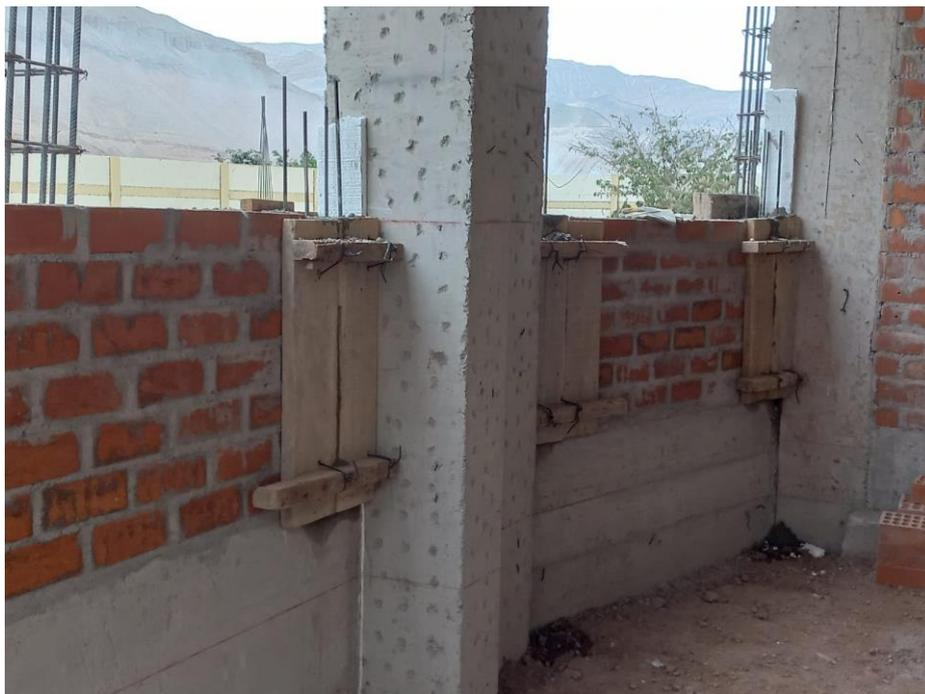
*Figura 71. vista fotográfica de encofrado y vaciado de concreto en columnetas en el bloque 05.*
