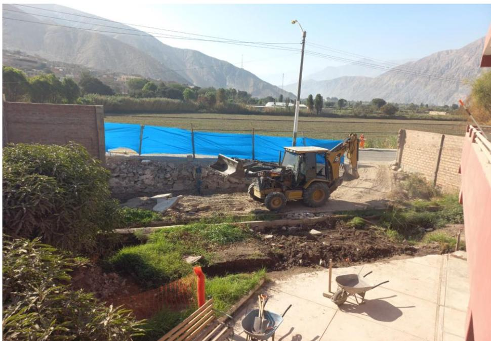
*Figura 31. Vista fotográfica de movimiento de tierras y excavación para canal de regadío provisional en bloque 01.*
