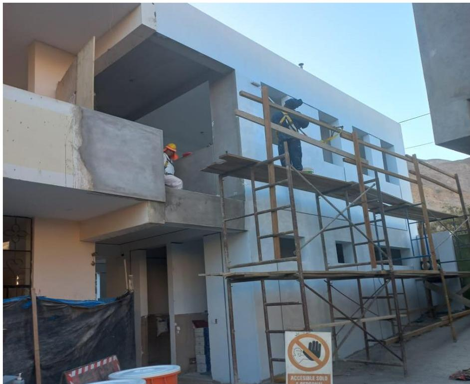
*Figura 66. Vista fotográfica de primera mano exterior con imprimante en el bloque 04.*
