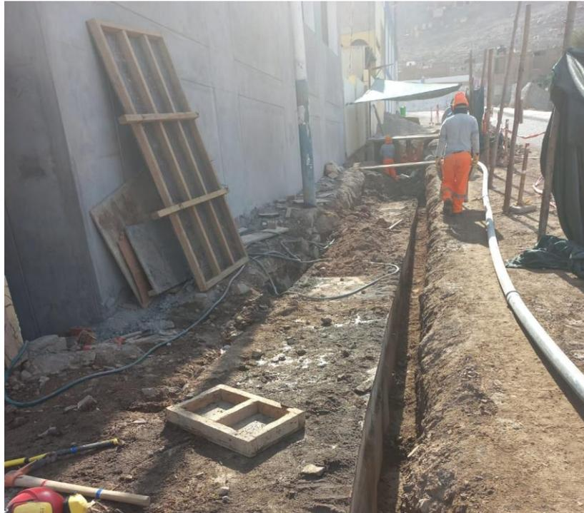
*Figura 111. Vista fotográfica de vaciado de concreto  $f'c$  210 kg/cm<sup>2</sup> en canal de regadío de concreto cerrado en obras exteriores.*
