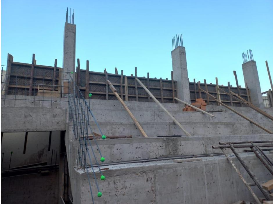
*Figura 97. Vista fotográfica de encofrado y vaciado de concreto en parapetos de gradería 01 tramo II – bloque 06.*
