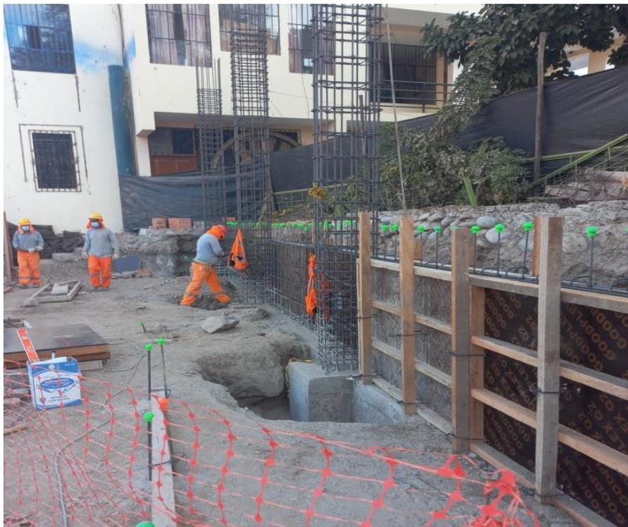
*Figura 86. Vista fotográfica de habilitado de acero y encofrado en muros de contención en gradería 02 tramo III – bloque 06.*
