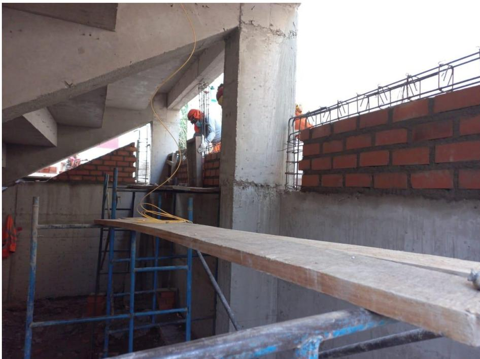
*Figura 94. Vista fotográfica de asentado de ladrillo, encofrado y vaciado de concreto en columnetas de gradería 01 tramo III – bloque 06.*
