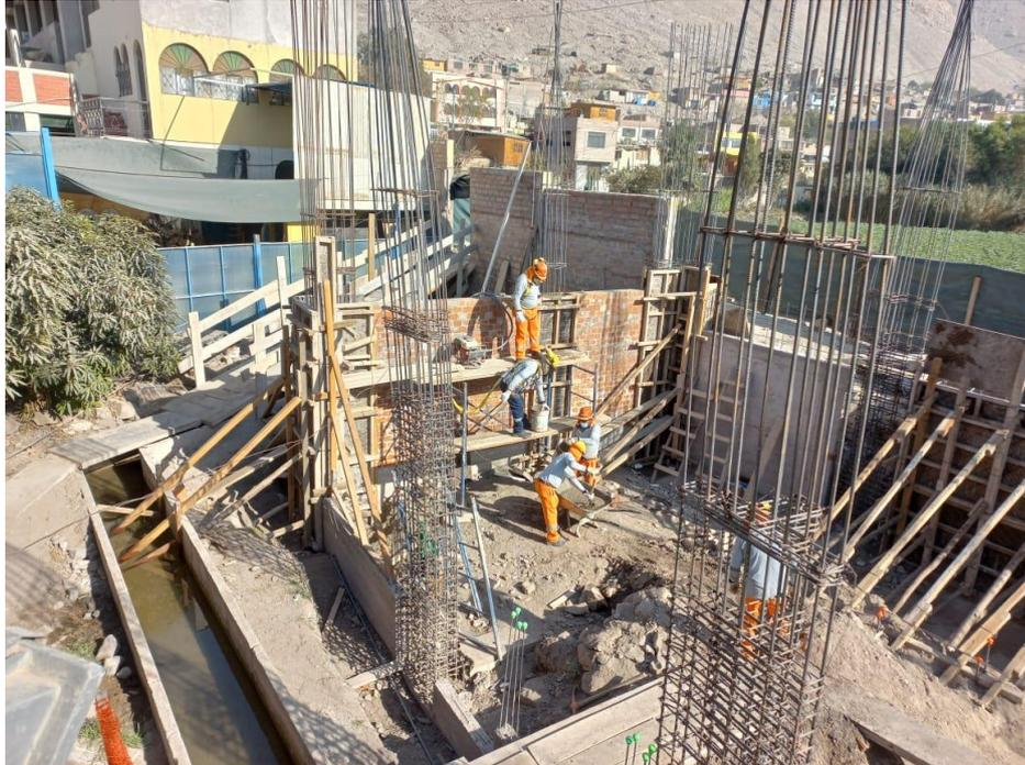
*Figura 36. Vista fotográfica de asentado de muros portantes, encofrado y vaciado de concreto  $F'c=210 \text{ kg/cm}^2$  en bloque 01.*
