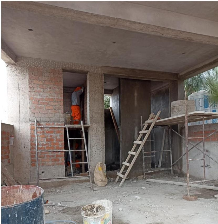
*Figura 73. vista fotográfica de tarrajeo de muros y vigas en el bloque 05.*
