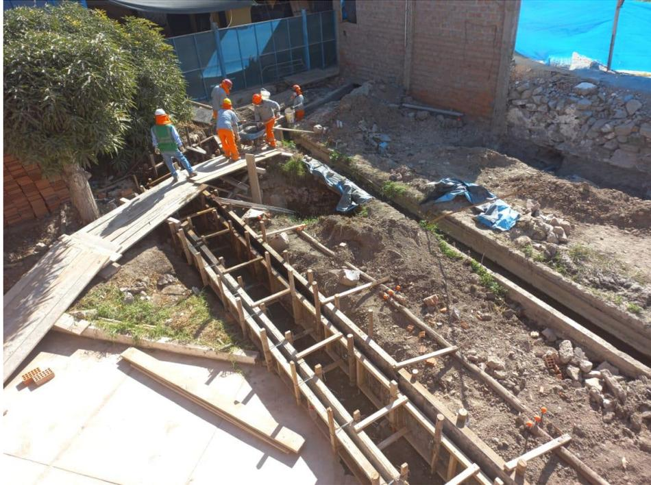
*Figura 32. Vista fotográfica de encofrado y vaciado de concreto para canal de regadío provisional en bloque 01.*
