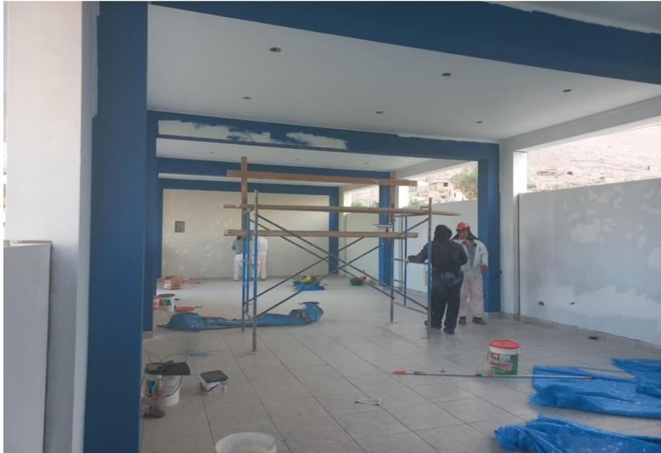
*Figura 51. Vista fotográfica de pintura a 02 manos interior del 2do nivel del bloque 01.*
