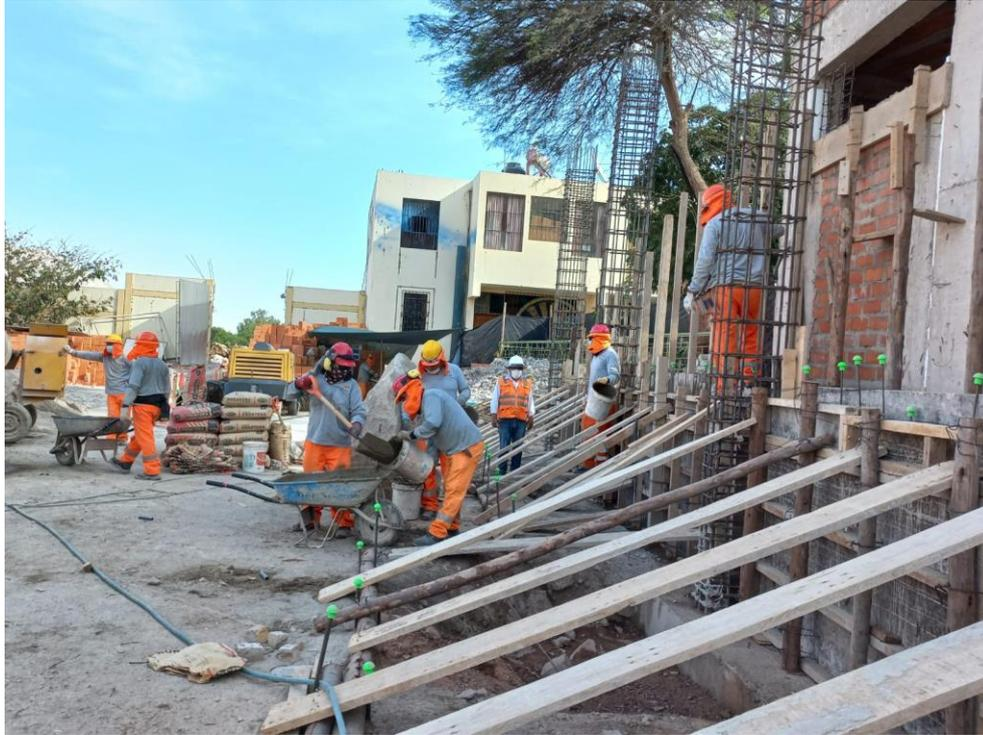
*Figura 81. Vista fotográfica de vaciado de concreto en muro de contención de gradería 02 en el bloque 06.*
