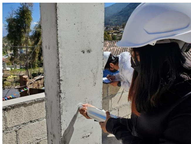
Figura 28. Prueba esclerometrica en columna 2 - Vivienda N°01
