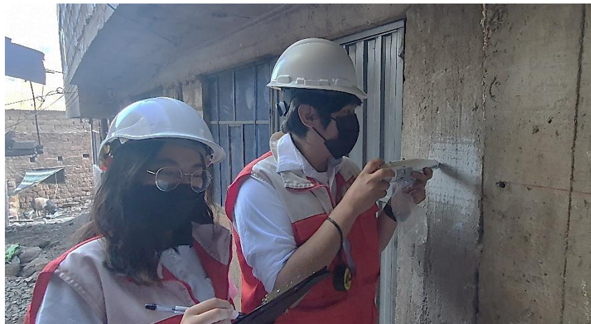
Figura 33. Prueba esclerometrica en columna 1 - Vivienda N°04
