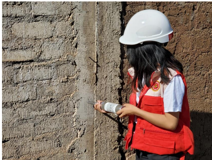
Figura 30. Prueba esclerométrica en columna 1 - Vivienda N°02
