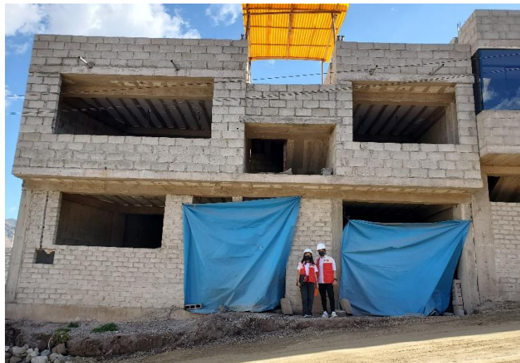
Figura 22. Vivienda N°05 – distrito de Tamburco
