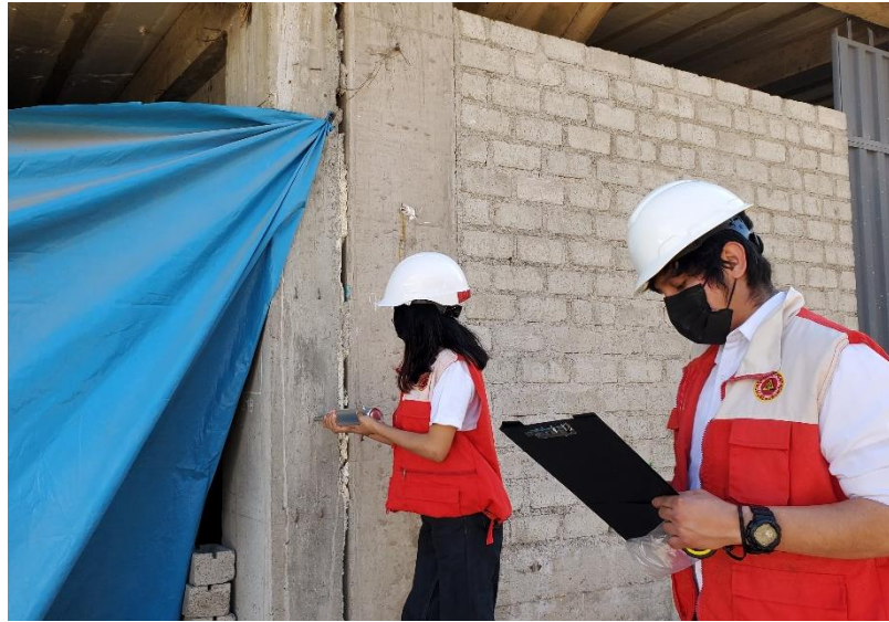
Figura 35. Prueba esclerometrica en columna 1 - Vivienda N°05
