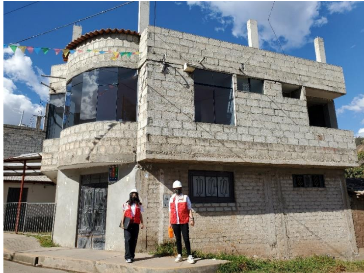
Figura 18. Vivienda N°01 – distrito de Tamburco
