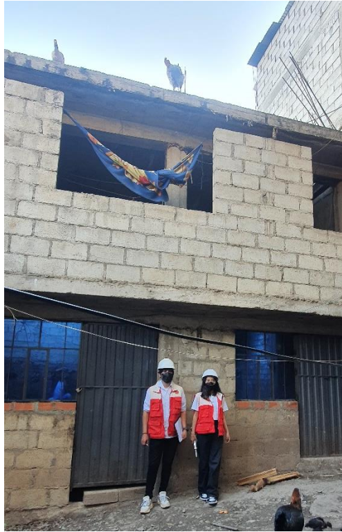
Figura 21. Vivienda N°04 – distrito de Tamburco
