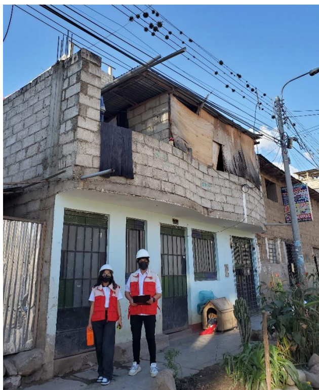
Figura 20. Vivienda N°03 – distrito de Tamburco
