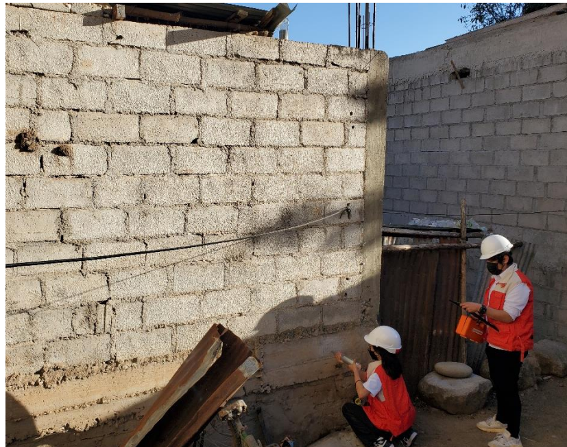
Figura 31. Prueba esclerometrica en viga 1 - Vivienda N°03
