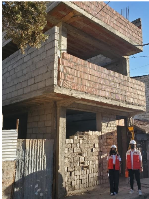
Figura 19. Vivienda N°02 – distrito de Tamburco
