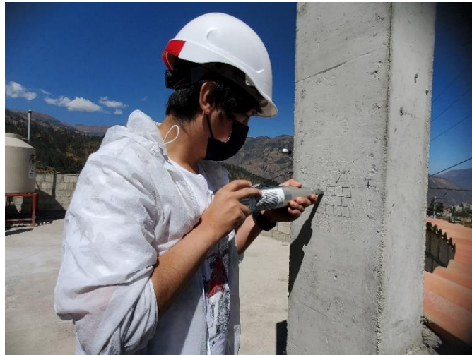
Figura 27. Prueba esclerometrica en columna 1 - Vivienda N°01
