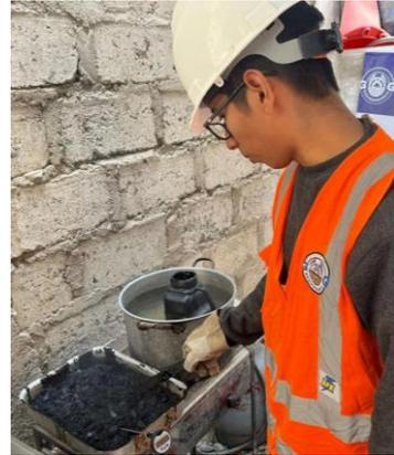
**Figura 59:** Mezcla de agregados + C. Asfáltico.
