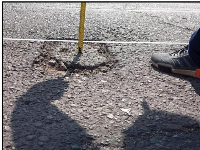
**Figura 44:** Falla por hundimiento.
