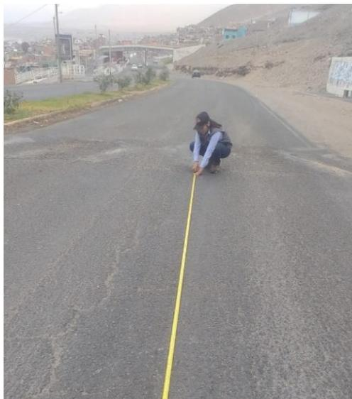
**Figura 14:** Medición de fallas con el Flexómetro
