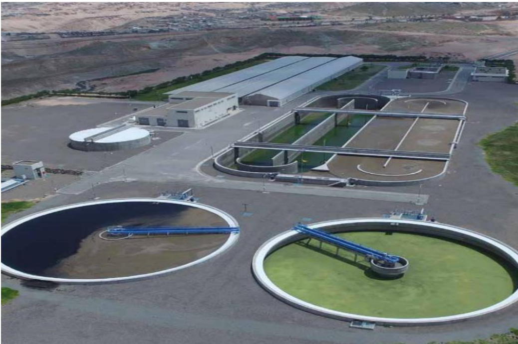
Figura 6. Primera Planta de tratamiento de aguas residuales - La Escalerilla.
