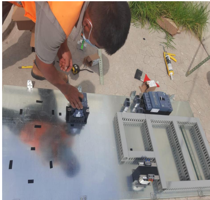
Figura 74. Instalación de equipos electrónicos en el gabinete de comunicación
