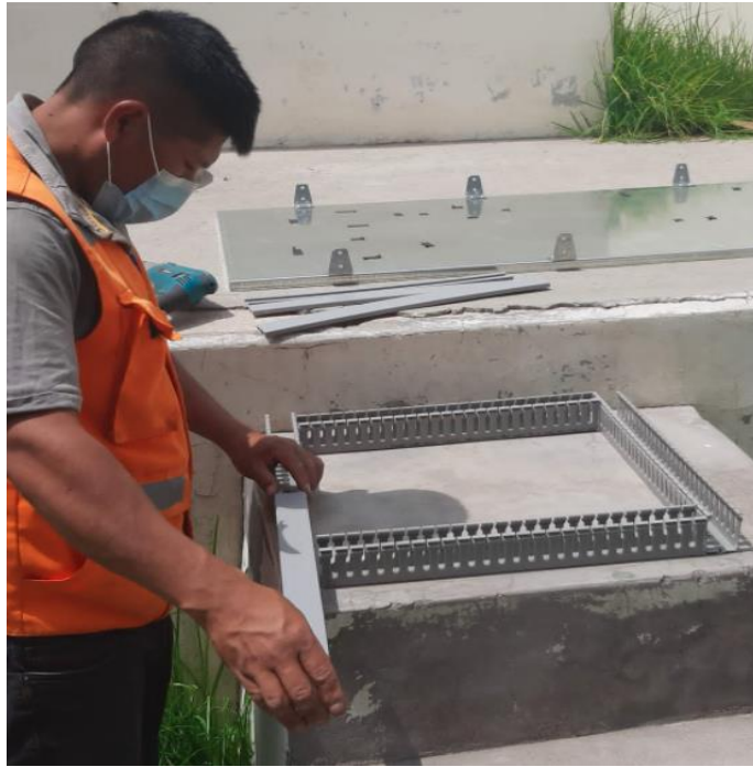
Figura 73. Instalación de rieles en el gabinete de comunicación.
