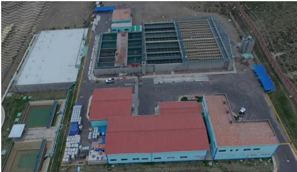
Figura 4. Segunda Planta de tratamiento de agua potable - Miguel de la Cuba Fuente: Elaboración propia
