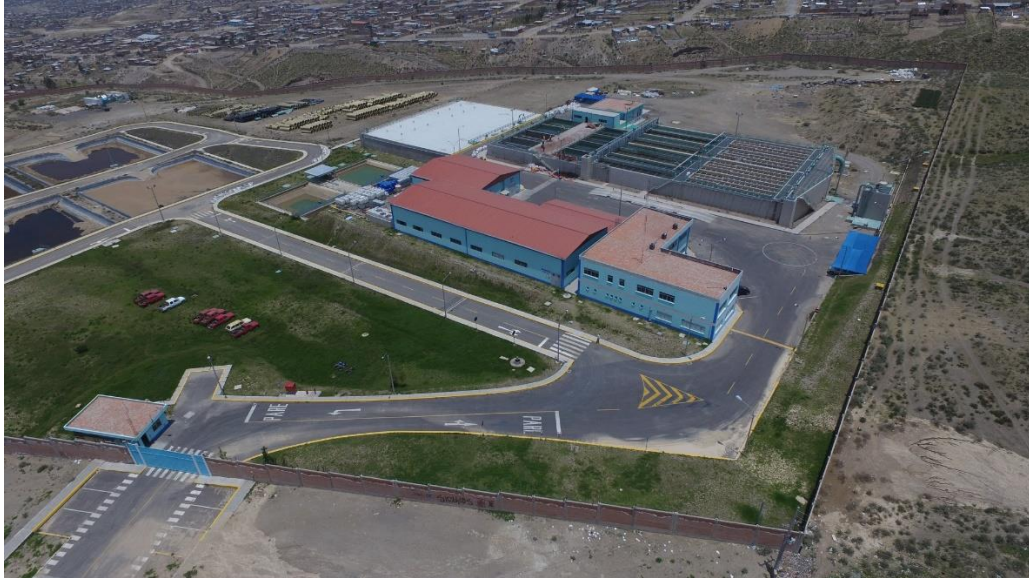
Figura 5. Segunda Planta de tratamiento de agua potable - Miguel de la Cuba
