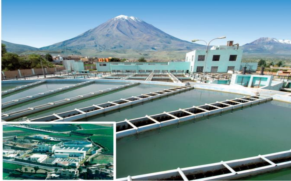
Figura 3. Primera Planta de tratamiento de agua potable - La Tomilla Fuente: Elaboración propia
