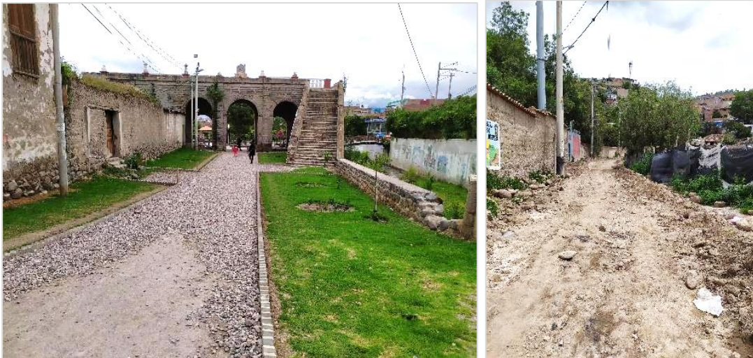
Figura 44 Estado de vías
