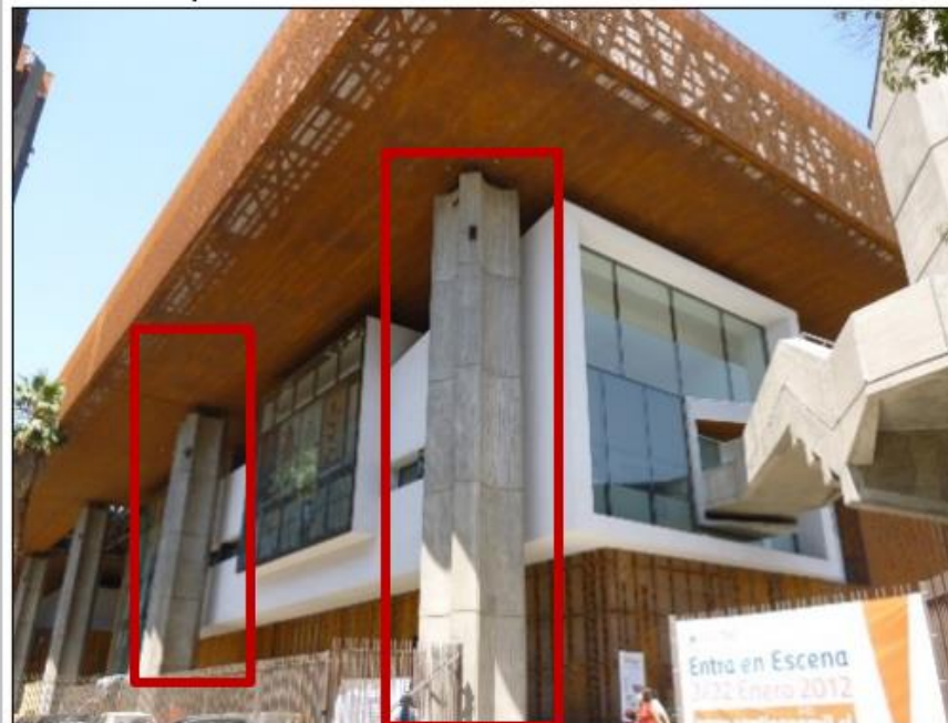
Estructura de Pilares
