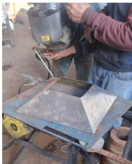
Figura 95. Corte y soldado de las tolvas
